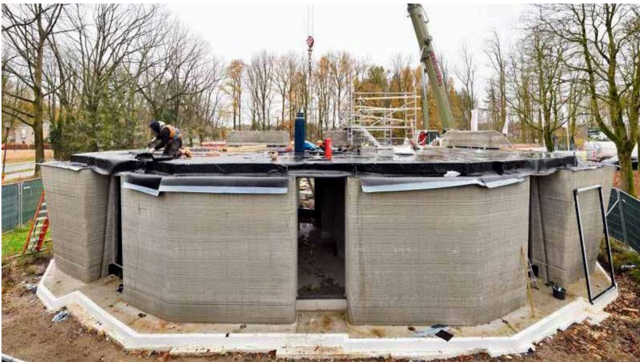
Abb. 14: Montage der vorgefertigten 3-D-Druck Elemente, Milestones © 3dprintedhouse
