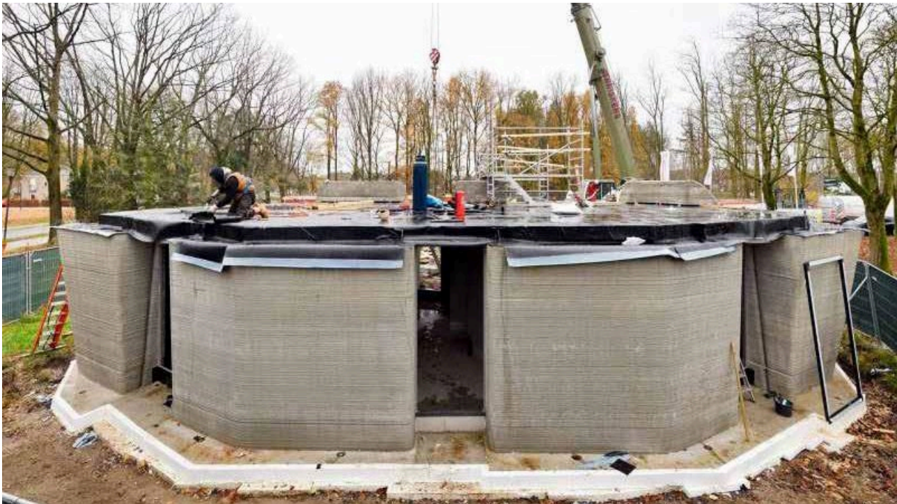
Abb. 14: Montage der vorgefertigten 3-D-Druck Elemente, Milestones © 3dprintedhouse
