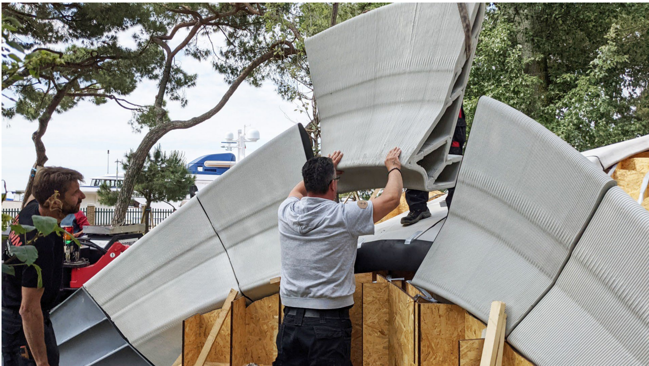
Abb. 13: Modulare Fügung der 3D gedruckten Elemente, Striatus-Brücke, Venedig
