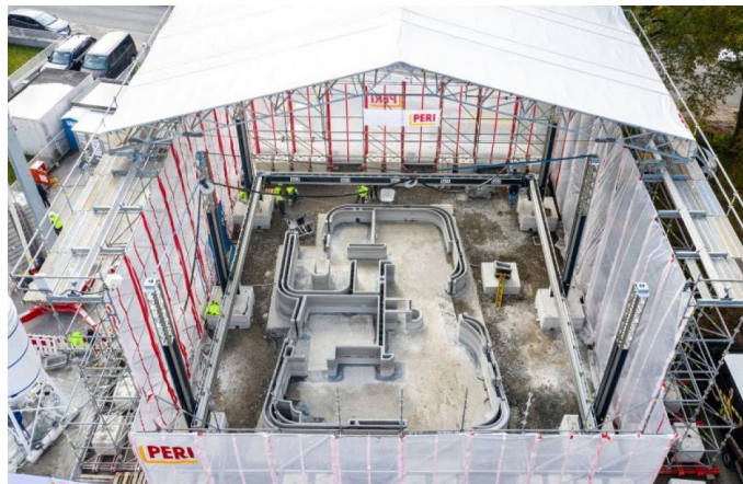
Abb. 12: Herstellungsaufbau des ersten 3-D gedruckten Hauses in Deutschland, Beckum
