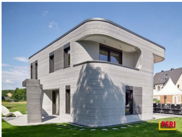
Abb. 12: Herstellungsaufbau des ersten 3-D gedruckten Hauses in Deutschland, Beckum
