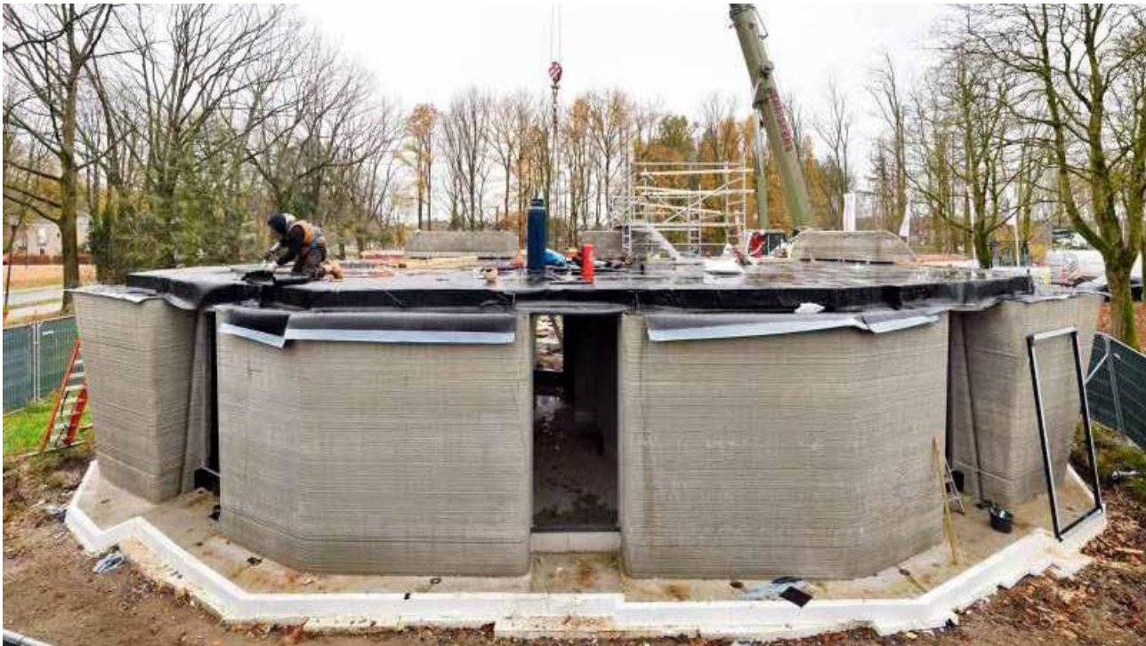
Abb. 14: Montage der vorgefertigten 3-D-Druck Elemente, Milestones © 3dprintedhouse
