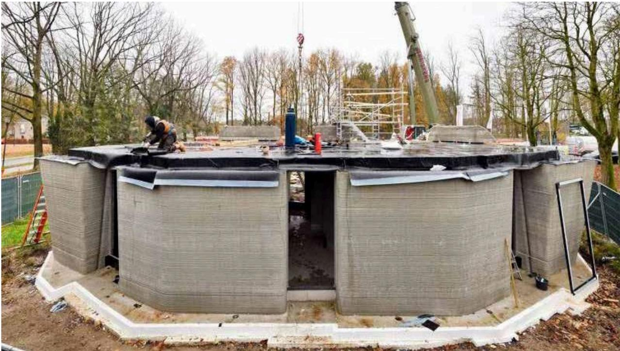
Abb. 14: Montage der vorgefertigten 3-D-Druck Elemente, Milestones © 3dprintedhouse
