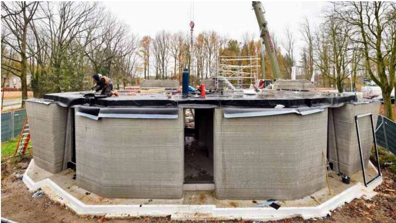
Abb. 14: Montage der vorgefertigten 3-D-Druck Elemente, Milestones © 3dprintedhouse
