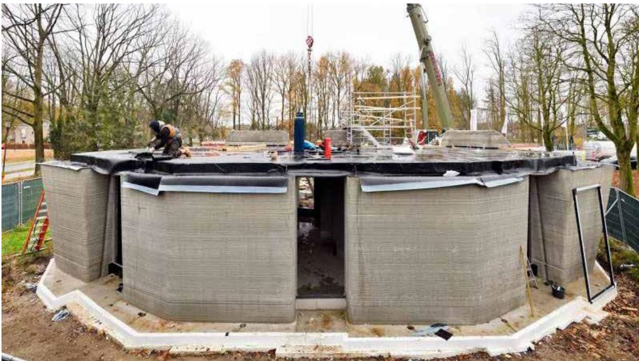
Abb. 14: Montage der vorgefertigten 3-D-Druck Elemente, Milestones © 3dprintedhouse
