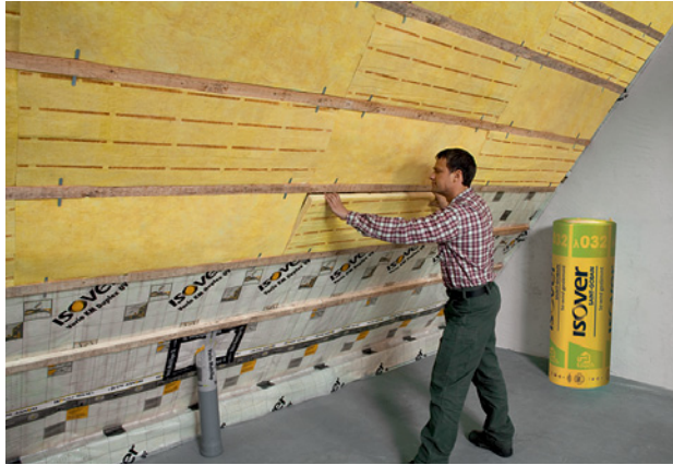
Abb. 1.20 ■ Untersparrendämmung mit Mineralwolle [Quelle: Grünzweig und Hartmann AG]
