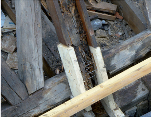
Abb. 2.87 ■ Laschen- und Traufbohlenbefestigung durch Luftnagelung
