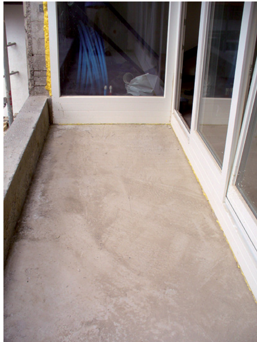
Abb. 2.186 ■ b) Loggia ohne Abflussöffnungen
