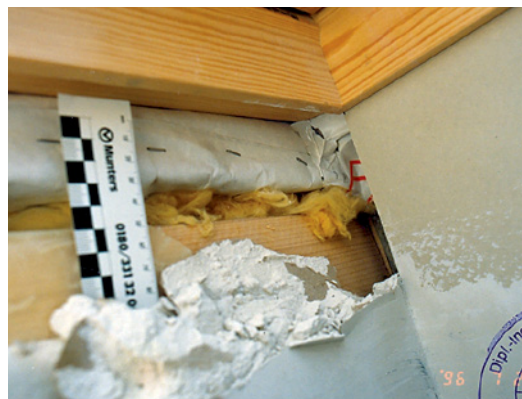
Abb. 2.60 ■ Fehlende Dampfsperre, Teilausstopfung mit Glaswolle
