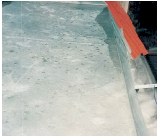
Abb. 2.230 ■ Fensterbankanschluss an Dachflächenfenster
