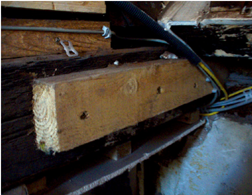
Abb. 2.89 ■ Unzureichende Zuglaschenbefestigung zur Einleitung der Dachlasten in den Deckenbalken mit nur 3 Schrauben
