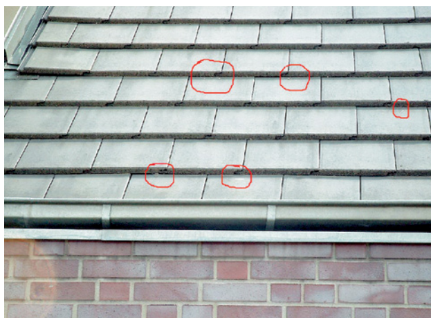
Abb. 2.37 ■ Kalkläufer auf der Dachdeckung
