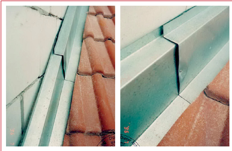
Abb. 2.24 ■ Wandanschlussblechstoß
