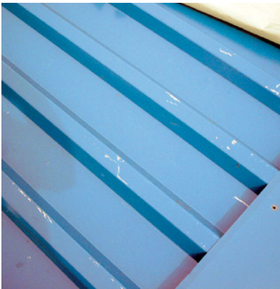
Abb. 2.266 ■ Beschichtungsschäden
