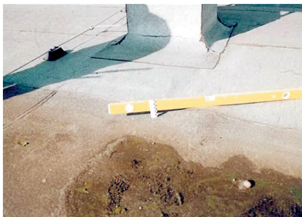
Abb. 2.111 ■ a) Schlammablagerung und Gegengefälle
