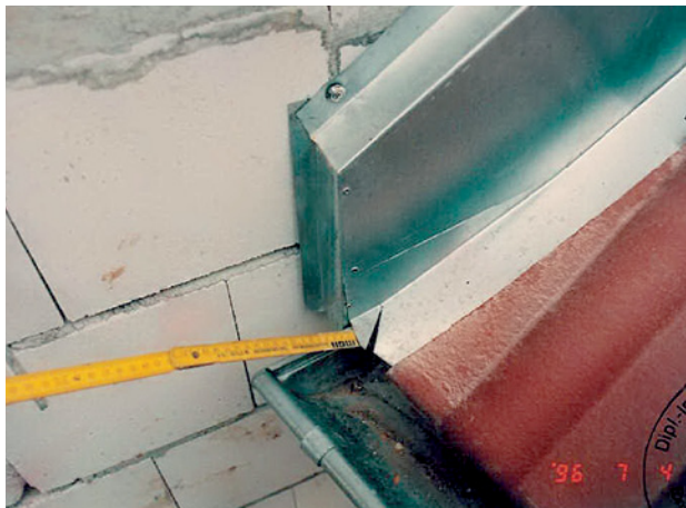
Abb. 2.24 ■ Wandanschlussblechstoß
