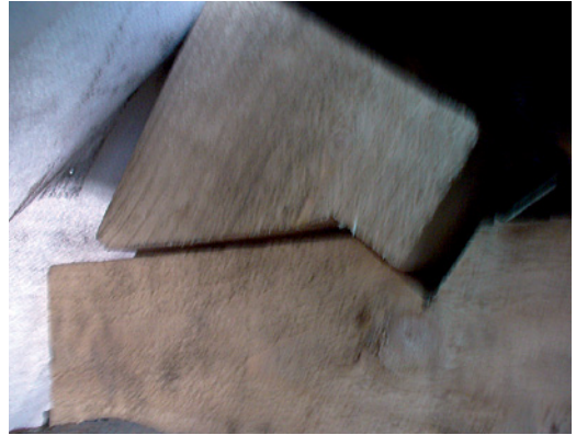
Abb. 2.88 ■ Fersenversatz ohne ausreichenden Kraftschluss
