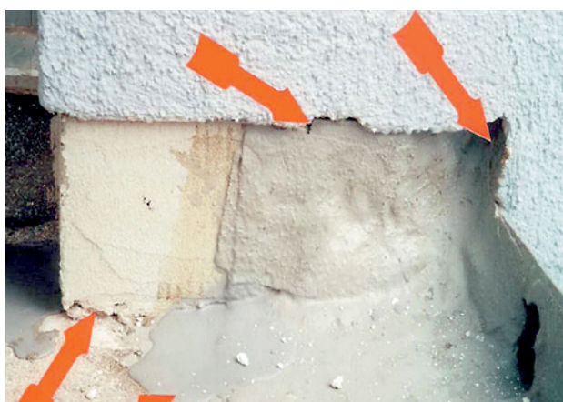
Abb. 2.119 ■ Ausbesserung mit Flüssigabdichtung
