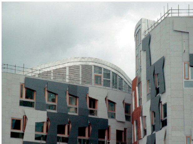
Abb. 2.272 ■ Verbeulte Blechbekleidung
