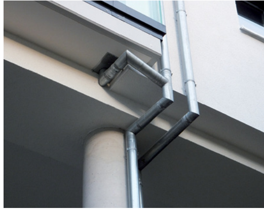
Abb. 2.288 ■ Fallrohrverzüge
