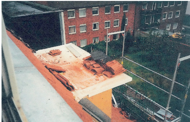
Abb. 2.107 ■ Dachsteinlagerung ohne Schutz
