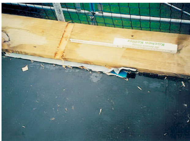
Abb. 2.164 ■ b) Randbohlendetails ohne hochgezogene Vordeckbahn
