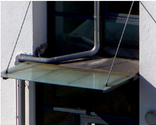
Abb. 2.292 ■ Fallrohrschlange
