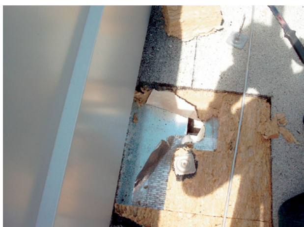
Abb. 2.142 ■ Anschluss der Dampfsperre an bestehendes Gebäude
