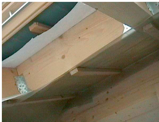
Abb. 2.62 ■ Fehlender Unterspannbahnanschluss an Dachfenster
