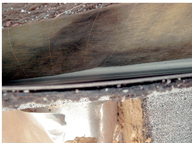
Abb. 2.141 ■ Anschluss der Dampfsperre an Attika
