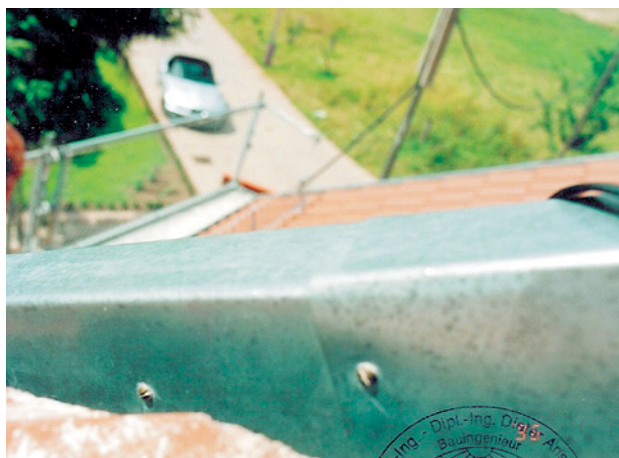
Abb. 2.26 ■ Ortsgangblech- befestigung mit Messingschrauben
