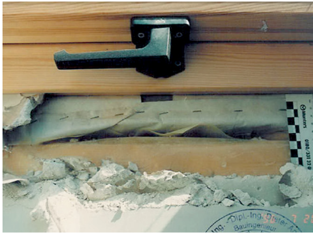
Abb. 2.21 ■ Dachflächenfensteranschluss
