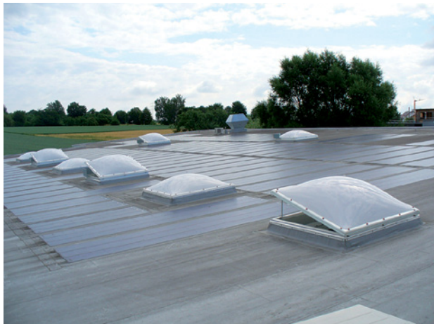
Abb. 1.47 ■ Dachabdichtungsbahn mit integrierten Dünnschicht-Photovoltaikmodulen (Gewerbegebäude Schwaikheim)
