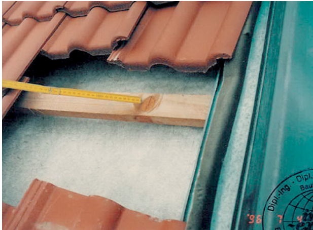
Abb. 2.15 ■ Dachlatte mit durch- gehendem Ast
