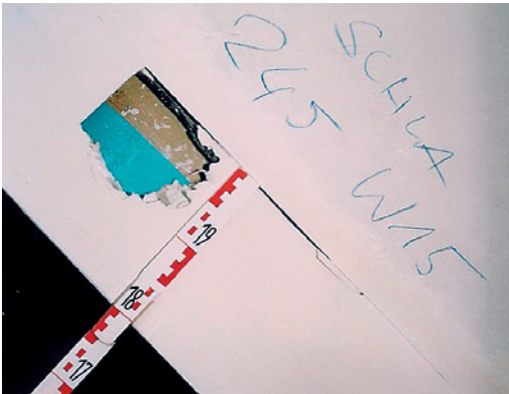
Abb. 2.57 ■ Probeöffnung einer seitlichen Fensterlaibungsbekleidung, fehlende Wärmedämmung und Dampfsperre
