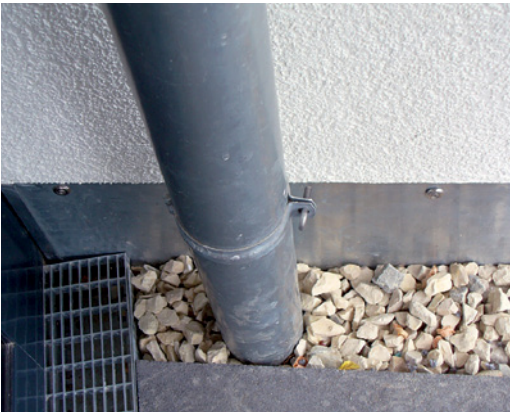
Abb. 2.281 ■ Wasserabläufe in Betonrinne
