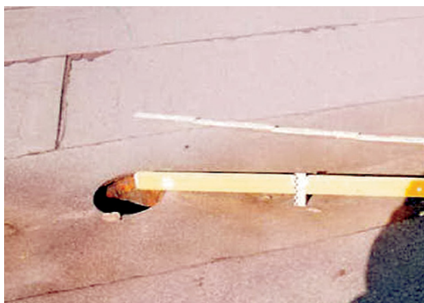
Abb. 2.111 ■ b) Schlammablagerung und Gegengefälle
