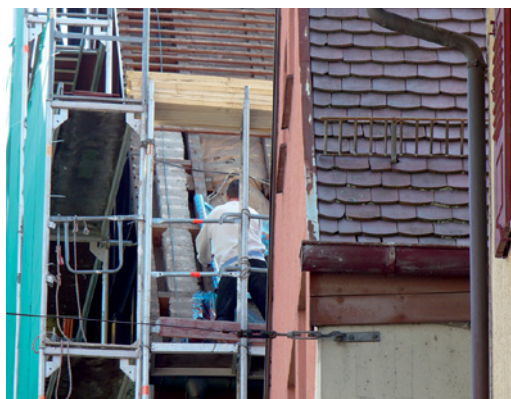
Abb. 2.73 ■ Ungedämmter Nordgiebelwandbereich mit Streichsparren.
