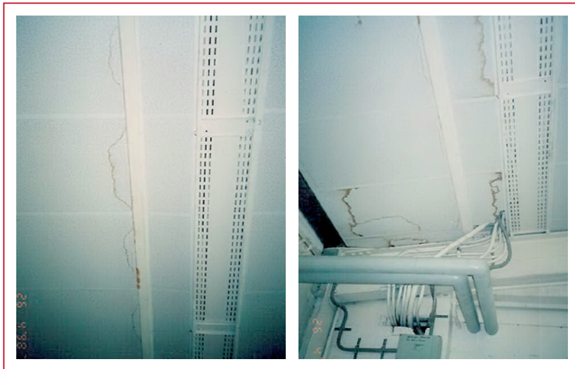
Abb. 2.201 ■ Kondensatfeuchteränder an der Decke
