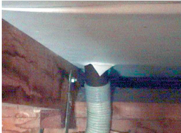
Abb. 2.4 ■ Unter- spannbahndurchdrin- gungsanschluss
