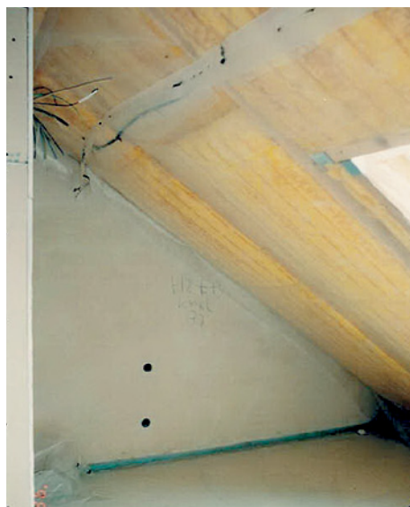
Abb. 2.20 ■ Dampfbremsenstöße
