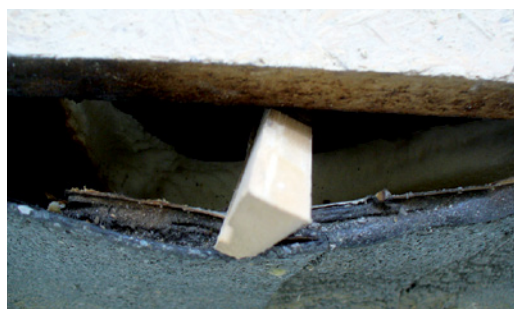
Abb. 2.189 ■ Durch Schweißhitze zerstörte und abgelöste Wärmedämmung
