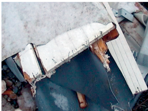
Abb. 2.115 ■ Dachüberstandsschalung mit Schalungsklammern
