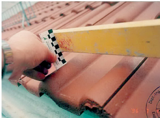
Abb. 2.10 ■ b) Durchbiegung der Dachdeckung
