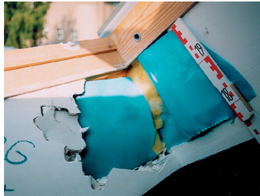
Abb. 2.58 ■ »Luftdichter« Fensteranschluss bei Mehrfamilienhaus
