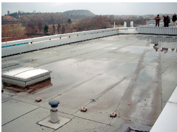
Abb. 2.145 ■ Pfützenbildung nach Beendigung der Flutung
