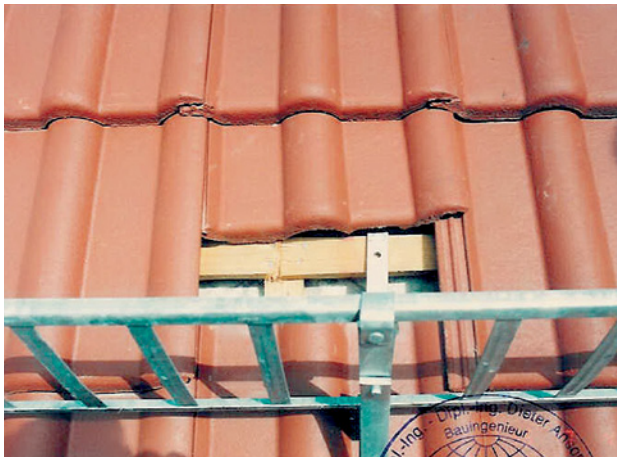
Abb. 2.16 ■ Schneefanggitter- befestigung
