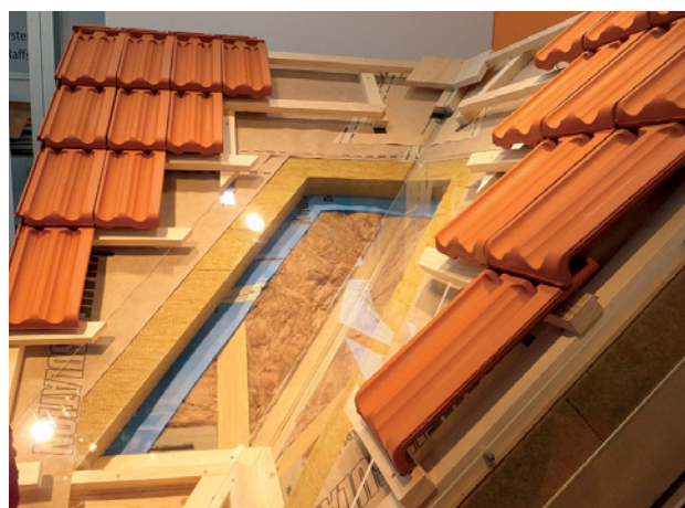
Abb. 1.23 ■ Aufdachdämmung mit Mineralwolle
