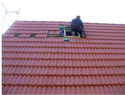
Abb. 2.92 ■ Neue Dachdeckung
