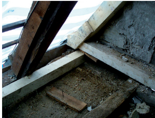
Abb. 2.84 ■ Neue Zusatzschwelle ohne statische Sicherung. Fehlende Zuglaschenbefestigung zur Einleitung der Dachlasten in den Deckenbalken
