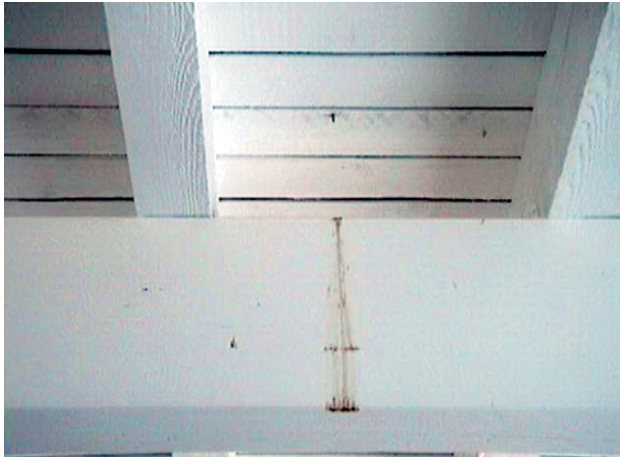
Abb. 2.158 ■ Wasserablaufspuren
