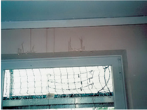
Abb. 2.162 ■ Wassertropfen, die aus der Decke tropfen
