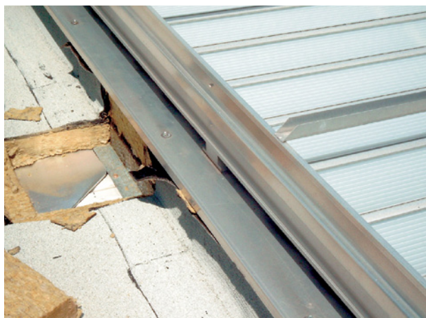
Abb. 2.140 ■ Anschluss der Dampfsperre an Rauchabzugsanlage
