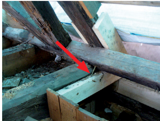
Abb. 2.86 ■ Befestigungsdetail ohne kraftschlüssige Verbindung (Schraube: roter Pfeil)
