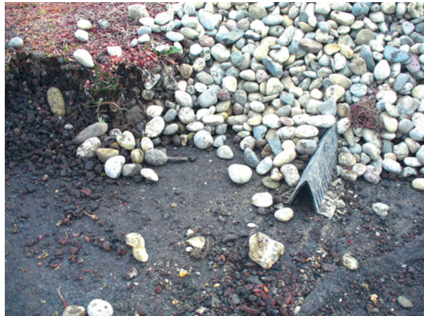
Abb. 2.177 ■ Ausführung der Kehlrinne
