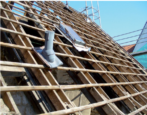
Abb. 2.83 ■ Alte seitliche Sparrenhöhenausgleichsbretter aus dem Jahr 1975
