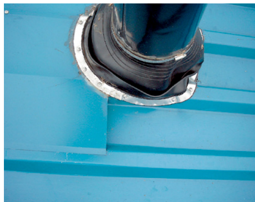
Abb. 2.269 ■ Silikonabdichtung der Schornsteinmanschette
