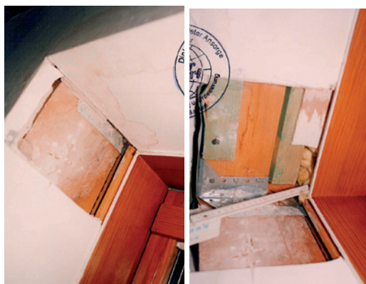
Abb. 2.64 ■ Ursache: fehlende Dampfsperre, keine Wärmedämmung, Winkelverbinder im Kaltbereich
