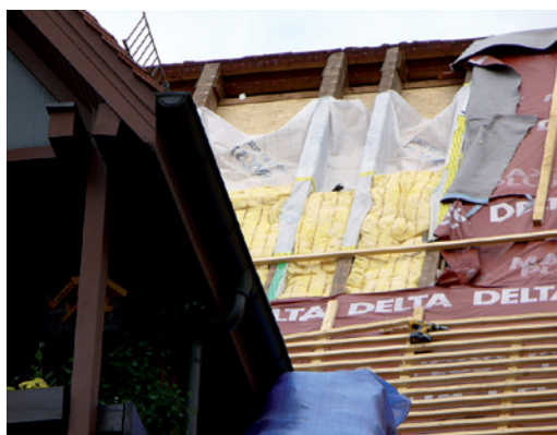
Abb. 2.75 ■ Einbau von Dampfsperre und neuer Wärmedämmung
