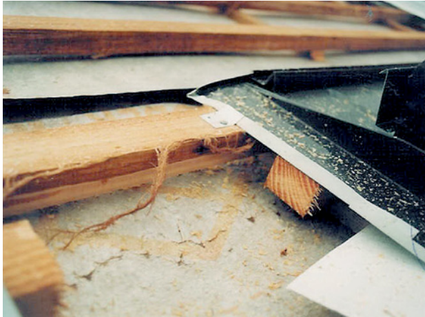
Abb. 2.17 ■ Dachflächenfenster- anschluss
