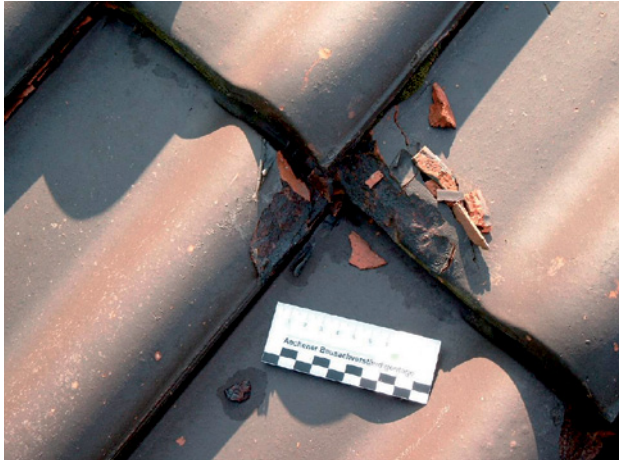
Abb. 2.50 ■ Nachengobierte Dachziegel mit Frostschäden
