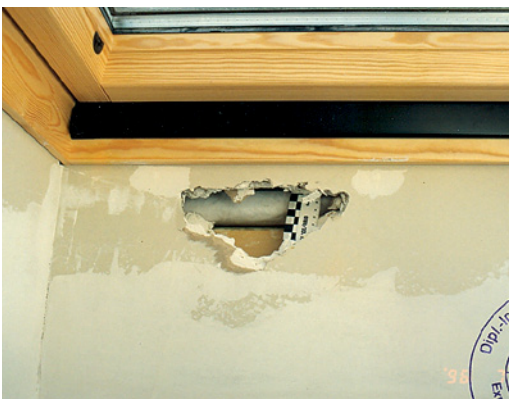
Abb. 2.59 ■ Kleine Brüstungsöffnung nach Klopfprobe mit hellem Klang, fehlende Luftdichtheitsschicht und Wärmedämmung
