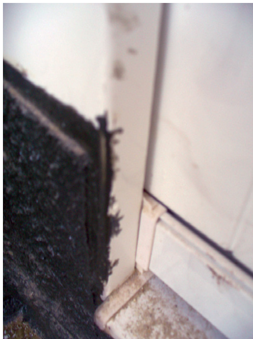
Abb. 2.187 ■ Vertikalabdichtung an Loggiatür
