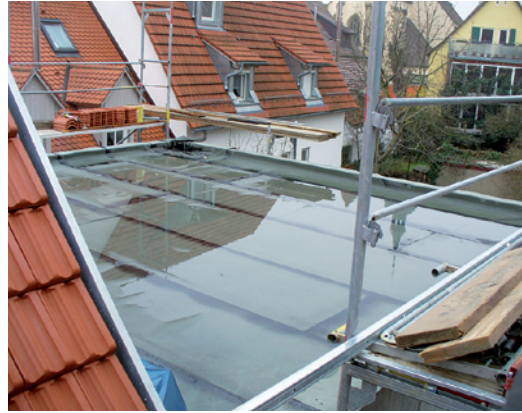
Abb. 2.180 ■ Dauerwasserstand nach Regen
