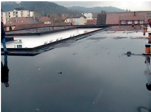
Abb. 2.159 ■ Blick über die Seen auf der Dachfläche
