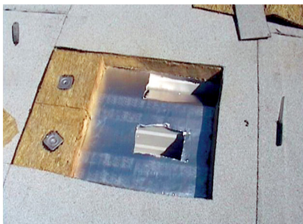
Abb. 2.126 ■ Geöffneter Dachaufbau
