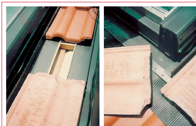
Abb. 2.14 ■ Schnittlinkbefestigung mit Drahtstift
