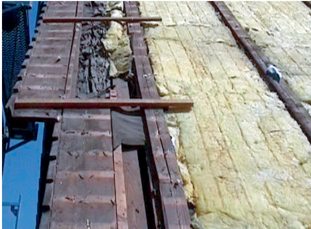
Abb. 2.29 ■ Fehlen- de Wärmedämmung
