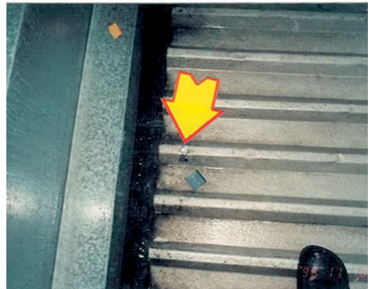
Abb. 2.208 ■ Trapezblechbefestigungsdetail
