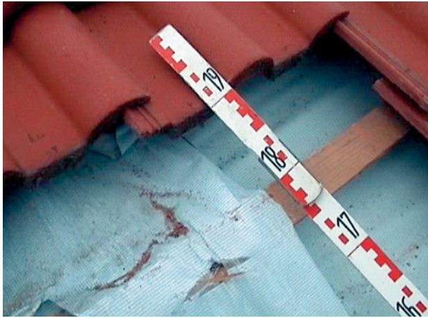
Abb. 2.34 ■ Oberer Unterspannbahnanschluss
