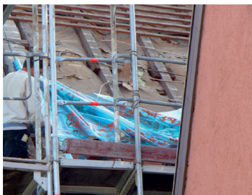
Abb. 2.74 ■ Anschlussmängel der Wärmedämmung an die Kehlzangen
