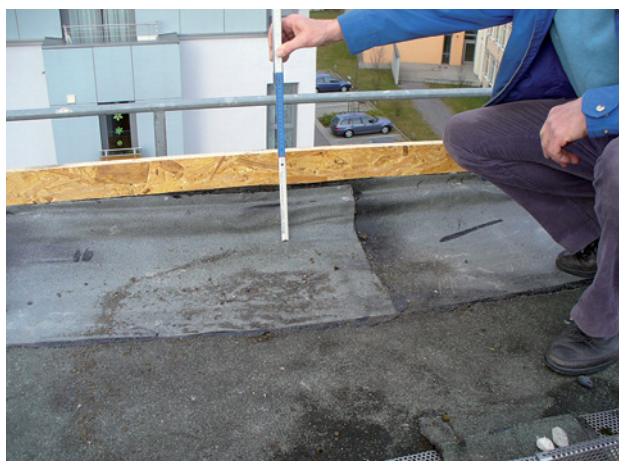
Abb. 2.169 ■ Dachranderhöhung am Kehlrippenende
