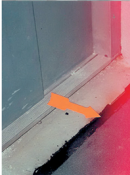
Abb. 2.122 ■ Abdichtungsanschluss an Fahrstuhltür
