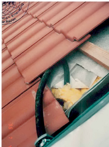
Abb. 2.12 ■ Kollektorleitungsdurchführung
