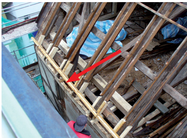
Abb. 2.99 ■ Trauflatte als Widerlager der Wärmedämmung
