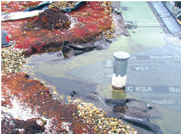
Abb. 2.173 ■ Pfützenbildung am Kehlrinnenende trotz Gefällekeil
