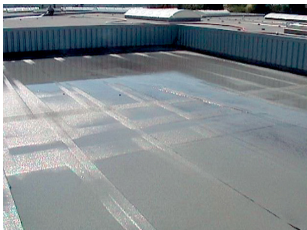
Abb. 2.129 ■ Überflutetes Flachdach
