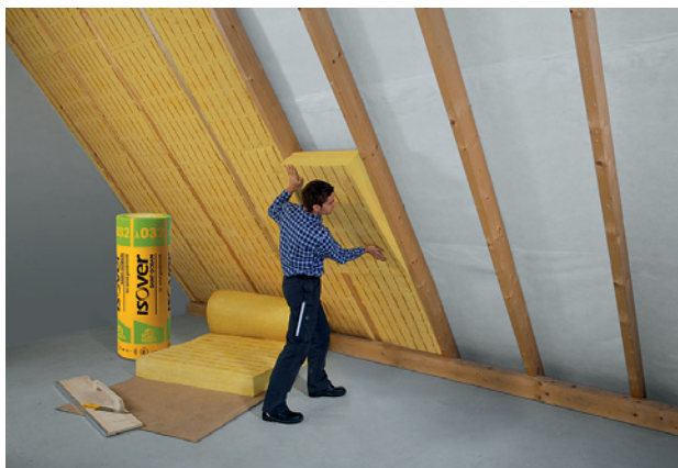
Abb. 1.21 ■ Zwischensparrendämmung mit Mineralwolle [Quelle: Grünzweig und Hartmann AG]
