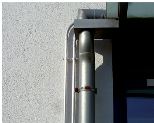
Abb. 2.295 ■ Ablaufrohr mit Gegengefälle
