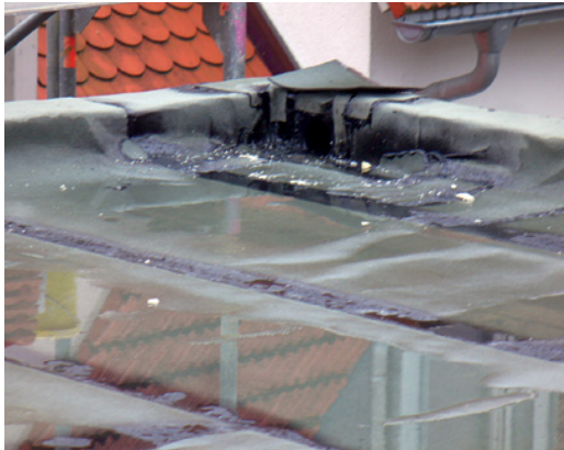
Abb. 2.181 ■ Über dem Höchstwasserstand liegender Dachablauf
