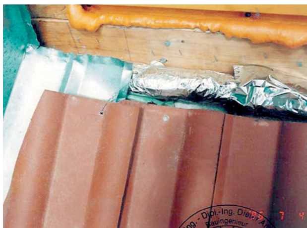
Abb. 2.13 ■ Schnittlinkbefestigung mit Draht
