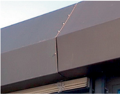
Abb. 2.246 ■ Blechverbindung
