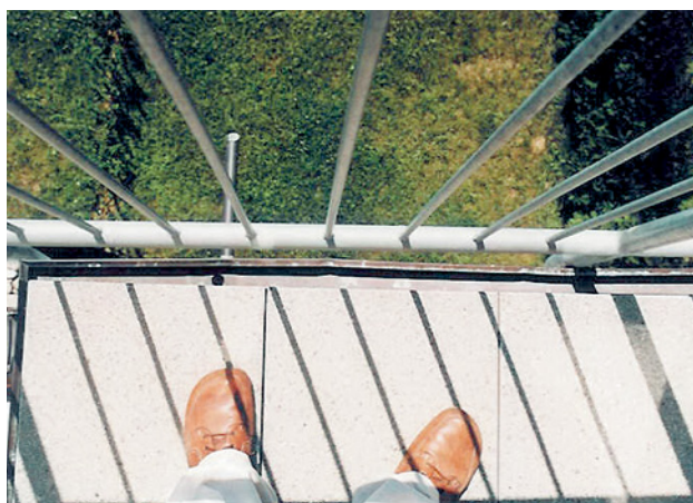
Abb. 2.235 ■ Balkonentwässerung – verdrückte Rinne
