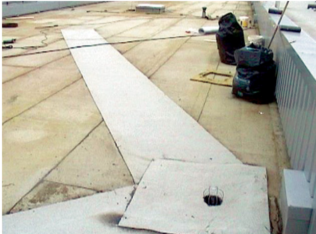
Abb. 2.131 ■ Entwässerungsrinne (Endzustand)
