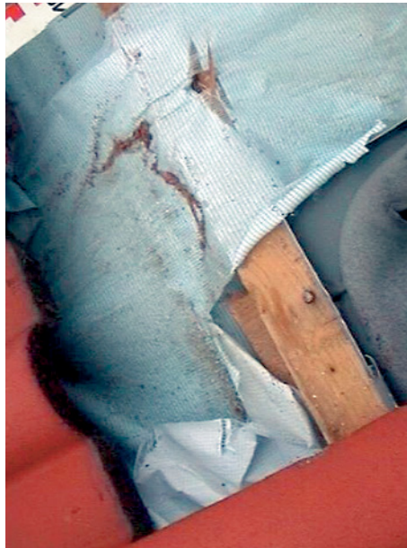
Abb. 2.35 ■ Seitlicher Unterspannbahnanschluss mit Wasserableitung
