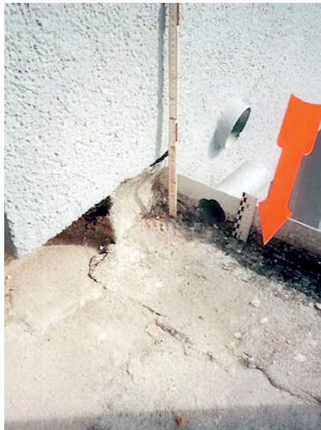
Abb. 2.117 ■ Balkonabdichtung mit Wasserspeier
