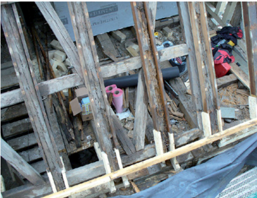
Abb. 2.85 ■ Neue Sparrenbefestigungen an Deckenbalken
