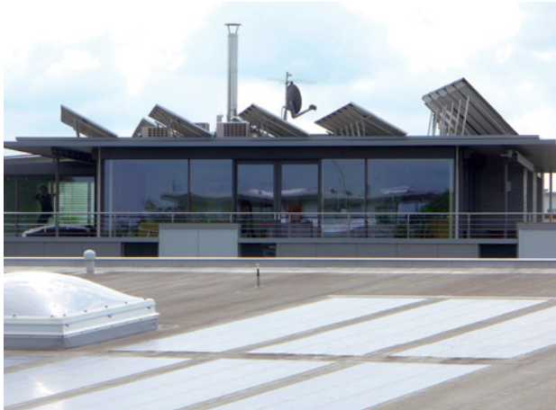
Abb. 1.27 ■ Optischer Gebäude- schaden durch fehl- geplante Solarmodule
