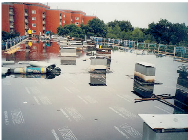
Abb. 2.163 ■ Wasserstand auf der Dachfläche
