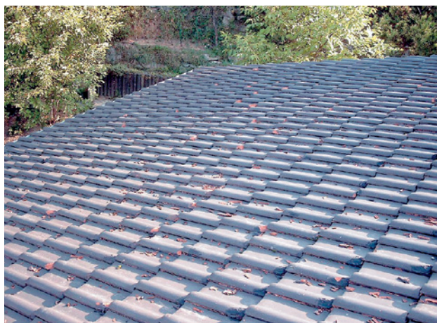
Abb. 1.11 ■ Frostschäden an engobierten Dachziegeln
