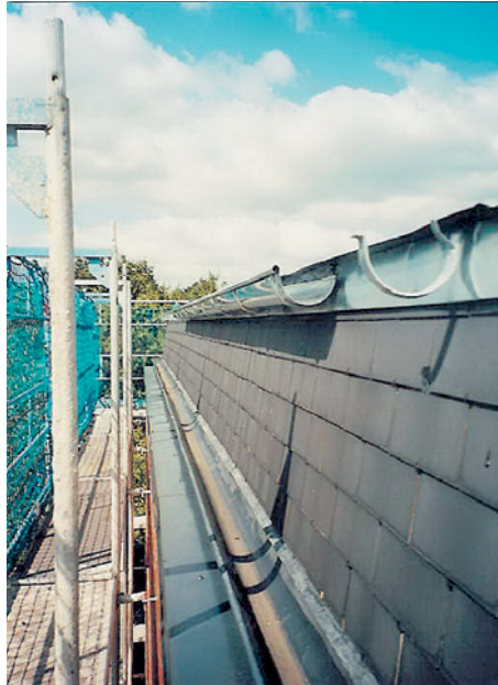
Abb. 2.165 ■ Neue Dachrinne, Faserbetonplattenbekleidung und alte Rinne
