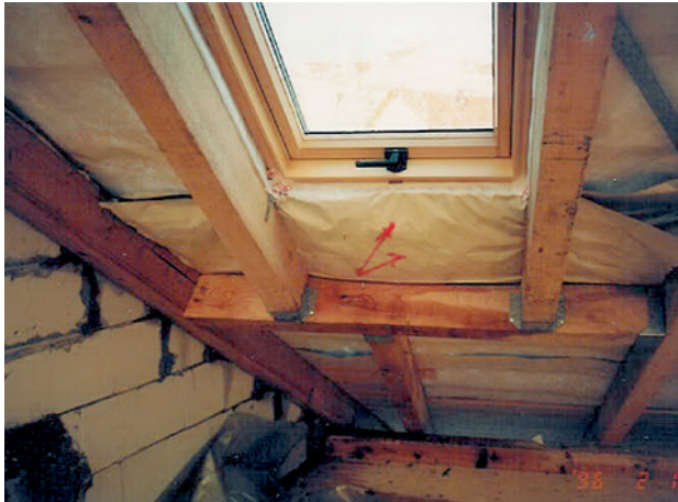
Abb. 2.18 ■ Unterspannbahnstoß
