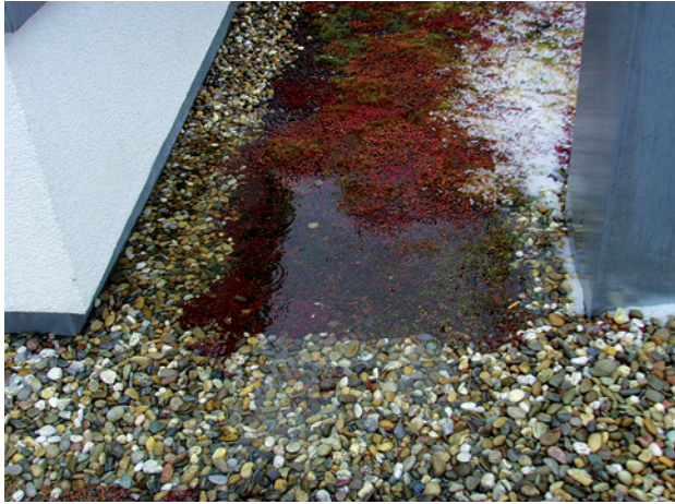
Abb. 2.172 ■ Dauerwasserstand in der Kehlrinne
