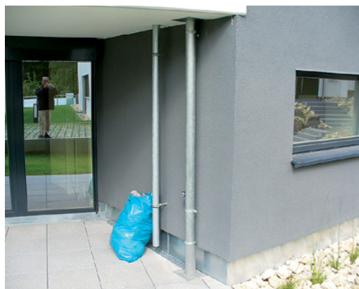
Abb. 2.284 ■ Balkonentwässerung auf eine Terrasse im Erdgeschoss
