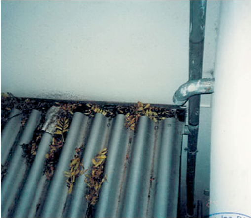
Abb. 2.224 ■ Laubengangentwässerung
