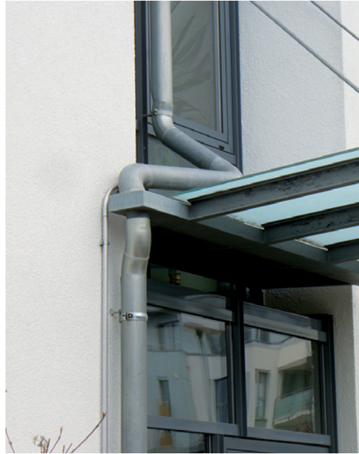
Abb. 2.291 ■ Fallrohrschlange
