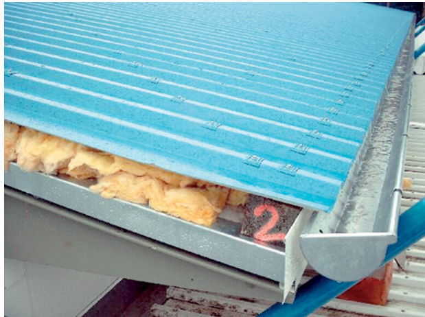
Abb. 2.254 ■ Ortgang mit Wärmedämmung
