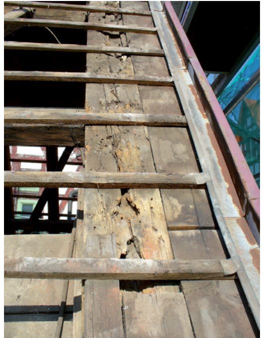
Abb. 2.90 ■ Giebel sparren mit alter Ortgangschalung
