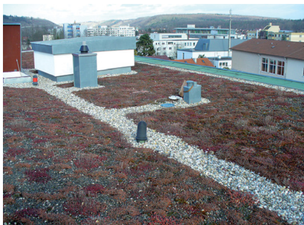
Abb. 1.13 ■ Begrünte Dachabdichtung
