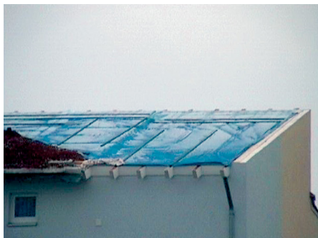
Abb. 2.112 ■ Vom Orkan abge- deckte Dachfläche
