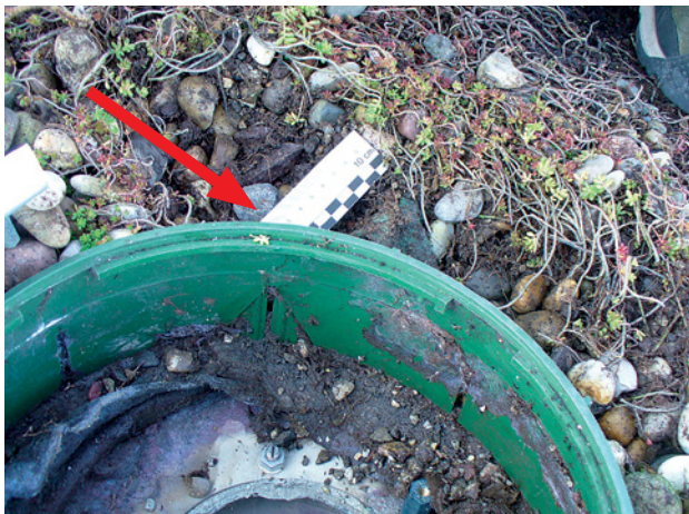
Abb. 2.174 ■ Kombischacht ohne Triangelwasserleite- mentanschluss (Leitelementende: roter Pfeil)
