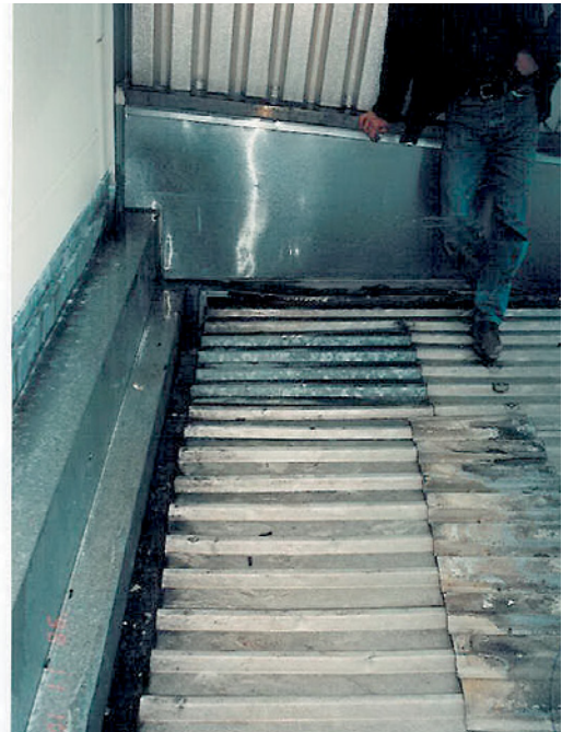
Abb. 2.206 ■ Ausgebesserte Dachdeckung
