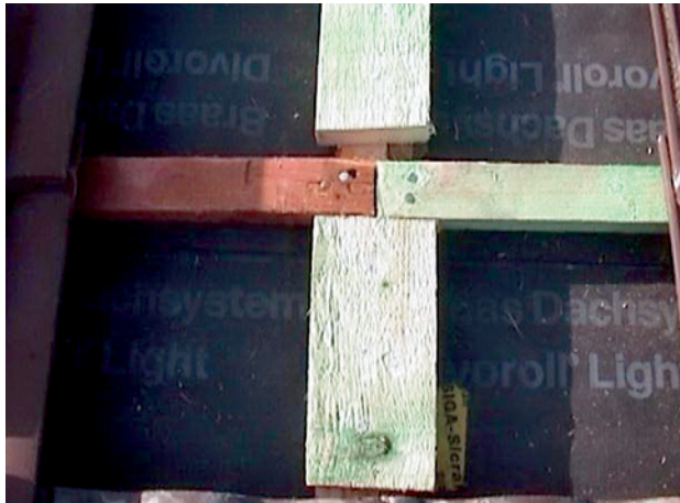
Abb. 2.5 ■ Brettlaschen unter Lattenstoß
