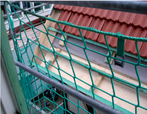
Abb. 2.93 ■ Bretter als neue Aufschieblinge
