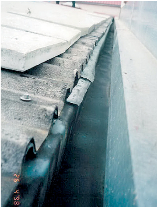
Abb. 2.205 ■ Rinnenanschlussdetail
