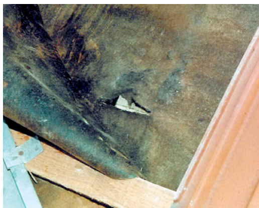
Abb. 2.241 ■ Dachdeckungsanschluss mit Unterspannbahn
