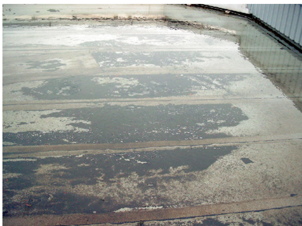
Abb. 2.144 ■ Geflutete Dachfläche
