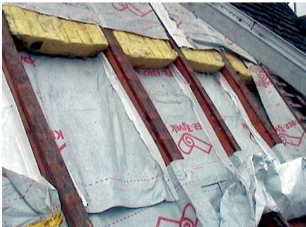
Abb. 2.30 ■ Wärme- dämmung und Luft- dichtheitsbahn
