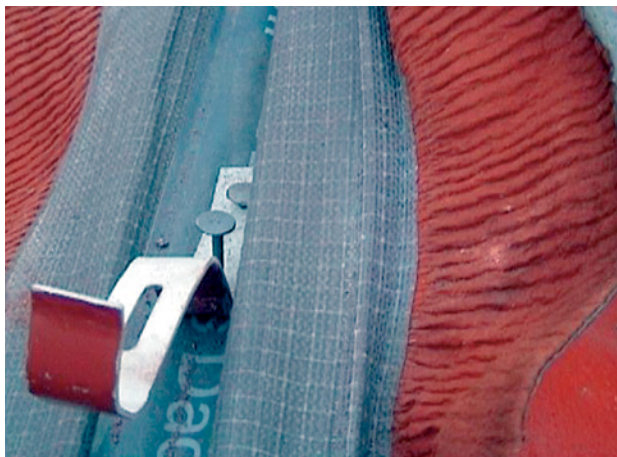
Abb. 2.43 ■ Firstklammer und Nagelung
