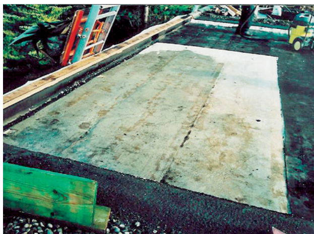
Abb. 2.150 ■ Wasser auf der Rohdecke unter der Dampfsperre (Foto: Volkert)
