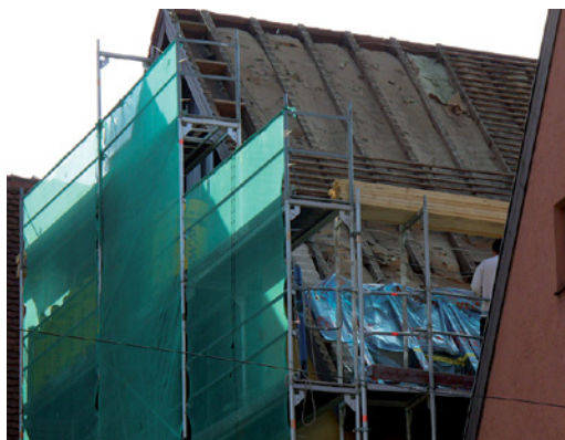
Abb. 2.71 ■ Westliche Dachfläche: Teilfreigelegte Dachdämmung
