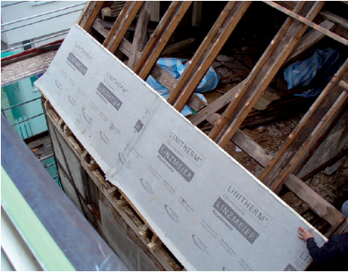
Abb. 2.91 ■ Aufsparrendämmung
