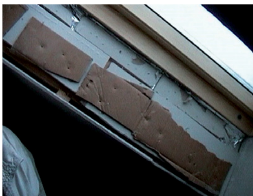
Abb. 2.65 ■ Restverwertung bei einer Dachfensterlaibung: Durch Nagelungen perforierte Dampfbremse, fehlende Wärmedämmung in der Fensterlaibung
