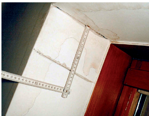
Abb. 2.63 ■ Dachfensterlaibung mit nach über 10 Jahren aufgetretenen Feuchterändern
