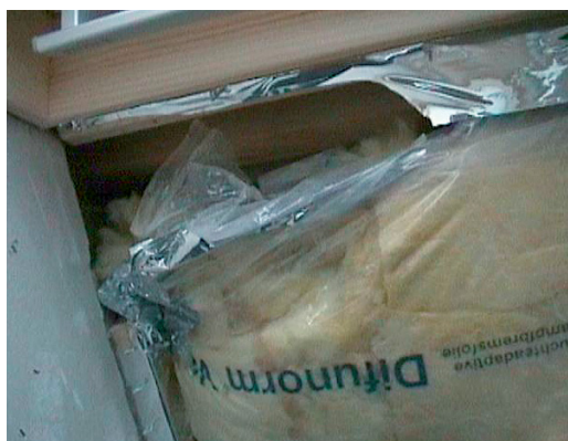
Abb. 2.66 ■ Mit untauglichem Alu-Klebeband an Dachfenster angeschlossene adaptive Dampfbremse. Abriss durch drückende Mineralwollgedämmung
