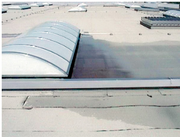
Abb. 2.127 ■ Wasserstau neben Lichtkuppel
