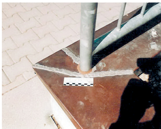
Abb. 2.231 ■ Geländerdurchdringung, Mauerabdeckung mit Geländer
