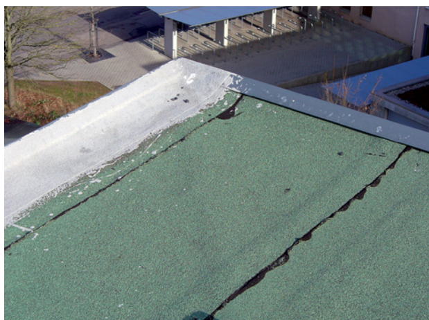
Abb. 2.170 ■ nachträglich abge- dichtete Dachränder vor Dachranderhö- hungen
