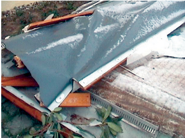
Abb. 2.114 ■ Mechanische Dachfo- lienbefestigung
