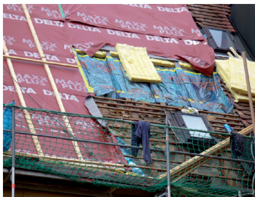
Abb. 2.70 ■ Dämmung, Unterspannbahn und Lattungen vor der Wiedereindeckung
