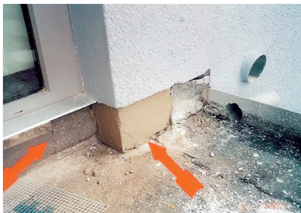
Abb. 2.118 ■ Abdichtungs-fenster- anschluss, WDVS
