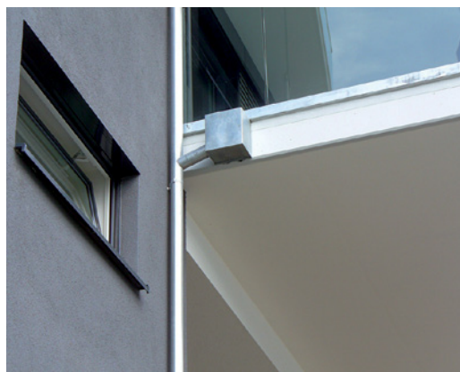
Abb. 2.283 ■ Seitlicher Wasserkasten als Balkonablauf
