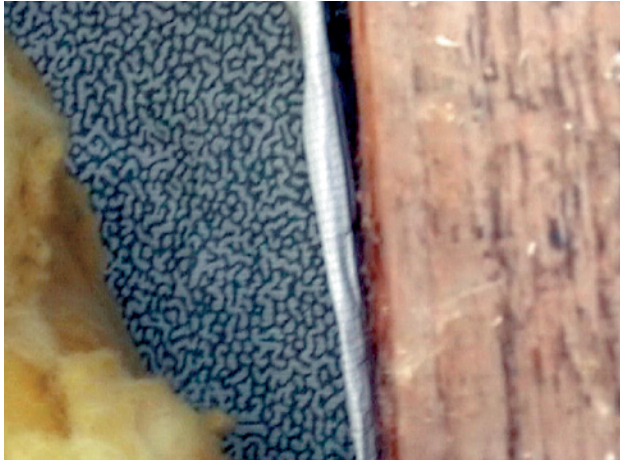
Abb. 2.28 ■ Undichter Luftdichtheitsbahnanschluss
