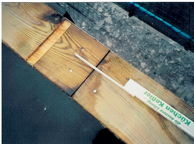
Abb. 2.164 ■ a) Randbohlendetails ohne hochgezogene Vordeckbahn
