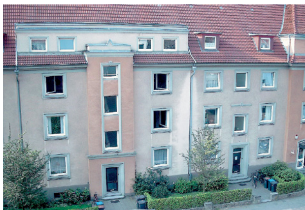
Abb. 2.249 ■ Nordfassade mit Wasserablaufspuren
