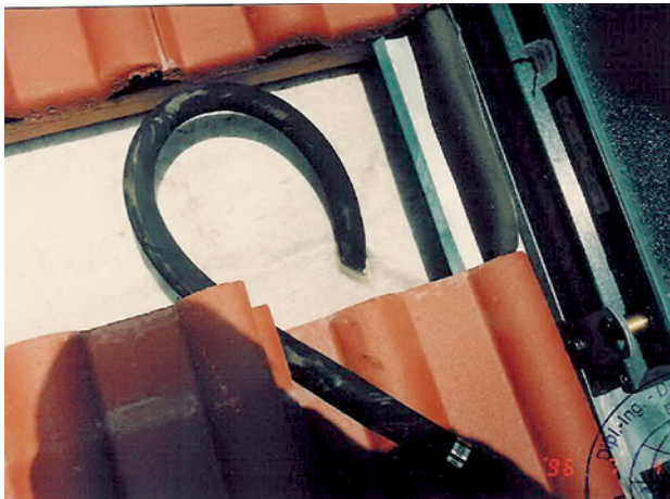
Abb. 2.19 ■ Schnee- fanggitterbefestigung
