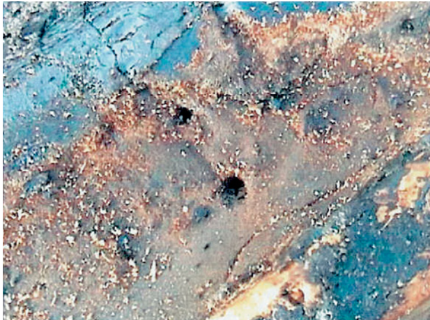
Abb. 2.153 ■ Perforierte Haustrennfugenabdichtung
