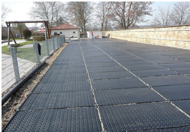
Abb. 1.28 ■ Schlauchkollektor zur Schwimmbadbehei- zung (Quelle: Stadt Sach- senheim Tiefbauamt)
