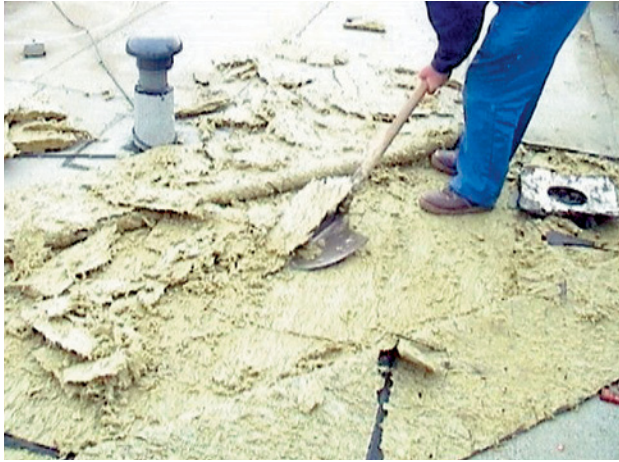
Abb. 2.130 ■ Entwässerungs- rinnenherstellung
