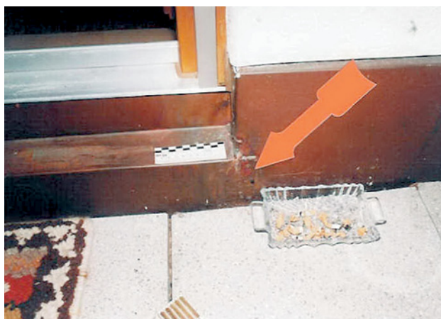
Abb. 2.234 ■ Türschwelle – Nietver- bindung mit Loch
