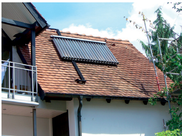
Abb. 1.30 ■ Röhrenkollektor
