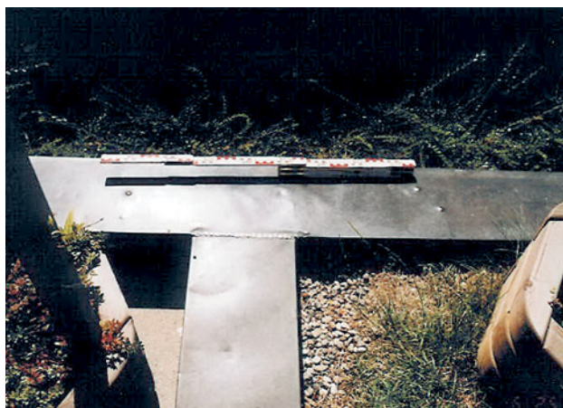
Abb. 2.233 ■ Blechverbindung – T-Stück mit Schrau- benabdrücken
