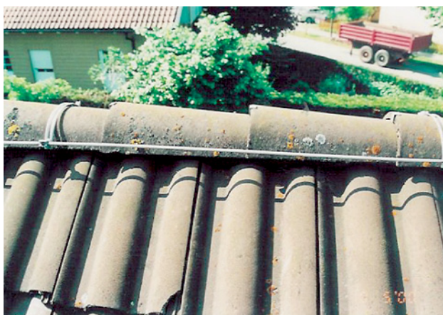
Abb. 2.2 ■ Abgerutschte Dachdeckung
