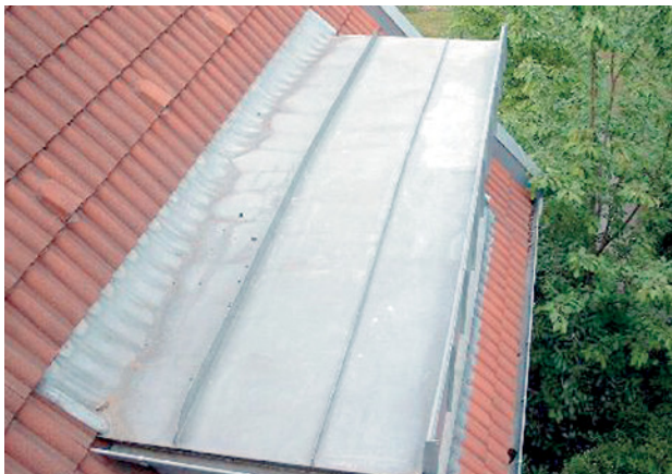
Abb. 2.196 ■ Blick auf die Dachgaubendeckung
