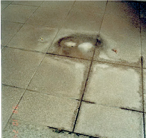
Abb. 2.226 ■ Stalakmitenbildung unter Fallrohrende
