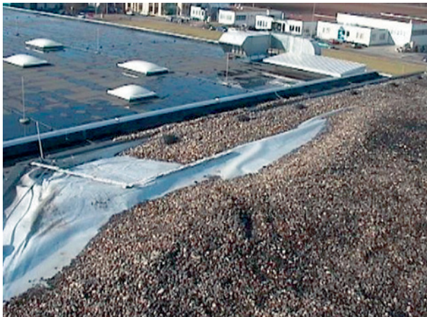
Abb. 2.101 ■ Abgehobene Abdichtungsbahn
