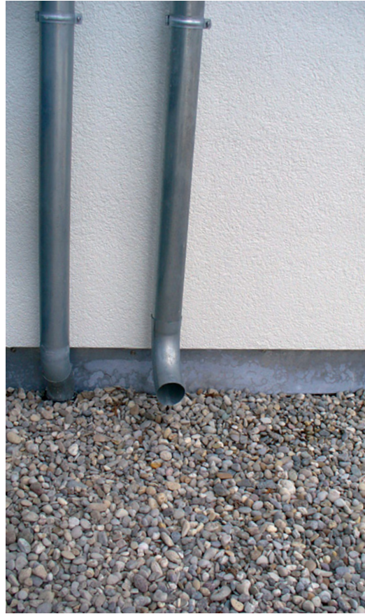
Abb. 2.280 ■ Fallrohre über Vordach
