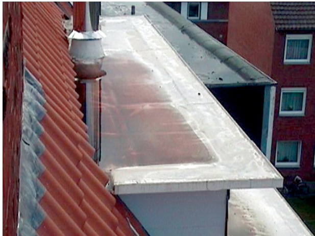
Abb. 2.104 ■ Gebäudedachfläche mit starkem Dauer- wasserstand und Ablagerungen
