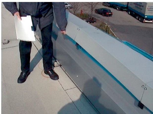
Abb. 2.137 ■ Attikaverkleidung über dem Bürotrakt
