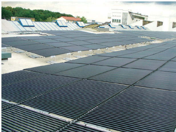
Abb. 1.48 ■ Auf die Abdichtung gestellte Photovoltaik-Röhrenelemente (Fabrikgebäude Korntal)
