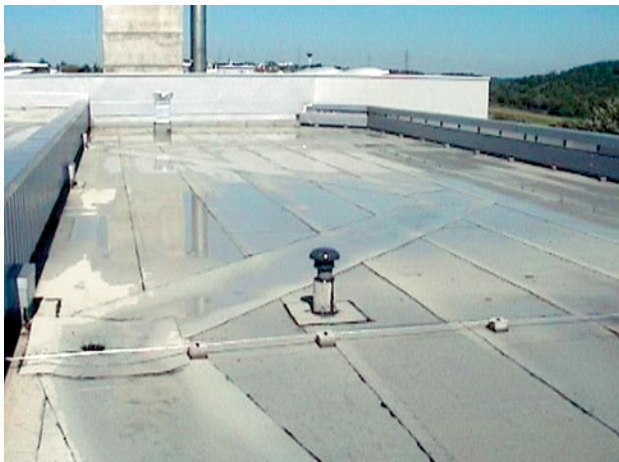
Abb. 2.132 ■ Dauerwasserstand
