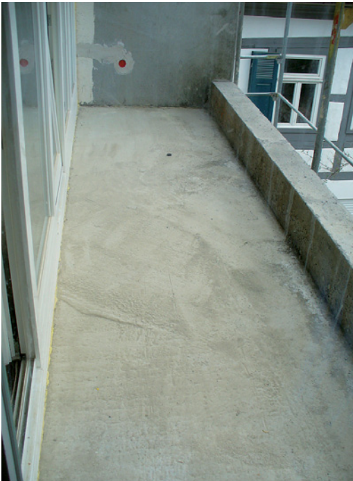
Abb. 2.186 ■ a) Loggia ohne Abflussöffnungen
