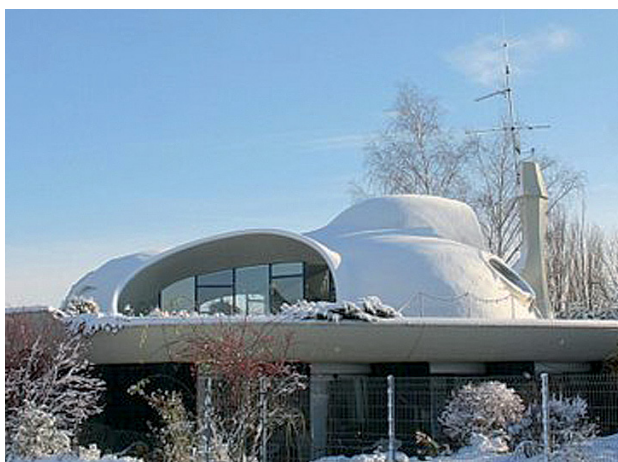
Abb. 1.32 ■ WU-Betondach als Massivkollektor (Haus M. Walz Leinfel- den-Echterdingen)
