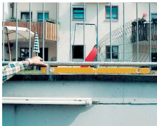
Abb. 2.232 ■ Aufgebeulte Mauerabdeckung
