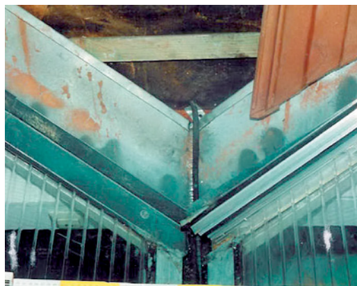
Abb. 2.244 ■ Begleitheizungseinführung
