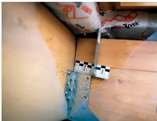
Abb. 2.61 ■ Fehlende Dampfsperre, Wärmedämmung und Fensterbefestigung im Kaltbereich
