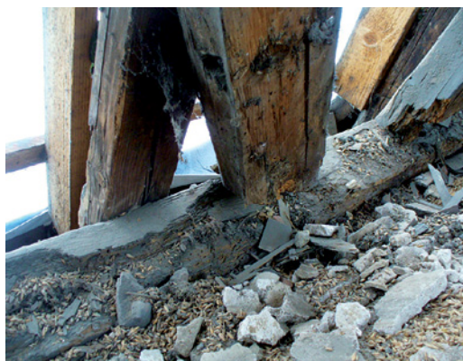
Abb. 2.82 ■ Verfaulte Strebenfußpunkte und Koppelschwelle
