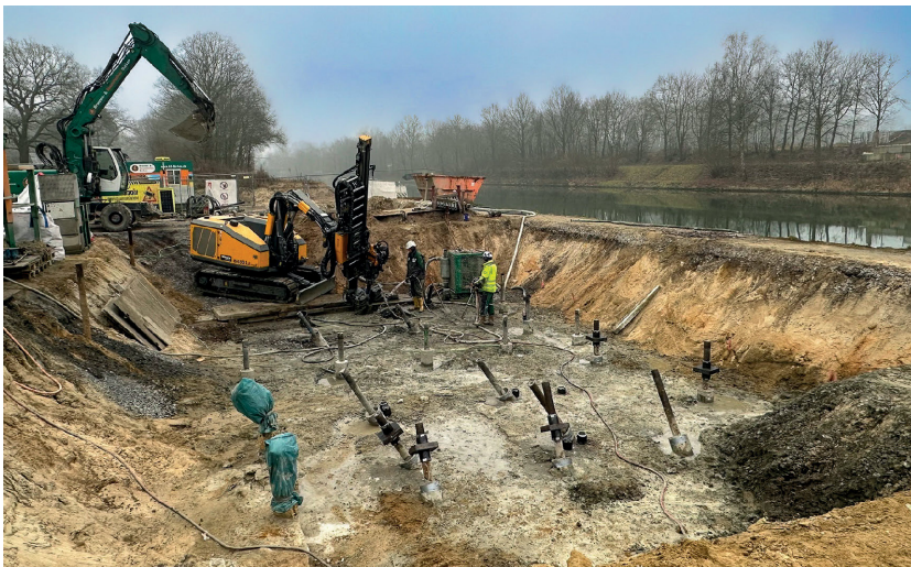
Die Widerlager der neuen Östlicher Brücke wurden mit Mikropfählen in einem statisch optimierten Raster gegründet. Foto: FRIEDR. ISCHEBECK GmbH
