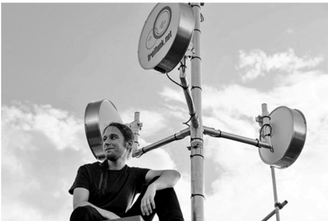
Abbildung 2: Dachinstallation auf dem Deutschen Technikmuseum Berlin
