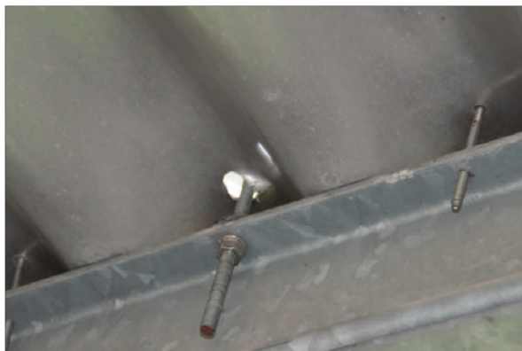
Abb. 7: Unsachgemäße Montage der Unterkonstruktion am Beispiel von Carports/Überdachungen
