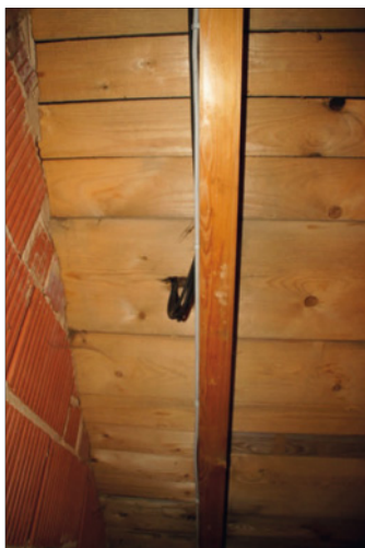
Abb. 10: Nicht fachgerechte Dachdurchführung
