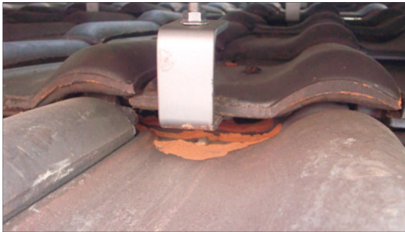
Abb. 3: Entfernung der Verfalzung
