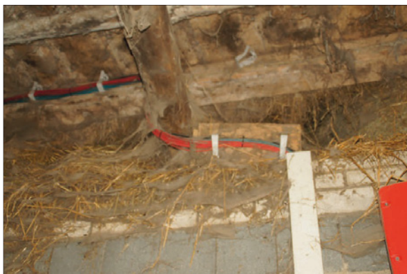
Abb. 13: Unsachgemäße Kabel- und Leitungsführung
