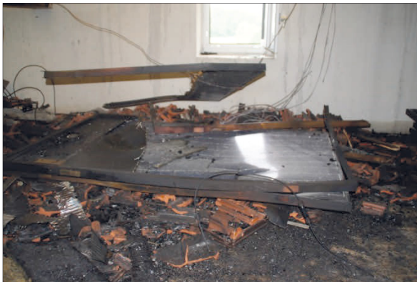
Abb. 9: Brandschaden aufgrund nicht fachgerechter Kabelverlegung
