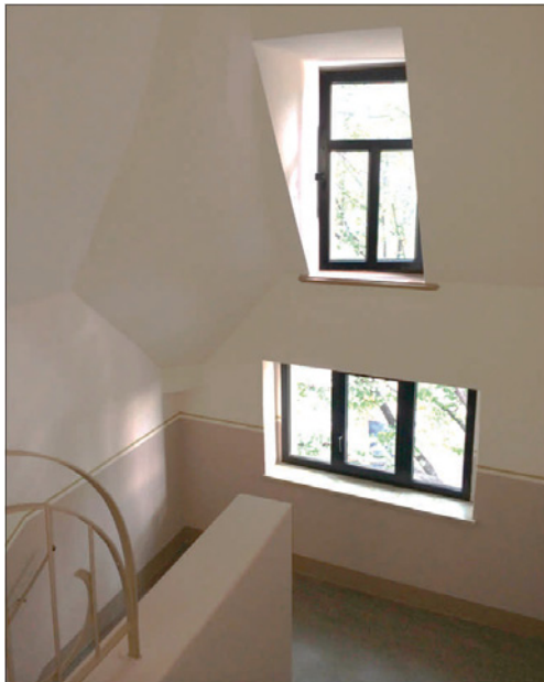
Abb. 3: Selbstöffnender oberer Fensterflügel als Entrauchungsöffnung Treppenraum
