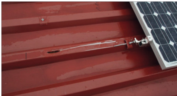
Abb. 2: Ausgerissene Stockschraubenbefestigung durch starke Schneelast
