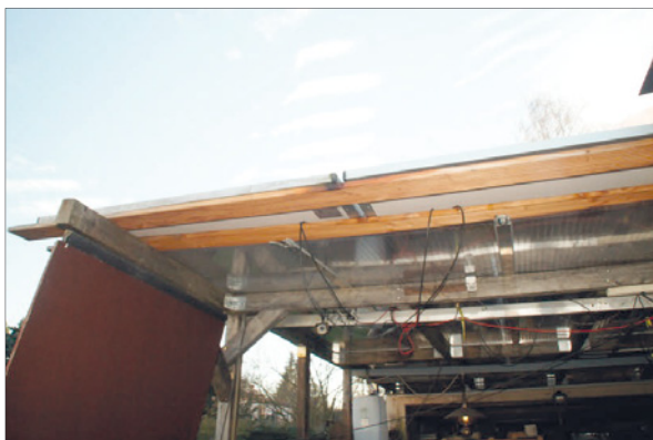
Abb. 12: Unsachgemäße Kabel- und Leitungsführung
