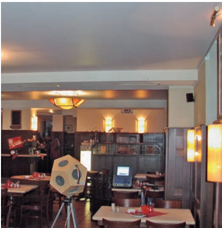
Abbildung 7.24 Gastraum mit schallabsorbierender Folien-Spanndecke
