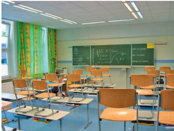
Abbildung 7.5 Klassenraum nach der Optimierung mit vollflächiger Akustikdecke sowie Teilbelegung in den oberen Wandbereichen
