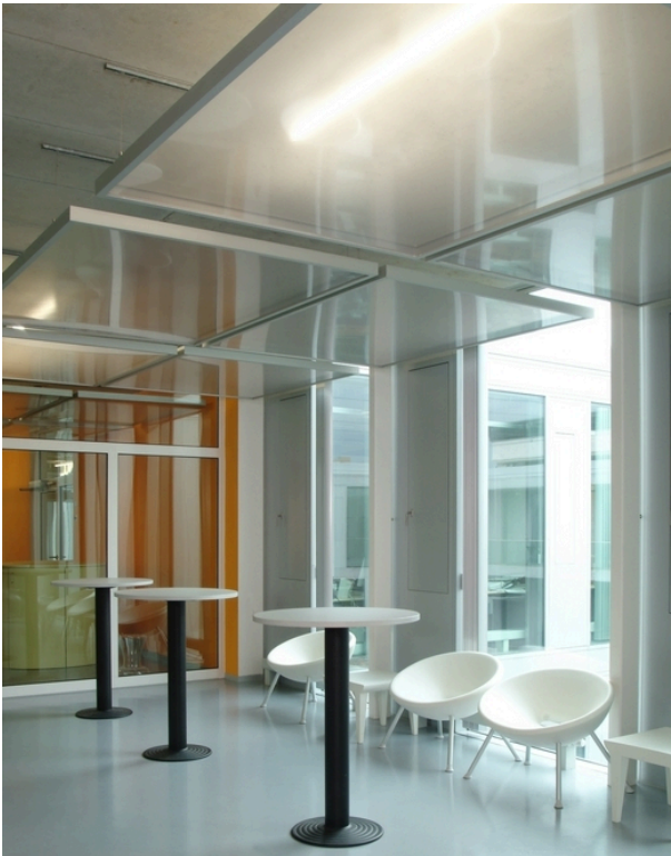
Abbildung 8.5 Mikroperforierte Folienspanndecke in Rahmen [Quelle: BARRISOL S.A.S.]
