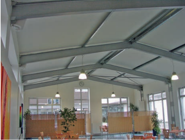
Abbildung 7.22 Kantine nach der Optimierung mit schallabsorbierender Decke mit Akustikputz-System
