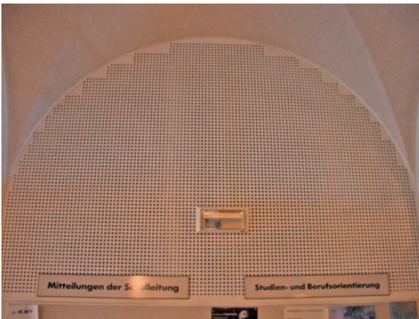
Abbildung 8.6 Akustikputz und weitere Absorberflächen aus gelochtem Gipskarton [Quelle: H. Aleweld, Immobilien Bremen]
