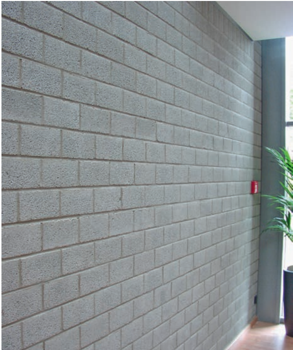
Abbildung 8.1 Wand aus porösen Ziegelsteinen (Mau- erwerk aus Hohllochziegeln, Löcher sichtbar, 60 mm vor Massivwand, HR leer)
