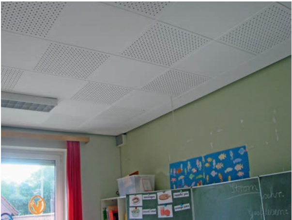
Abbildung 8.4 Gelochte Gipskarton-Decke als Rasterdecke
