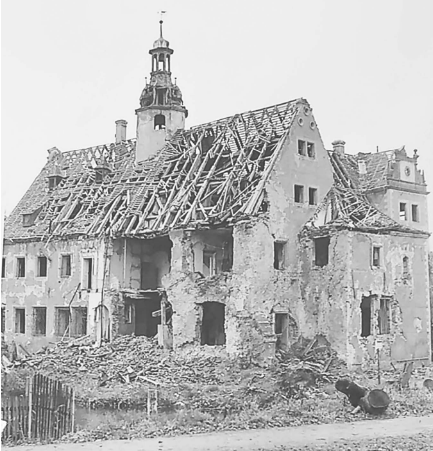
Abb. 1: Schloss Dölitz nach der Beschädigung, Foto: 1944.
