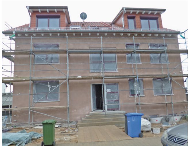
Bild 130 Obwohl Neubau dennoch kein fachgerechter barrierefreier Eingang
