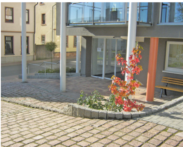
Bild 11 Zugang zum Seniorenheim mit zu steiler Rampe
