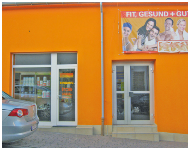
Bild 9 Steiler Gehweg und nicht barrierefreier Zugang
