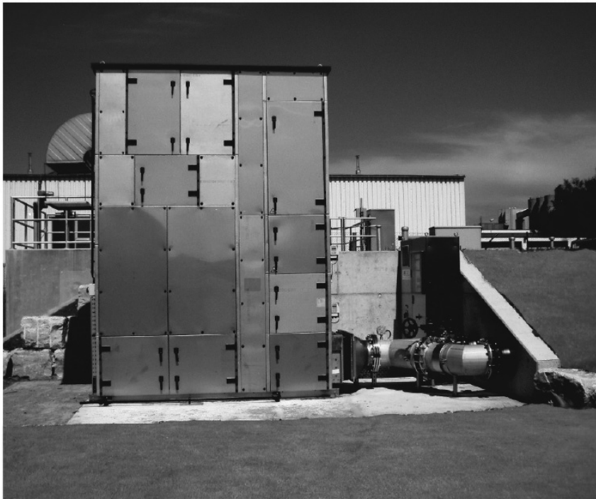
Bild 8: Abwasserkanalbewetterung bis 3.000m 3 /h, Deutschland
