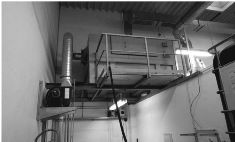
Bild 10: Molekularsieb zur Glättung von Lösemittelganglinien nach einer Waschmaschine
