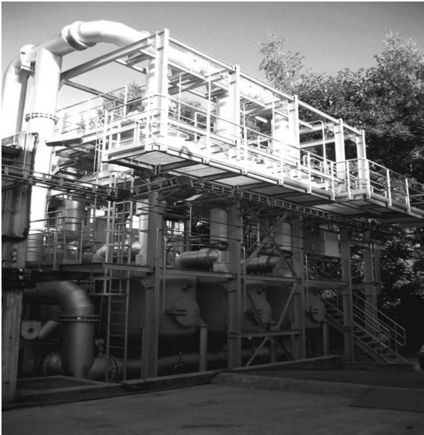
Bild 11: Abluftreinigung bzgl. BTEX-Aromaten und Alkylbenzolen in der Chemieindustrie, 14.000 m 3 /h, Deutschland
