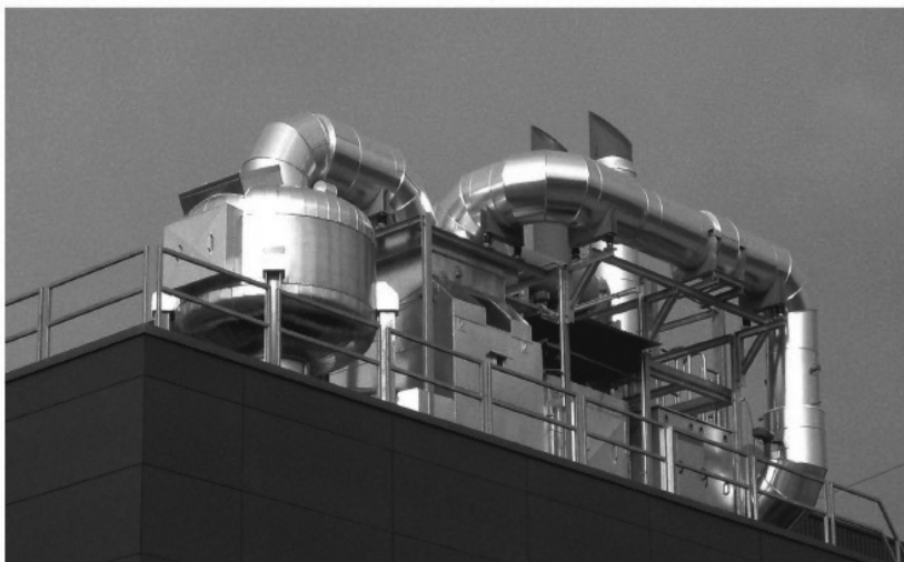
Bild 1: Ethanolabbau bei Lohnfertigung von Medikamenten, bis 18.000m 3 /h, Schweiz
