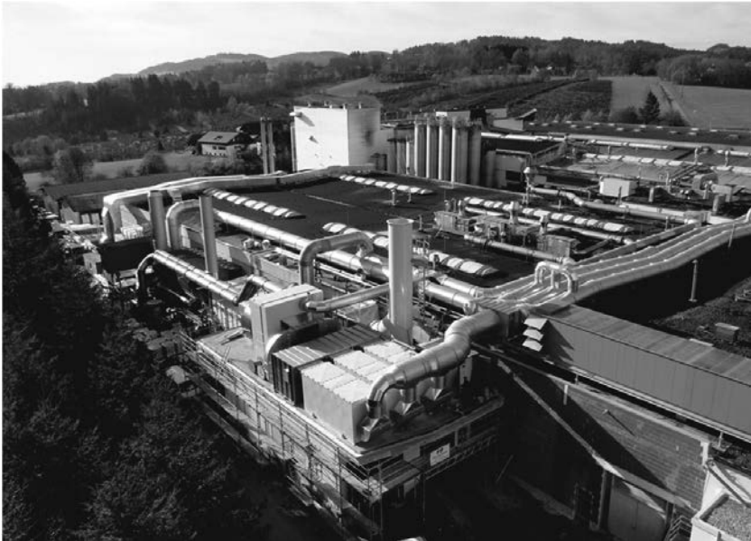
Bild 8: Ausführung einer Duplex-Anlage zur vorherigen Aufkonzentration mit ausgeführter Wärmerückgewinnung
