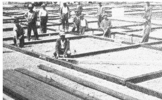
Abb. 18: Beispiel für die Montage eines Schwellenkranzes (Quelle: [18])
