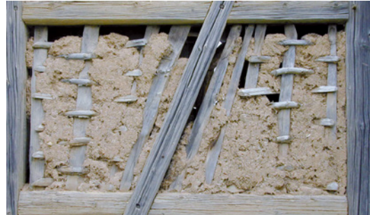
Abb. 8: Gefach aus Flechtwerk und Strohlehm eines sächsischen Fachwerkhauses (Quelle: Ziegert, Roswag, Seiler Architekten Ingenieure, Berlin)
