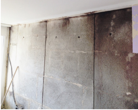
Abb. 14: Schimmel hinter der Dämmung
