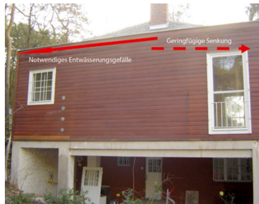
Abb. 32: Gefällesituation der verdeckten Entwässerungsrinne
