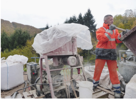
Abb. 14a: Mischung des Mörtelmaterials für das Römische Fundamentmauerwerk (Quelle: IFS Mainz)
