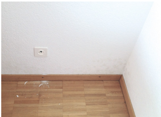
Abb. 6: Schimmelflecken nach Übermalen
