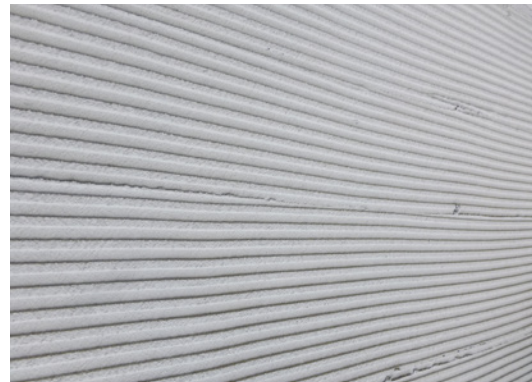
Abb. 21: aufgekämmte Spachtelung (Quelle: tubag, Kruft)
