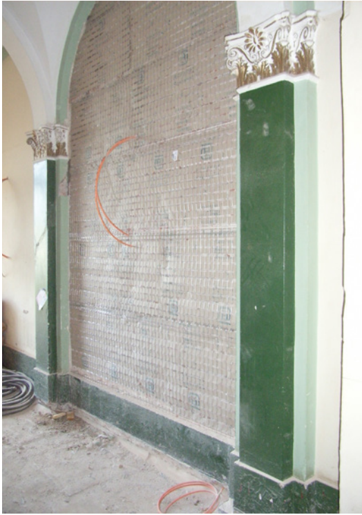
Abb. 4: Putzträger auf zu sanierender Mauerwerkswand
