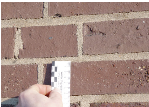
Abb. 10: Ausschnitt der Ziegelfassade eines unsanierten Bereiches mit Abrissen zwischen Fugenmörtel und Ziegel
