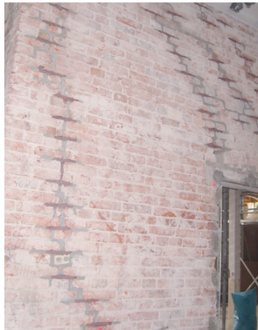
Abb. 6: Sanierung einer Mauerwerkswand mit Spiralankern
