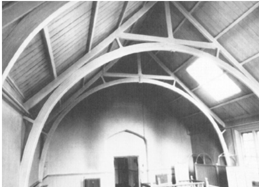
Abb. 7: Versammlungshalle in Southampton mit der ältesten erhaltenden Leimkonstruktion (1860)(Quelle: [10])
