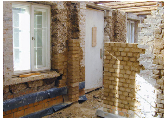
Abb. 3: Einbau von Horizontalsperren im Maueraustauschverfahren und Ersatz geschädigter Wandbereiche durch Ziegel- und Lehmsteinmauerwerk. Lehmwellerbau Steinstücken, Berlin (Quelle: Ziegert, Roswag, Seiler Architekten Ingenieure, Berlin)
