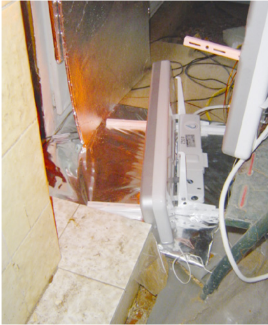
Abb. 36: separate Beheizung eines Stiefußes
