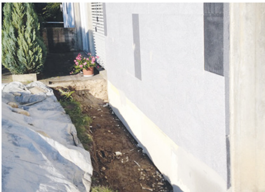
Abb. 16: Dämmung der verjüngten Mauer
