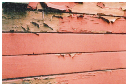
Abb. 33: abblättrende Reculit-Farbe, Zustand 2000 (Quelle: [16])
