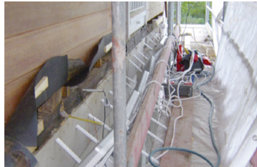
Abb. 40: provisorisch positionierte Infrarotstrahler mit einer Frequenz von 1000 nm
