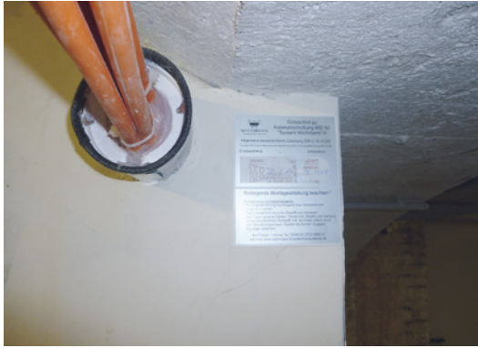
Abb. 7: ordnungsgemäße Abschottung in historischer Mauerwerkswand
