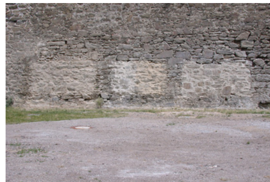
Abb. 17: Musterfläche der Mörtel zur ästhetischen Beurteilung, Festung Ehrenbreitstein (Quelle: IFS Mainz)
