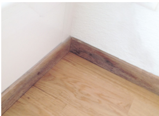
Abb. 4: Ecke mit Kondensationsspuren
