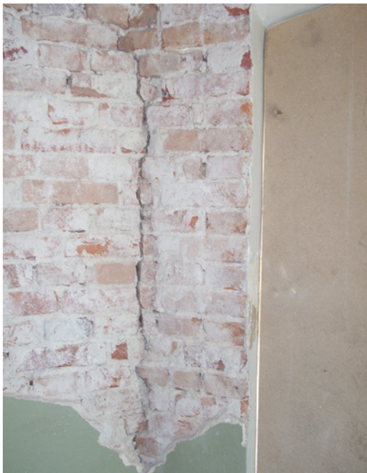
Abb. 5: Trennwand mit mangelhaftem Raumabschluss
