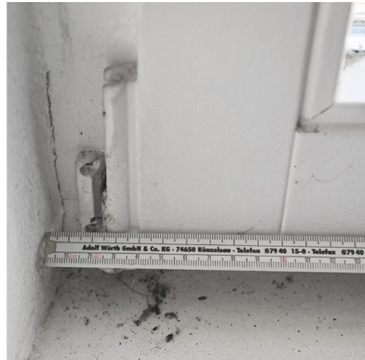
Abb. 5: Fotos des Bestandsfensters, für welches das Ergebnis der Dimensionierung der Laibungsdämmung in Abb. 4 dargestellt ist. Es wird deutlich, dass eine 6 cm starke Laibungsdämmung nicht ohne Weiteres umzusetzen ist.
