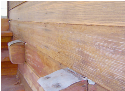
Abb. 35: komplett von den Farbschichten befreite Douglasien-Schalung
