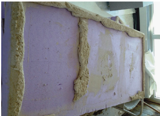
Abb. 13: fehlerhafte Innendämmung
