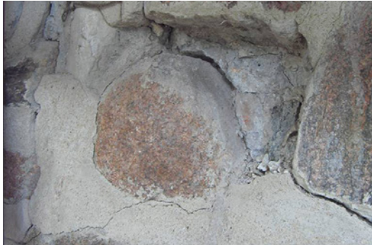
Abb. 9: Schadensbild abgesenkter Feldstein (Quelle: HAZ Ingenieure, Kassel)
