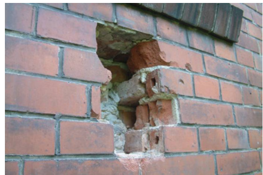
Abb. 5: Mauerwerk mit Luftschicht, Verblenderziegeln und Fugenmörtel
