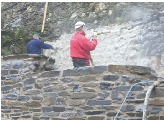
Abb. 14b: Applikation des Mörtelmaterials für das Römische Fundamentmauerwerk (Quelle: IFS Mainz)
