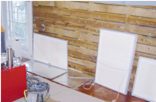
Abb. 37: beide Wärmequellen (Infrarotplatten + Warmluftheizer) für die bevorstehende Schwellenbehandlung
