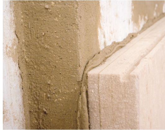
Abb. 7: mit vollflächigem Kontaktschluss angemörtelte Innendämmplatte (Quelle: Claytec, Viersen)
