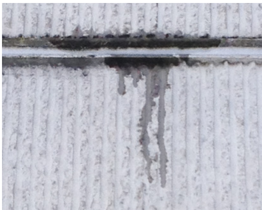
Abb. 9: Fassadenfuge mit Tropfschaden
