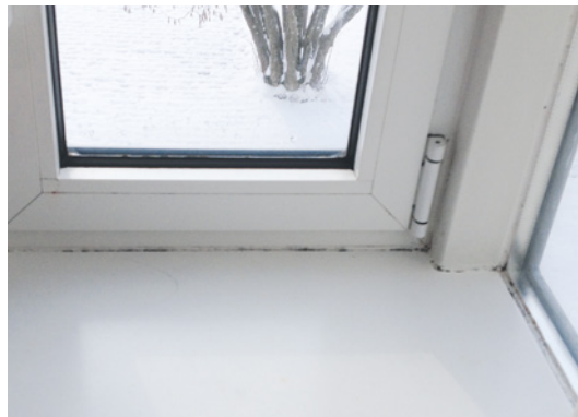
Abb. 7: Schimmel und Kondensation an Blumenfenster
