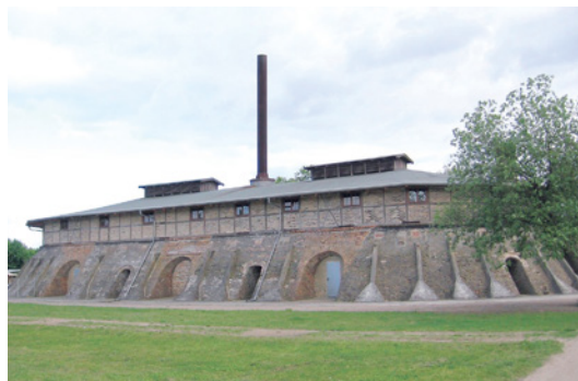
Abb. 2: Hoffmann'scher Ringofen im Ziegeleipark Mildenberg (Quelle: Schlesinger, https://commons.wikimedia.org/wiki/File:Ringofen_Ansicht.jpg (Lizenz CC BY-SA 3.0, https://creativecommons.org/licenses/by-sa/3.0/deed.de ))
