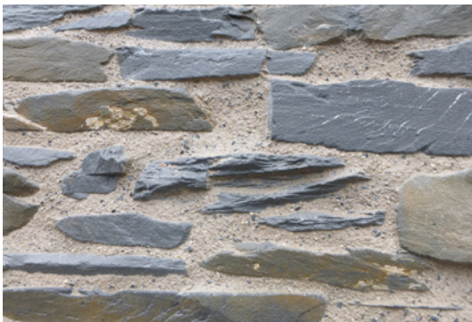
Abb. 15: Reparaturmaterial für das römische Mauerwerk der Burgruine Landshut (Quelle: IFS Mainz)
