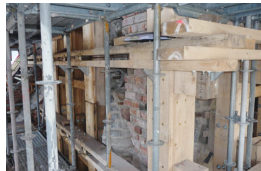
Abb. 10: Mauerwerksaustausch nach Sicherung (Quelle: HAZ Ingenieure, Kassel)
