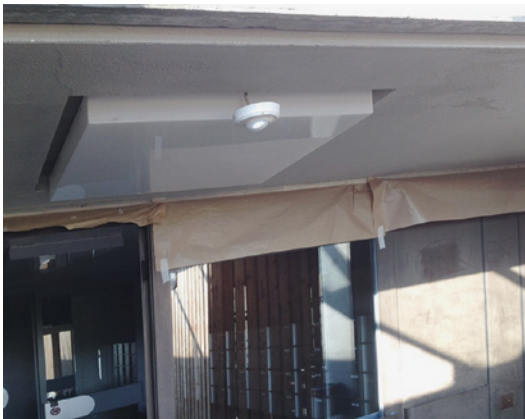
Abb. 15: Dämmung der Untersicht
