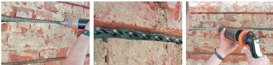
Bild 8.3 Einbringen des Ankermörtels in mehreren Lagen und Verlegen des Spiralankers (Fotos: Ruberstein GmbH)
