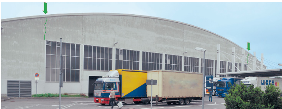
Bild 4.13 Giebelansicht der Halle mit Rissen an beiden Seiten des Fensterbandes (Pfeile)
