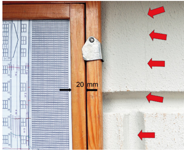
Bild 6.3 Sehr feiner Haarriss im Gebäudesockel, der nur mithilfe des alten Rissbildes zu finden ist
