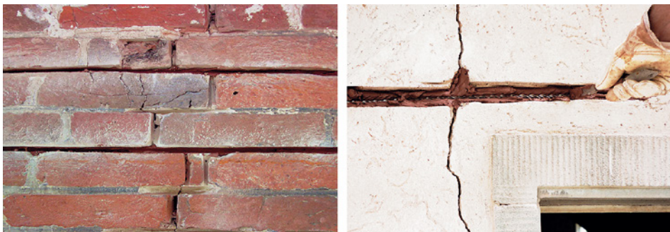
Bild 5.1 Schlitz in der Lagerfuge (links) und ein breiterer Schlitz (rechts), Fotos: Desoi GmbH
