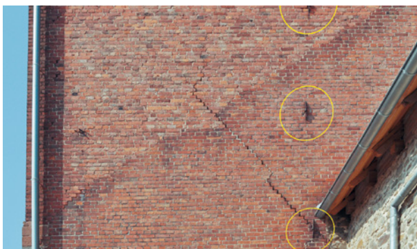
Bild 4.9 Ausgangspunkt des Risses ist der untere Maueranker, der eine Verformung behindert hat
