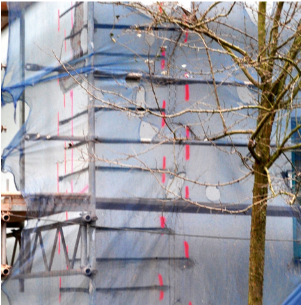
Bild 5.8 Um eine Ecke geführte Spiralanker
