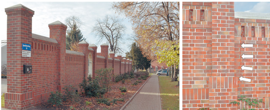
Bild 2.9 Senkrechter Riss in einer Wand aus Klinkermauerwerk, links: die Wand, rechts: der Vertikalariss
