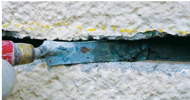
Bild 8.3 Einbringen des Ankermörtels in mehreren Lagen und Verlegen des Spiralankers (Fotos: Ruberstein GmbH)
