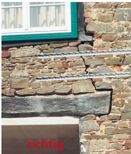
Bild 6.10 Gerade Schlitzte im Natursteinmauerwerk
