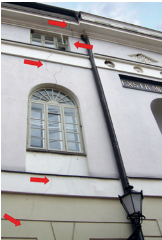
Bild 7.4 Dokumentation des Rissbildes in Fotos und als maßstäbliche Zeichnung (Begrenzung des Fotos rechts hervorgehoben)
