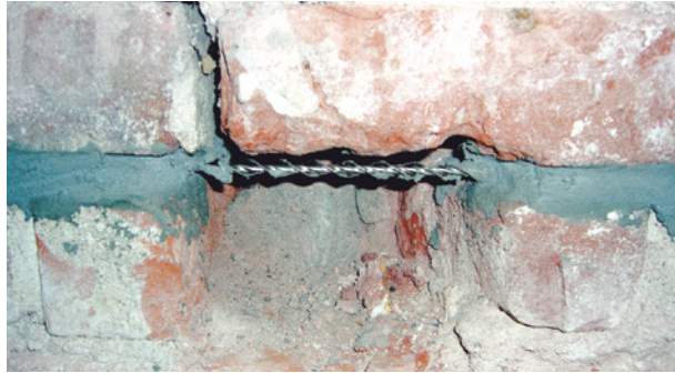
Bild 5.2 Spiralanker in einer geschlitzten Fuge, zur Veranschaulichung nicht völlig gefüllt (Foto: Ruberstein GmbH)
