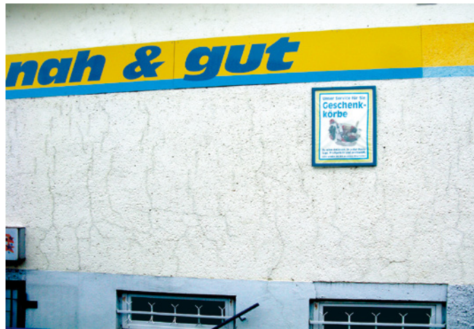
Bild 4.3 Feuchtigkeit in Rissen entweicht viel langsamer als von der Oberfläche
