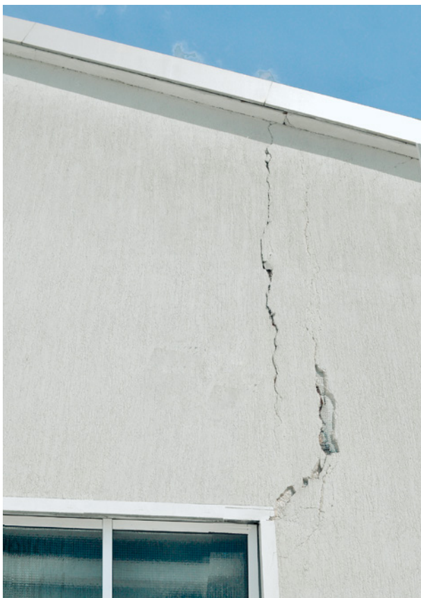
Bild 4.15 Vertikalriss am rechten Ende des Fensterbandes mit Spuren eines älteren, vergeblichen Instandsetzungsversuchs
