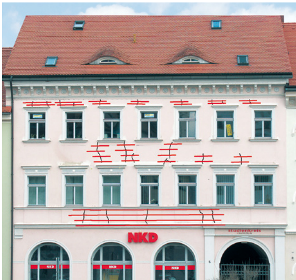
Bild 6.15 Instandsetzung als Rissgruppe über dem Erdgeschoss bzw. als Einzelrisse in den darüberliegenden Geschossen (Beispiel)
