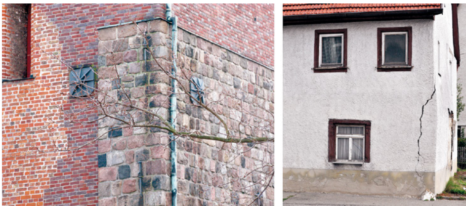
Bild 2.12 Ankerplatten von Mauerankern an einer Kirche (links), abgerissener Giebel durch fehlende Maueranker (rechts)
