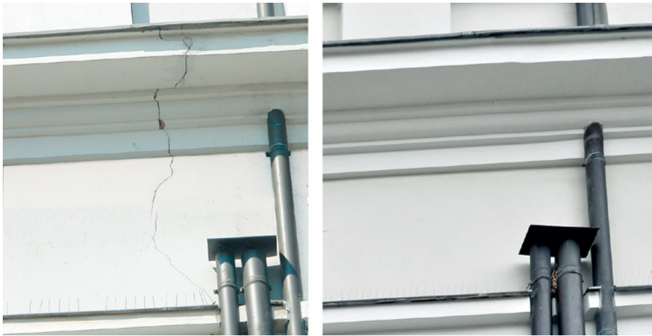
Bild 6.2 Vergleich eines Wandausschnitts vor der Instandsetzung (links) und zwei Jahre mit strengen Wintern danach (rechts)
