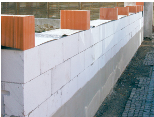
Bild 2.2 Mauerwerksabdeckung zum Schutz vor Niederschlägen im Bauzustand
