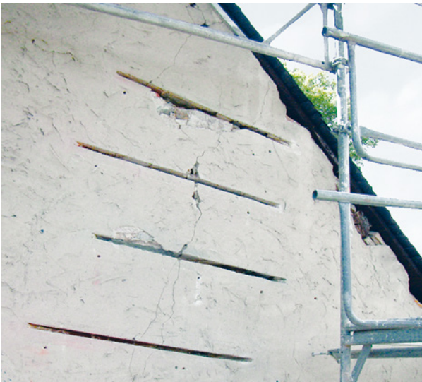
Bild 8.2 Schlitz im Mauerwerk (Foto: Desoi GmbH)
