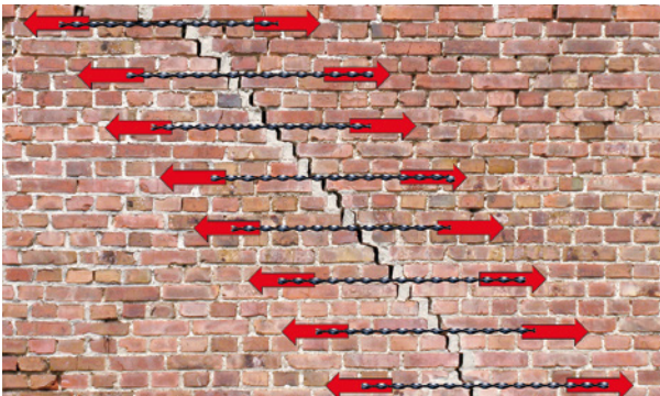
Bild 3.4 Horizontale Zugkräfte in der Wand durch die Wirkung der Spiralanker
