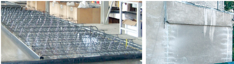
Bild 4.4 Bewehrungsvergleich Stahlbeton – Spiralankerbewehrung in Mauerwerk
