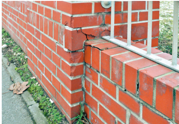
Bild 2.10 Abplatzungen an Klinkermauerwerk durch zu große Druckkräfte bei starker Erwärmung der Wand
