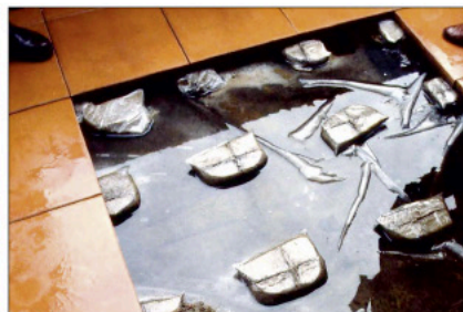
Abb. 10: Platten auf Stelzlager benötigen kein Gefälle, wohl aber die darunter verlegte Abdichtung [OSWALD]
