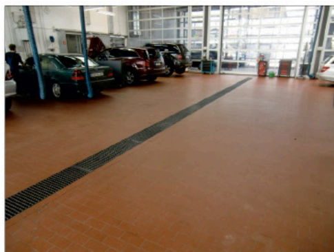
Abb. 2: KFZ-Werkstatt – Ausführung weitgehend eben, ggf. mit geringem Gefälle zur Entwässerungsrinne
