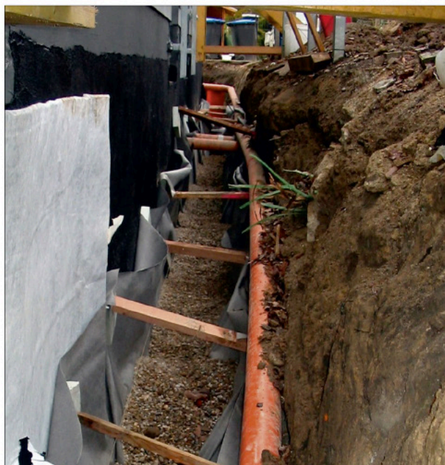
Abb. 7: Nachträgliche Außenabdichtung bei Beanspruchung durch aufstauendes Sickerwasser in Verbindung mit einer Dränung nach DIN 4095 (Bau-tenstand)
