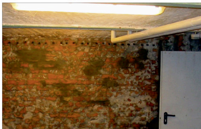
Abb. 10: Vorbereitung einer Wandfläche zur Aufnahme einer nachträglichen Innenabdichtung mit partieller Reparatur des Fugenetzes sowie Injektion gegen kapillar aufsteigende Feuchte am Wandkopf
