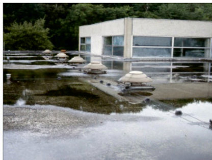
Abb. 1: Bei einem gering geneigten Flachdach ist mit Pfützenbildung in der Dachkehle zu rechnen [OSWALD]
