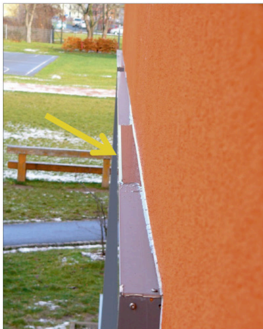
Abb. 5: Stehendes Wasser auf dem Einbauteil
