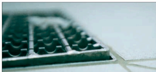
Abb. 2: Als Stolperstelle gilt bereits ein Höhenunterschied von mehr als 4 mm
