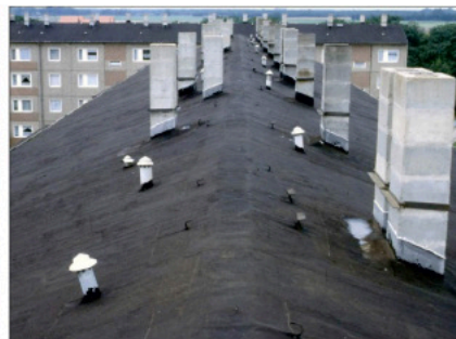
Abb. 2: Bei einem deutlich geneigten „Flachdach“ ist keine Pfützenbildung zu erwarten [OSWALD]
