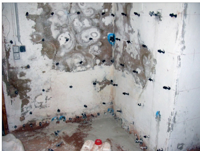
Abb. 13: Herstellung einer Flächenabdichtung im Bauteil im Injektionsverfahren
