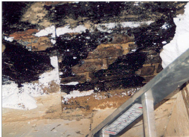
Abb. 2: unverputzte, erdberührte Kelleraußenwand mit Abdichtung KMB, fehlender Bitumenvoranstrich
