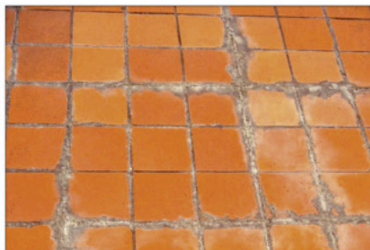
Abb. 9: Deutliche Sinterspuren bei einem im Mörtelbett verlegten Plattenbelag ohne Gefälle [OSWALD]
