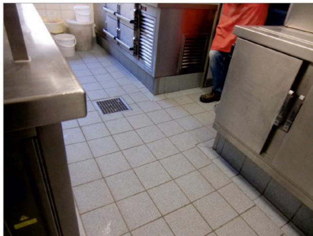
Abb. 4: Küchenboden im Gastronomiebereich – Ausführung mit geringem Gefälle zum Bodeneinlauf (mit Gerätesockel)
