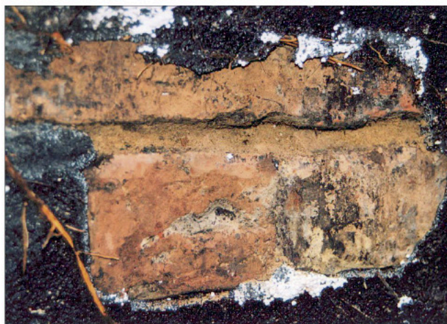
Abb. 4: nicht vorbereitetes, absandendes Fugennetz
