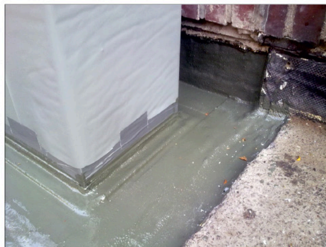
Abb. 8: Anschluss eines nachträglich gesetzten Lüftungsschachtes mittels FLK an eine Bestandsabdichtung aus Bitumenbahnen im Bereich einer erd-überschütteten Decke
