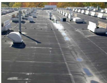
Abb. 6: Pfützenbildung im Bereich von Dachkehlen bei flach geneigten Dächern [OSWALD]
