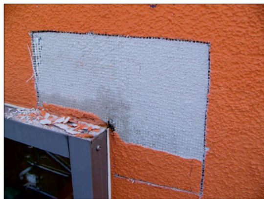
Abb. 6: Erhebliche Durchfeuchtungen im Eckbereich wegen des Stumpfstößes der Anputzleisten
