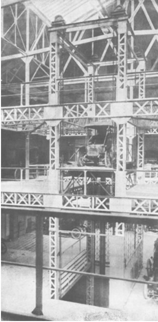
Abb. 4: Garage du Parc Monceau, Paris 1907. Automobilaufzug und hydro-pneumatische Mechanik, Foto 1907.
