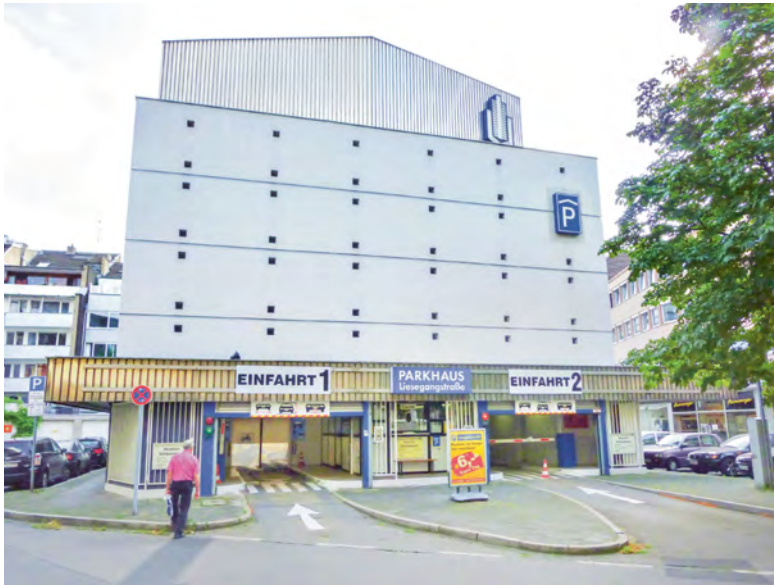
Abb. 5: Arbeitsgemeinschaft Autotiefsilo in Zusammenarbeit mit der Autosilo GmbH, Autosilo der Karstadt AG, Düsseldorf 1963. Zufahrten zu den beiden Fördertürmen, die die insgesamt 15 Parkebenen erschließen, Foto 2011.
