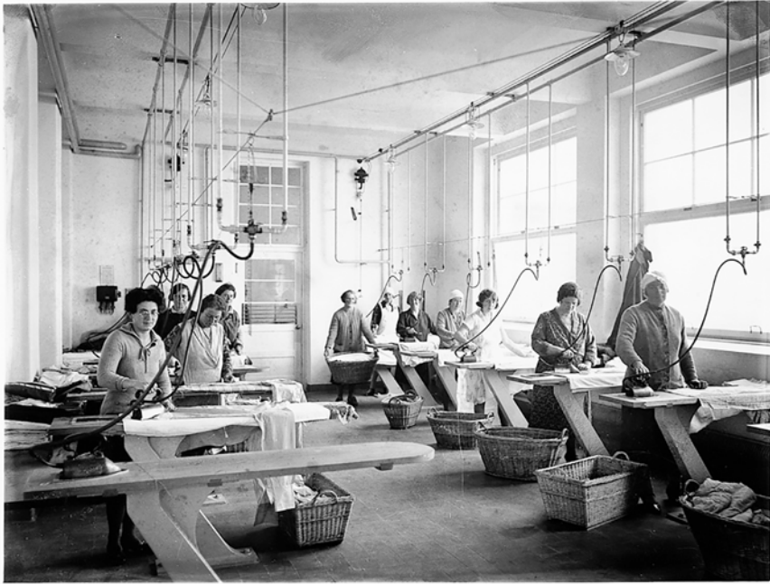
Abb. 25: Bügelsaal Am Tivoli, Meidling, Wien 12, erster Bauabschnitt 1927/28; zweiter Bauabschnitt 1929/1930, Fotoaufnahme ca. 1931. Der Bügelsaal wird erst im zweiten Bauabschnitt errichtet.
