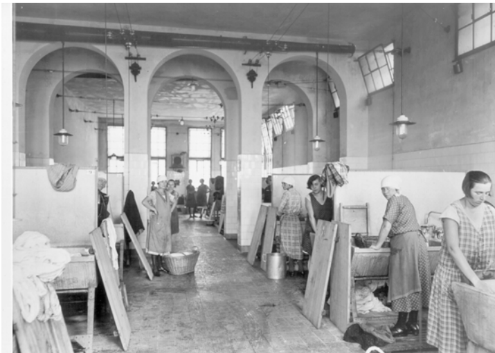
Abb. 22: Zentralwaschküche, Sandleiten Hof, Ottakring, Wien 16, erbaut 1924–1928
