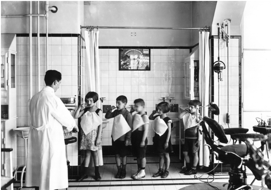
Abb. 29: Im Zahnambulatorium der neuen KÜSt.
