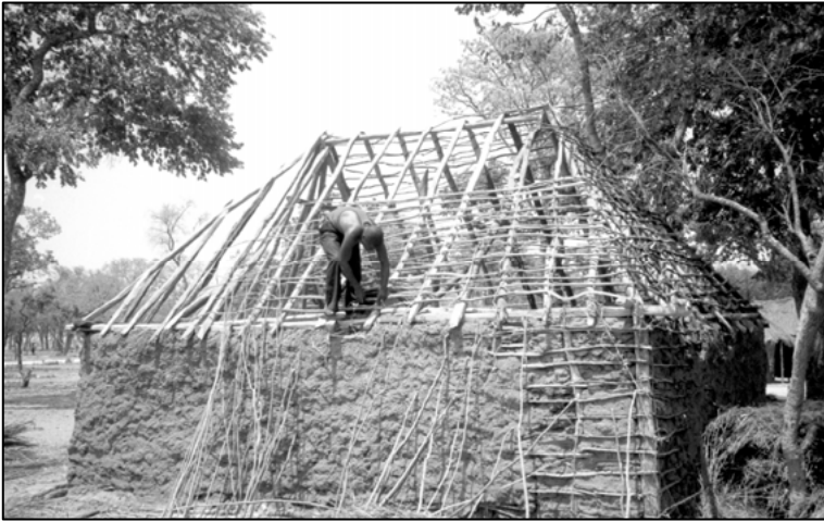
Abbildung 17: Hausbau in Nangweshi
