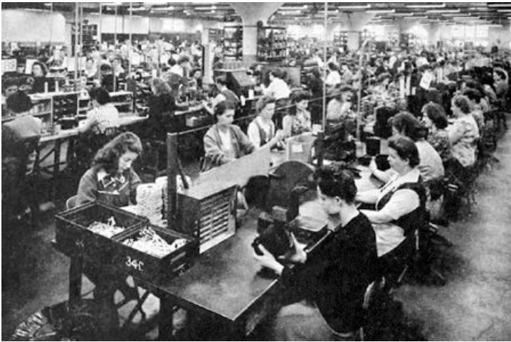
Abb. 2 Industrielle manuelle Fertigung von Radaren durch WE-Arbeiterinnen
