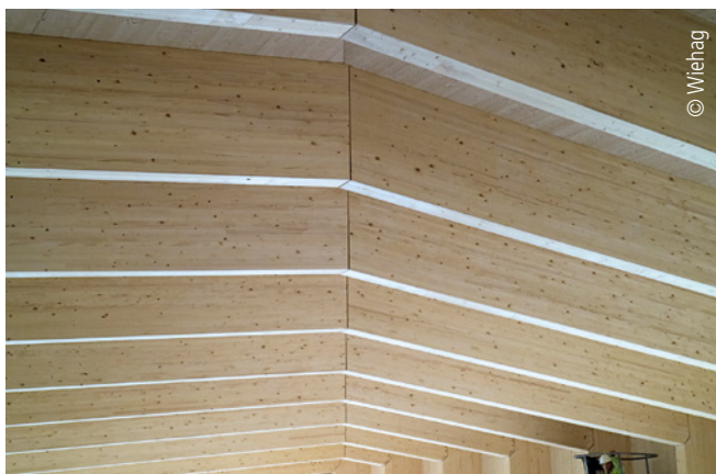
Abb 5: Die Firstpunkte der Portalrahmen sind reihenweise verschoben, sodass die Firstlinie diagonal zum Schwimmbecken verläuft
