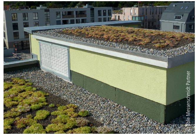
Abb. 3: Detail der Zuluftöffnung auf dem Dach. Dahinter sitzt der Wärmetauscher.
