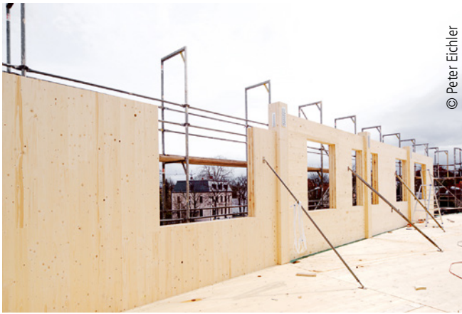
Abb. 11: Die meisten Wandelemente der oberen drei Geschosse kamen mit ausgefrästen Fensteröffnungen auf die Baustelle und wurden zwischen die Stützen eingehängt.
