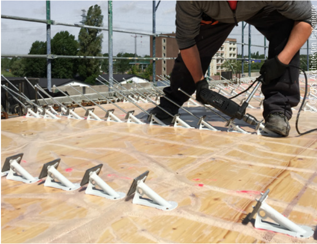
Abb. 8: Der Verbinder mit geneigtem Schraubkanal dient als Platzhalter und Führungshülse für die Verbindungsmittel. Entsprechend lange Schrauben verspannen die Konstruktion und verzahnen sich später mit dem bewehrten Aufbeton.
