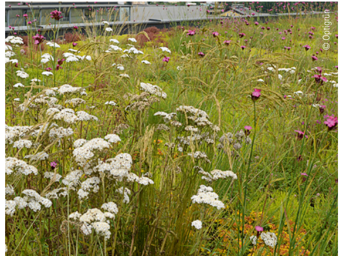
Abb. 3: Technisches Zentrum Heiterblick, begrünte Dachflächen auf den Neubauten. Vegetation als Mischung aus Kräutern, Gräsern und Sedum. Hoher Wasserrückhalt und hohe Artenvielfalt bei starker Minderung des Spitzenabflusses auf einem Retentionsdach.
