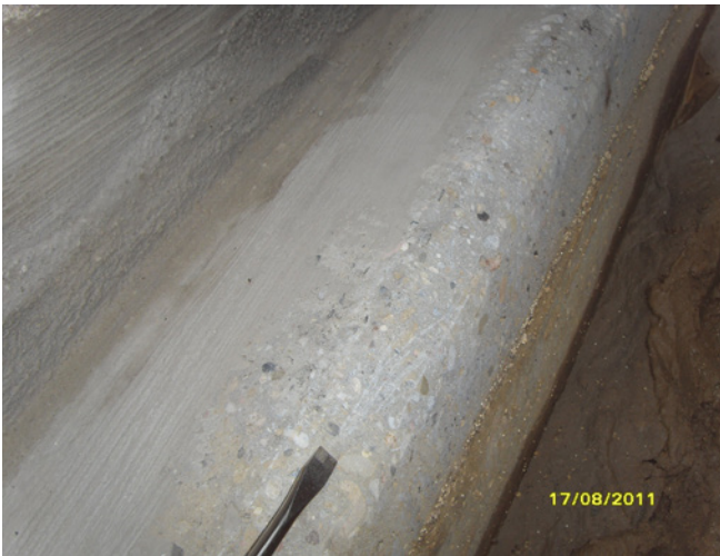
Abb. 3: Am Übergang von der Bodenplatte zur Wand ist die hergestellte Hohlkehle zu sehen. Die Oberseite und die Stirnseite der Bodenplatte sind fachgerecht geschliffen: Die Schlempen wurde hier vollständig entfernt.
