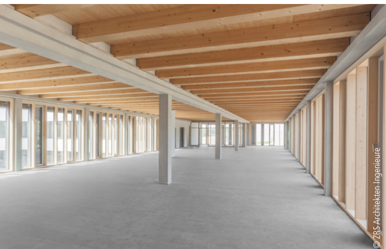
Abb. 6: BS-Holz-Balken mit aufgelegter Dreischichtplatte bilden die Untersicht der Holz-Beton-Verbund-Decke. Die Deckenbalken liegen auf konsolenartigen Vorsprüngen der Stahlbeton-Träger des Skelettbbaus auf.
