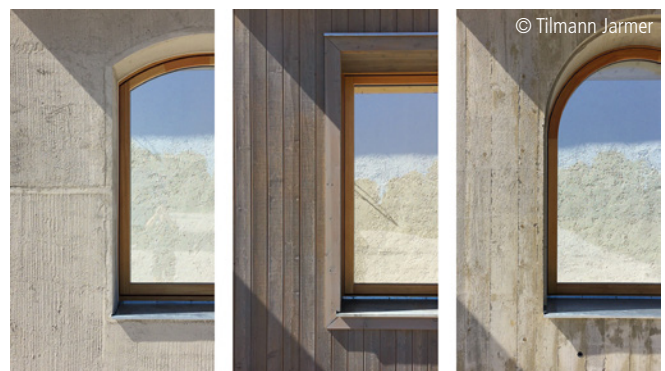
Abb. 11: Fensterdetails der verschiedenen Bauweisen; Foto der Fassadenmodelle im Maßstab 1:1
