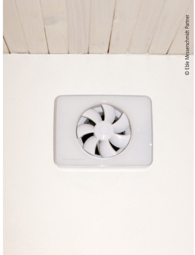
Abb. 6: Detail des Abluftventilators aus Schweden mit großem freien Querschnitt
