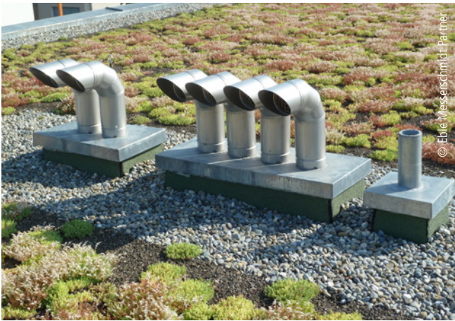
Abb. 5: Detail der Luftauslässe. Jeder Raum hat einen eigenen Schacht.
