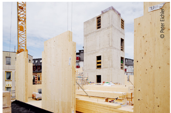
Abb. 12: Ein Teil der Wandscheiben erhielt ausgeklinkte Ecken als Auflager für die Unterzüge.
