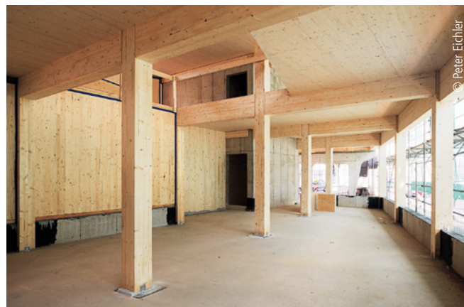
Abb. 6: ... als auch im EG. BSP-Decken und -Wände bilden aussteifende Scheiben, die wie in Rahmen jeweils zwischen die Träger und geschosshohen Stützen eingefügt sind. Nur die Stützen um das interne Treppenhaus zwischen EG und 1. OG sind zweigeschossig ausgeführt.
