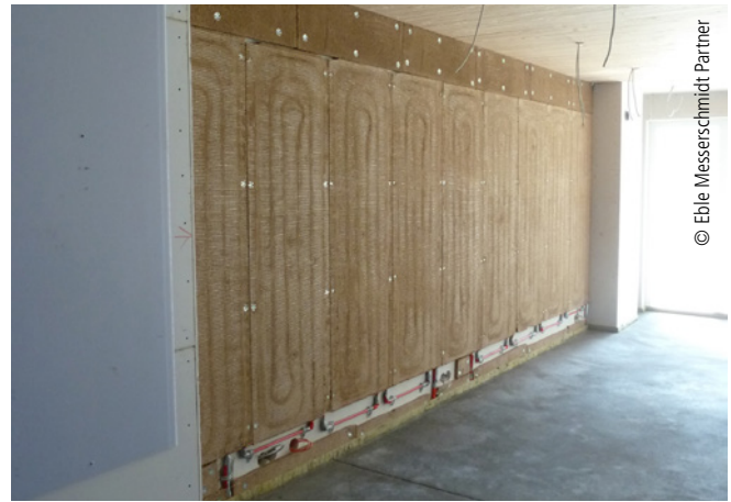
Abb. 9: Die Wandheizung aus vorproduzierten Lehmplatten wird durch Nahwärme gespeist
