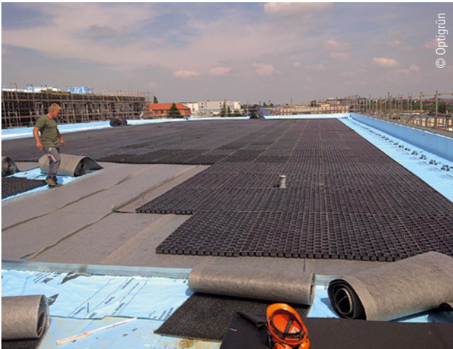
Abb. 2: Technisches Zentrum Heiterblick, Neubauten. Beispiel eines begrünten Retentionsdaches. Mäander-60-Elemente auf Schutz- und Speichervlies, darunter wurzelfeste Dachabdichtung. Später folgt auf die Mäander-Elemente ein Filtervlies, darüber Extensivsubstrat mit Vegetation.
