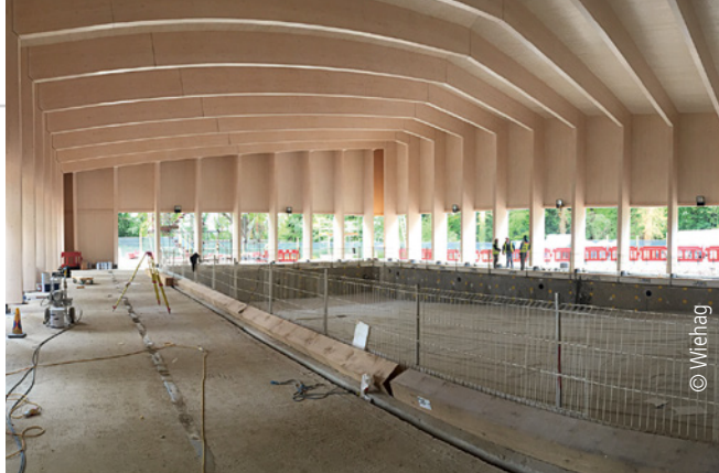
Abb. 3: Das Hirnholz der BSH-Rahmen ist rund 10 cm vom Boden abgesetzt und mit gefrästen Abtropfkanten versehen
