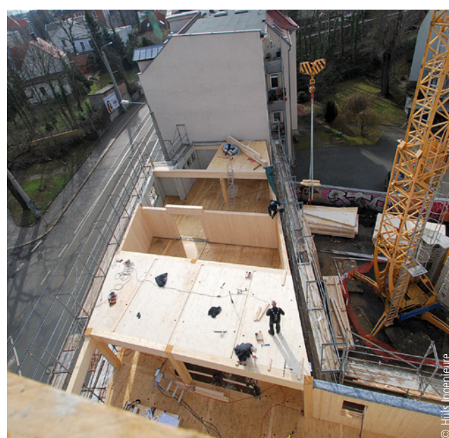
Abb. 10: Die BSP-Deckenelemente wurden zwischen die BS-Holzträger eingefügt und an den Längsstößen zu Scheiben verbunden.
