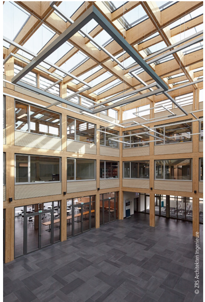
Abb. 5: Der Hof A des quadratischen Gebäudes erhielt ein Glasdach und wird zu einem Lichthof innerhalb des Baus. Das dem Atrium zugewandte Skelett des quadratischen Gebäuderings besteht über alle Geschosse aus BS-Holz-Stützen und -Trägern.
