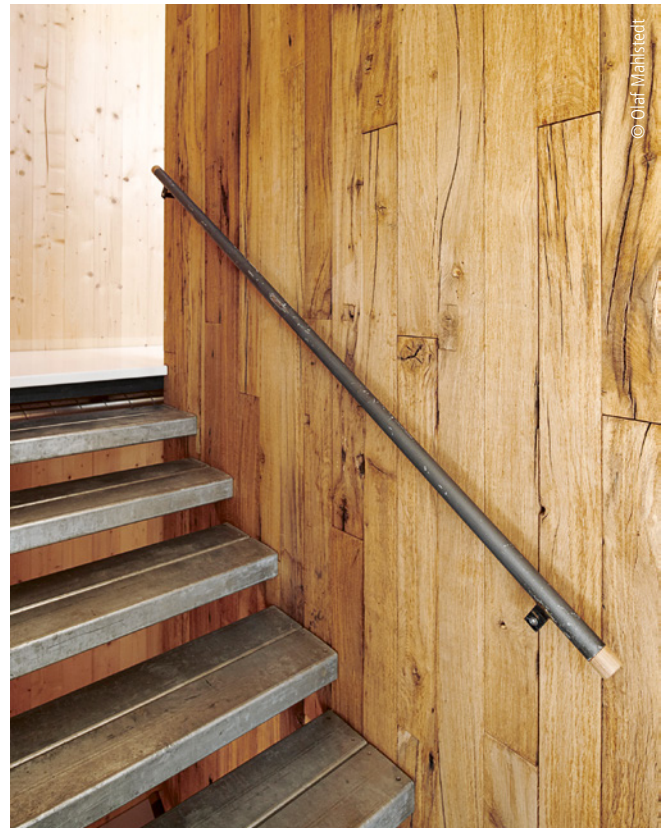
Abb. 5: Wand aus historischen Eichenholzbalken, Treppenkonstruktion aus gebrauchten Stahlteilen
