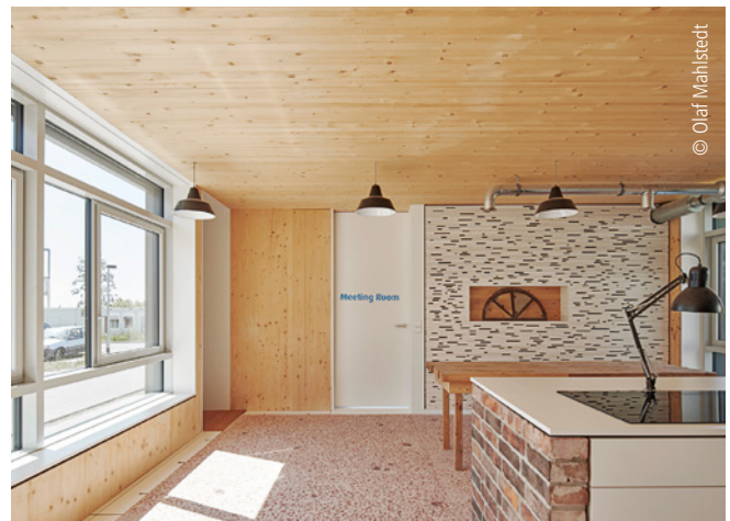
Abb. 7: Terrazzo »Opus Signium« aus Nebenprodukten der Dachziegelherstellung
