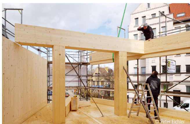
Abb. 7: Im Bereich der Gebäudespitze dient ein (beidseitig auskragender) Träger auf zwei Stützen als Deckenaufleger. An den Trägerenden schließen die Randunterzüge der Außenwände an.
