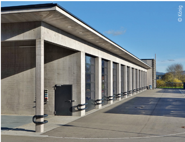
Abb. 4: Flussbaubetriebshof des Landes Baden-Württemberg in Donaueschingen. Niederschlagswasser vom begrünten Dach wird direkt, von der Hoffläche indirekt über eine Sedimentationsanlage Richtung Donau entwässert. Links Waschplatz mit kombiniertem Benzin- und Koaleszenzabscheider, dessen Abfluss durch einen Probenahmeschacht in die Schmutzwasserkanalisation erfolgt.
