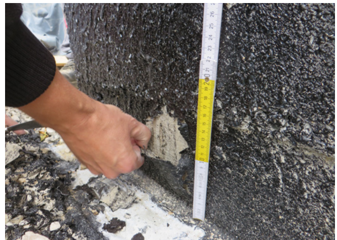
Abb. 1: Exemplarische Schadensfeststellung: Ablösung im Bereich »Unterer Übergang«, Schlempe haftet an Rückseite des abziehbaren PMBC-Materials
