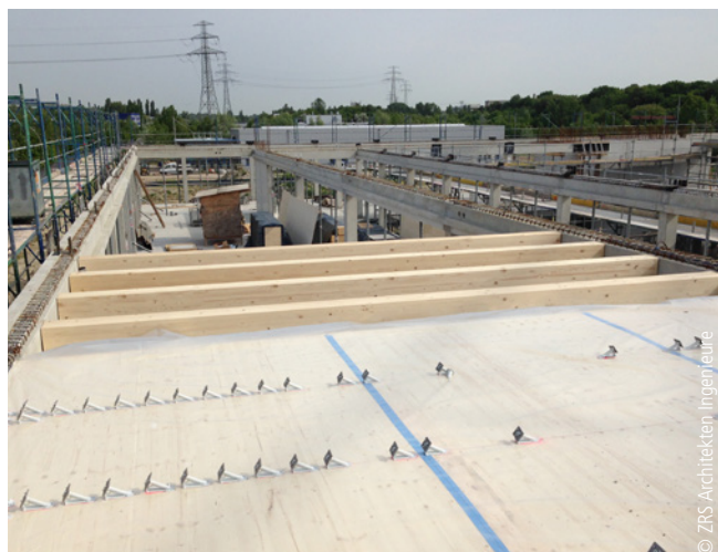
Abb. 7: Den Verbund zwischen Deckenbalken, Dreischichtplatte und Beton stellen FT-Verbinder her. Diese wurden reihenweise in Achse der Deckenbalken aufgebracht.
