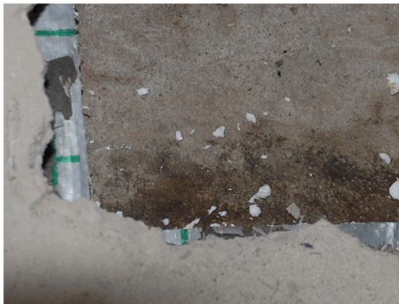
Abb. 3.14.1: »Freies Wasser« oberhalb der Sockelabklebung
