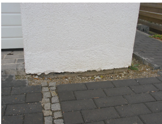
Abb. 3.9.4: Ausbesserungen am Sockelputz
