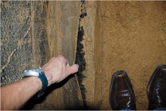
Abb. 3.5.2: Nicht mit dem Sohlplattenüberstand verklebte horizontale Querschnittsabdichtung
