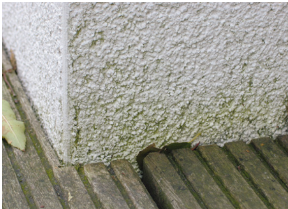
Abb. 3.9.3: Anschluss Holzterrasse an Außenwandputz
