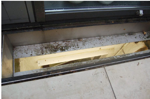
Abb. 3.7.3: Entwässerungsrinne mit Aussparung, Blick in den Kellerlichtschacht vor dem Badezimmerfenster
