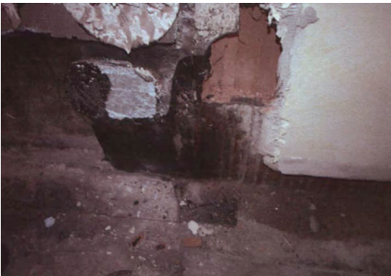
Abb. 3.3.4: fehlender Anschluss der Außenabdichtung an die Innenabdichtung
