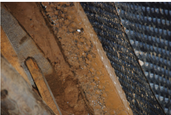
Abb. 3.5.3: »Abdrücke« auf der KMB-Beschichtung
