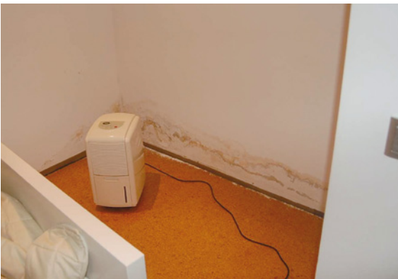
Abb. 3.7.2: Ausgeprägte Wasserränder, Salzausblühungen und Farbabplatzungen am Innenputz der Kelleraußenwand im Schlafzimmer
