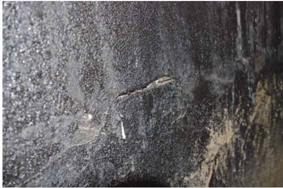
Abb. 3.14.3: Risse in der vertikalen KMB-Abdichtungsebene
