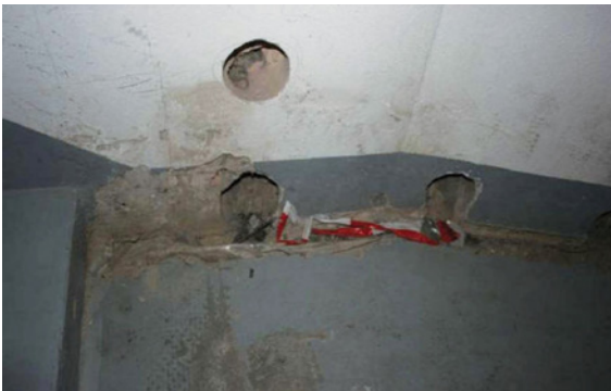
Abb. 3.12.1: Bohrungen in einer Außenwand des Verbindungsgangs
