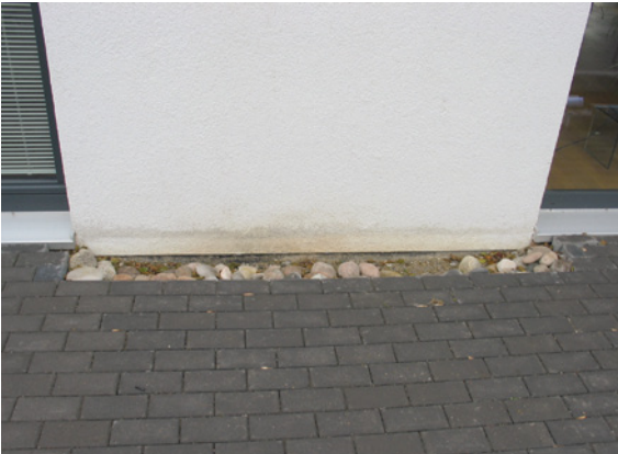
Abb. 3.9.1: Feuchteverfleckungen am Sockelputz
