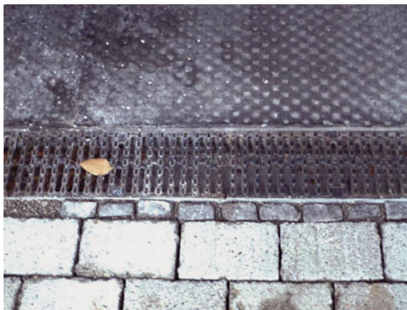
Abb. 3.2.3: Entwässerungsrinne
