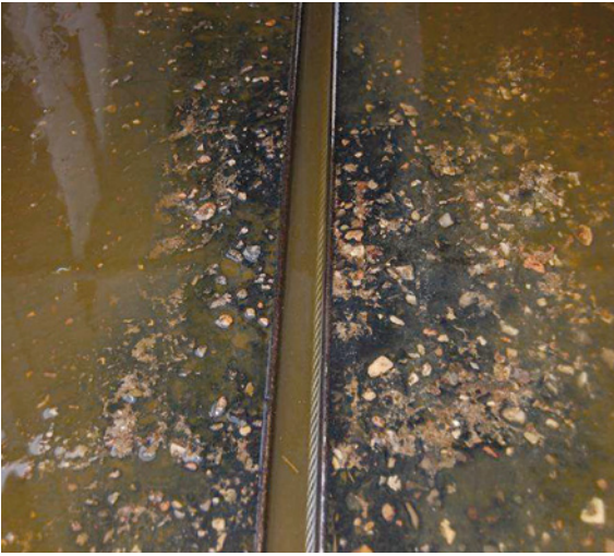
Abb. 3.8.2: Oberflächenschäden am Betonboden in einem Mistgang
