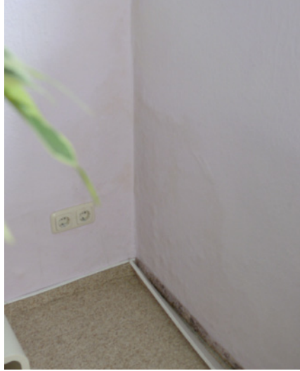
Abb. 3.15.4: Feuchtehorizont im Eckbereich Kelleraußenwand/Haustrennwand
