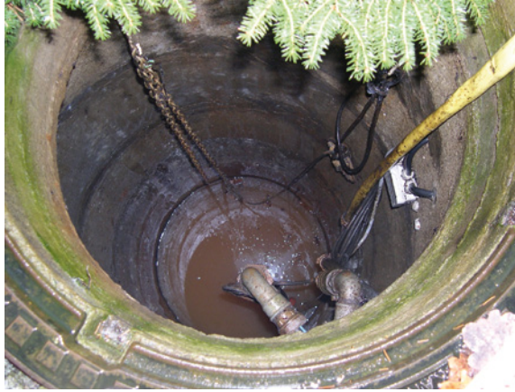
Abb. 3.10.5: Sickerschacht
