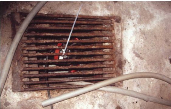
Abb. 3.4.4: Sickerablauf im Kellerfußboden mit eingebauter Tauchpumpe
