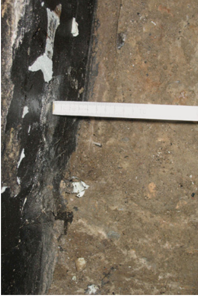
Abb. 3.7.6: Kelleraußenwand, Ausführung der KMB ohne Ausbildung einer Hohlkehle im Anschlussbereich der Wand zur vorstehenden Sohlplatte
