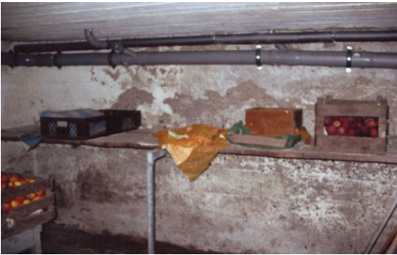
Abb. 3.4.3: Feuchteschäden im Bereich der Kellerwände
