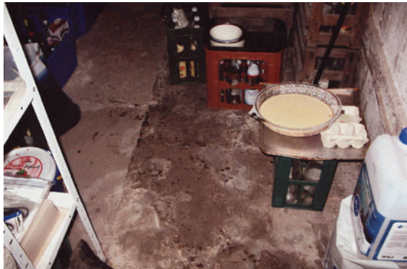
Abb. 3.4.2: Feuchteschäden am Kellerfußboden
