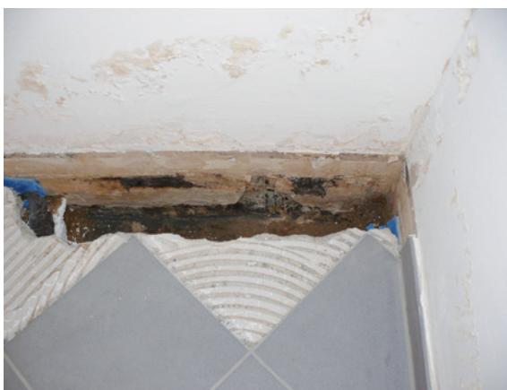
Abb. 3.1.2: Geöffneter Fußpunkt des betroffenen Bereichs (Estrich, Wärmedämmung, Sockelfliesen, Innenputz)
