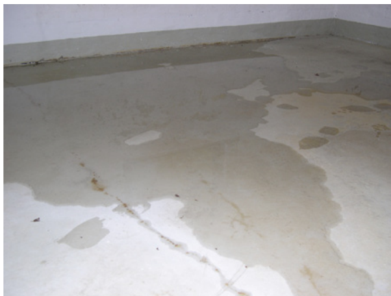
Abb. 3.10.3: Durchgehender Riss im Estrich, großflächige Pfützenbildung
