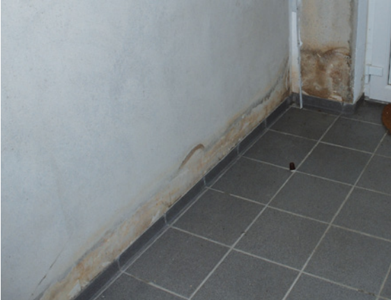
Abb. 3.14.2: Feuchteverfleckungen an den Kellerwänden
