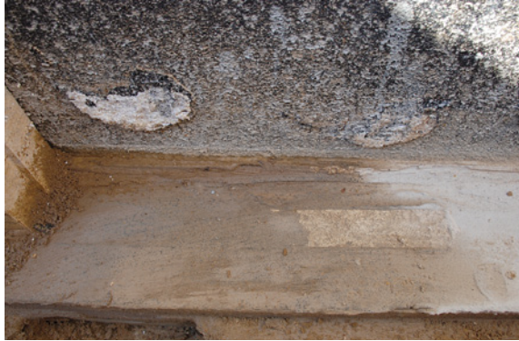
Abb. 3.5.4: Fehlende Hohlkehle der KMB-Beschichtung
