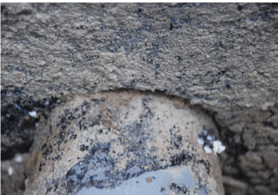
Abb. 3.6.1: Außenseitiger Anschluss des Mantelrohres an die Kelleraußenwand
