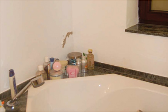
Abb. 3.7.1: Farbabplatzungen am Innenputz der Kelleraußenwand im Badezimmer
