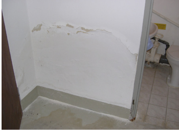
Abb. 3.10.2: Bräunliche Feuchteverfleckungen, korrodierte Stahlzargen
