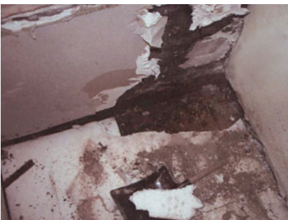
Abb. 3.3.3: Stehendes Wasser unterhalb der Wärmedämmung in der Treppennische
