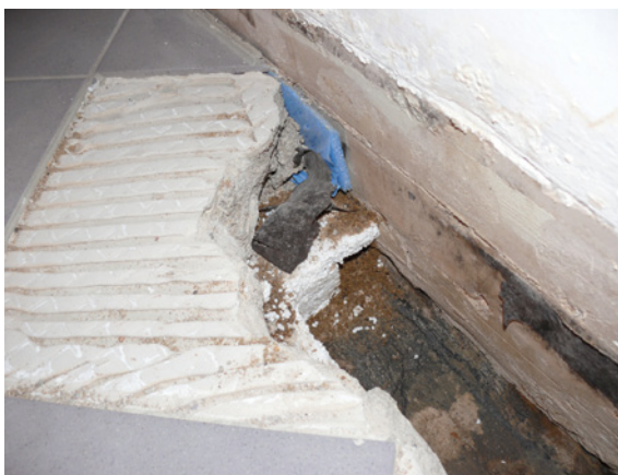
Abb. 3.1.3: Feuchteerscheinungen unterhalb des Estrichs und der Wärmedämmung
