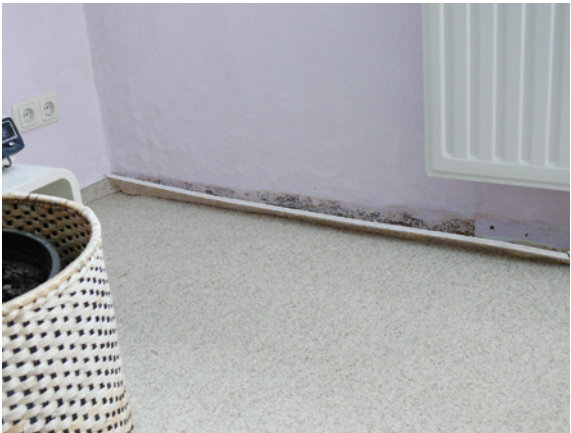
Abb. 3.15.3: Schimmelpilzbefall in Höhe der Fußleisten an der Kelleraußenwand
