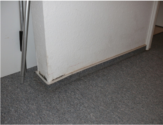
Abb. 3.13.3: Schimmelpilzbefall im Sockelbereich einer Innenwand
