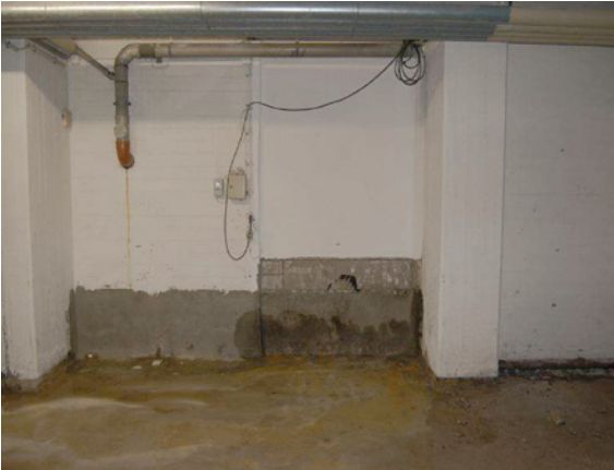
Abb. 3.11.2: Nachträglich verschlossene Türöffnung im Fahrradkeller
