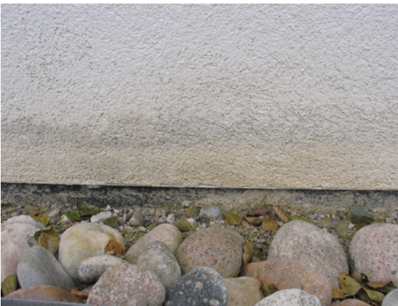
Abb. 3.9.2: Feuchteverfleckungen am Sockelputz
