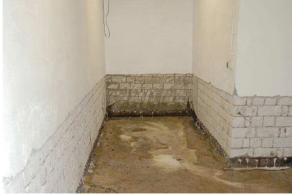
Abb. 3.11.3: Nachträglich verschlossene Türöffnung im Kellergang
