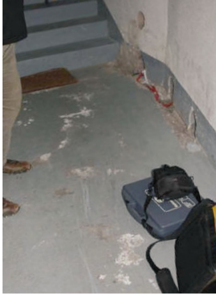
Abb. 3.12.2: Wasserränder und Ausblühungen am Innenputz, Ausblühungen und Ablösungen des Anstrichs am Verbundestrich im Verbindungsgang
