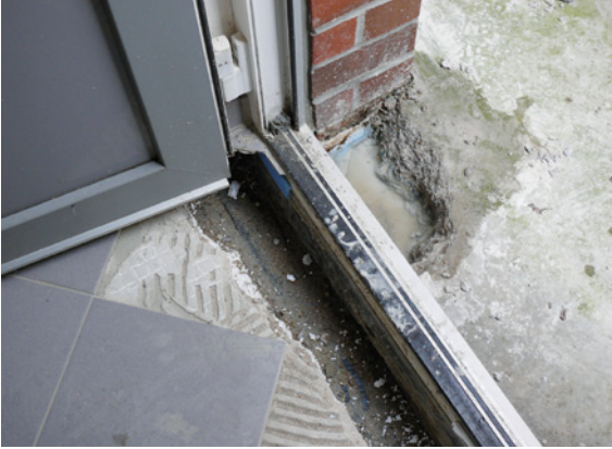
Abb. 3.1.4: Wasser im Bereich des Fußpunktes der Kelleraußentür innen
