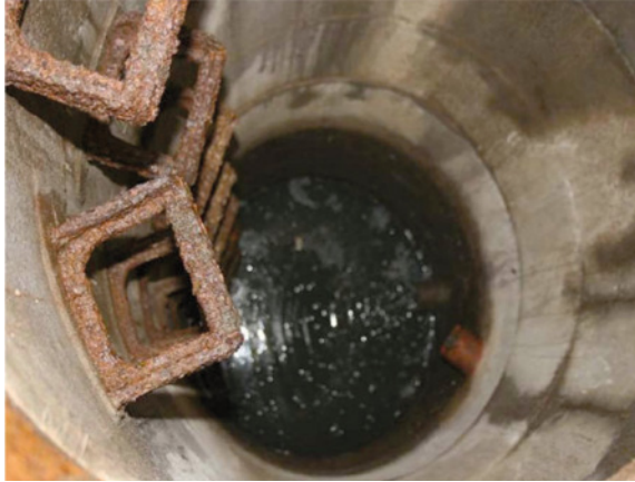
Abb. 3.12.5: Blick in den Entwässerungsschacht mit Einmündung der Dränleitung
