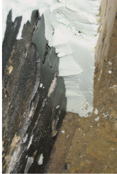
Abb. 3.7.7: Kelleraußenwand, freigelegte KMB mit Perimeterdämmung
