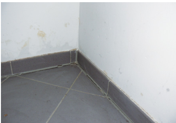
Abb. 3.1.1: Feuchteerscheinungen im Sockelbereich der östlichen Außenwand
