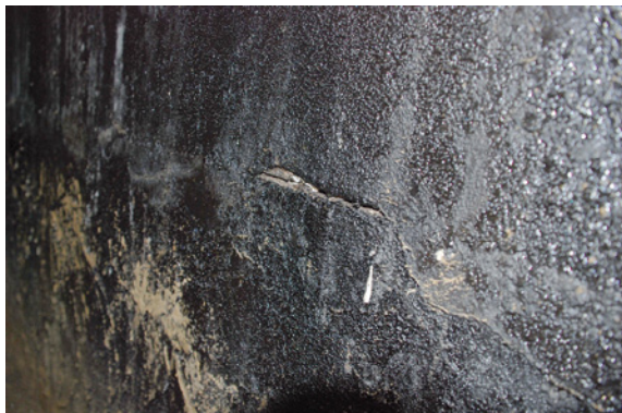
Abb. 3.5.1: Risse in der vertikalen KMB-Abdichtungsebene am Treppenabgang
