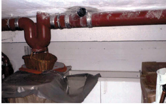
Abb. 3.2.2: Feuchteerscheinungen an der Kellerdecke
