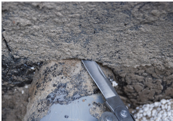
Abb. 3.6.3: Außenseitiger Anschluss des Mantelrohres an die Kelleraußenwand – Mantelrohr besitzt keine dichtende Verbindung zur Stahlbetonkonstruktion
