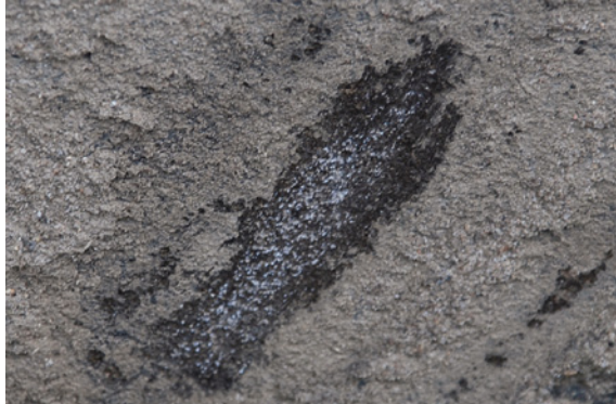
Abb. 3.6.2: Abdichtung auf der Kelleraußenwand an der Durchführung
