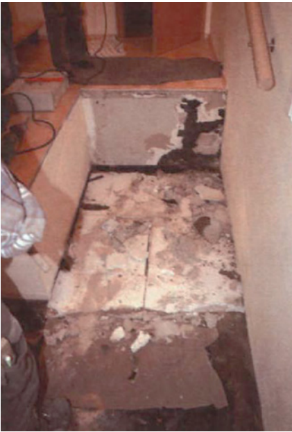
Abb. 3.3.2: Freigelegter Estrich in der Treppennische
