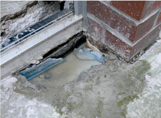
Abb. 3.1.5: Wasser im Bereich des Fußpunktes der Kelleraußentür außen
