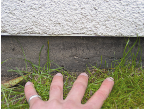
Abb. 3.9.5: Poröse Sockelabdichtung
