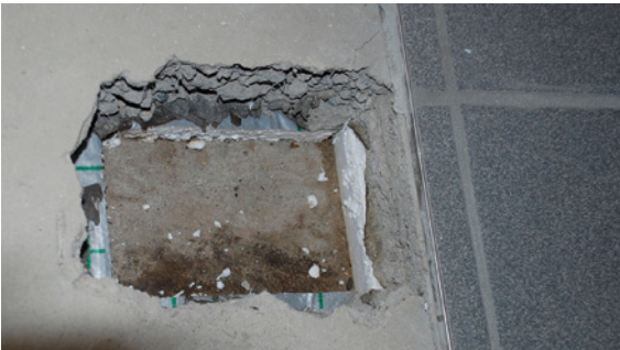
Abb. 3.5.7: »Freies Wasser« oberhalb der Sohlablebung
