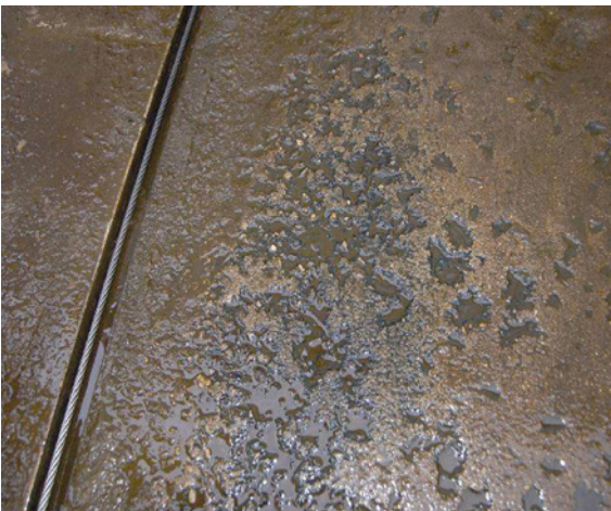
Abb. 3.8.3: Betonoberfläche mit freiliegender Gesteinskörnung
