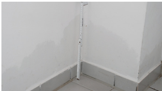
Abb. 3.5.5: Aufsteigende Feuchte am Wandsockel im Keller
