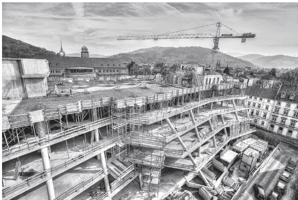
Abb. 6: Rohbauarbeiten im Wohnumfeld
