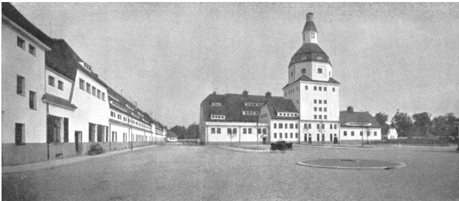
Abb. 3: Kühl- und Maschinenhaus des Schlachthofs Dresden. (Quelle: Erlwein, Hans: Der neue städtische Vieh- und Schlachthof zu Dresden, in: Der Industriebau II, 1911, H. I, S. 19)
