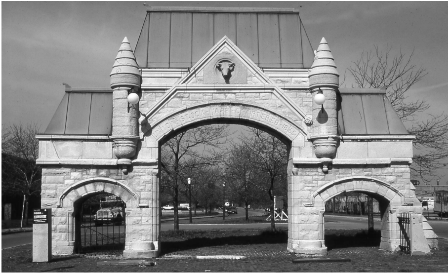
Abb. 9: Das als Denkmal erhaltene, 1879 errichtete Einfahrtstor der Union Stock Yards in der Exchange Ave in Chicago. (Foto: Helmut Lackner 2001)
