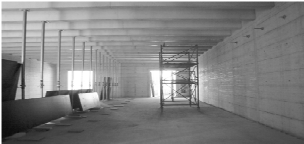
Abb. 5: Blick in den großen Ausstellungsraum im Rohbau, August 2004. (Foto: Chris Korner, DLA)
