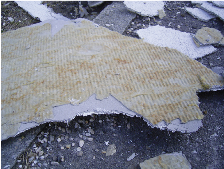
Bild 19: Objekt H: Bruchlinie der Putzscholle ist zugleich Risslinie des Gewebes. Das Gewebe ist funktionslos
