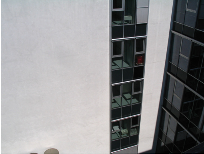
Bild 4: Objekt B: Große Fassade links, ausgewogenes L:B-Verhältnis = rissfrei. Ausnahmslos waagrechte Risse in der hohen, schmalen Fassadenfläche
