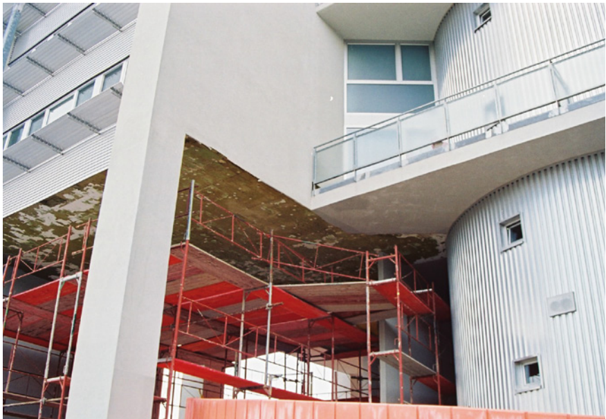
Bild 3: Objekt A: abgestürzter Deckenbereich
