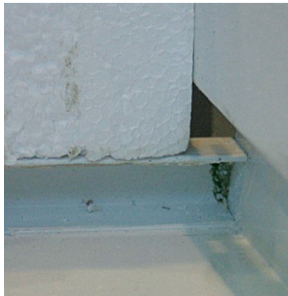
Bild 6: Wassereintrittsstelle im Bereich der Fensterbankanschlussnut [Quelle: Holzforschung Austria]
