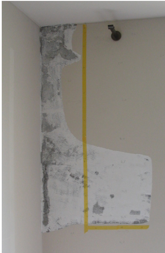
Bild 9: Objekt D: Innen Schaden auslö- sende Feuchtig- keit von außen
