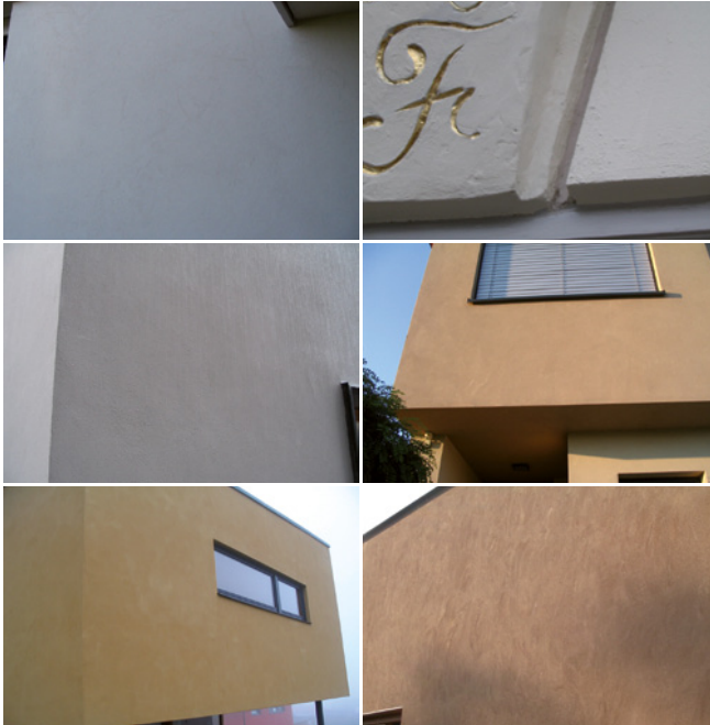
Bilder 7–12: Das exakt gleiche Produkt (Deck- putz) an sechs verschieden, weit auseinander liegenden Objekten aus- geführt
