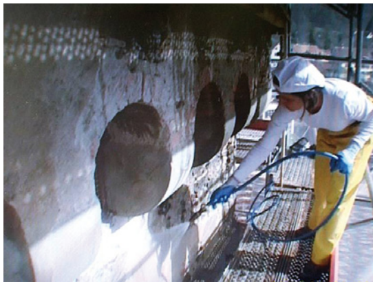
Bild 5: Behutsames Waschen der vorbereiteten Untergründe zur Aufnahme des Kalkanwurfs
