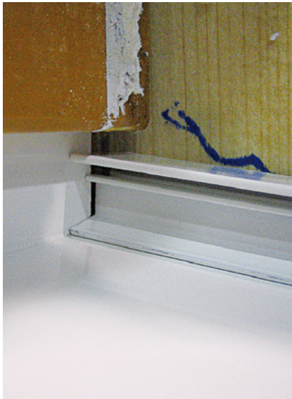
Bild 5: Wassereintritts- stelle im Bereich der Fensterbank- ecke (zweiteilige Alu-Fensterbank; Anschluss Fens- terbank mit End- profil) [Quelle: Holzforschung Austria]
