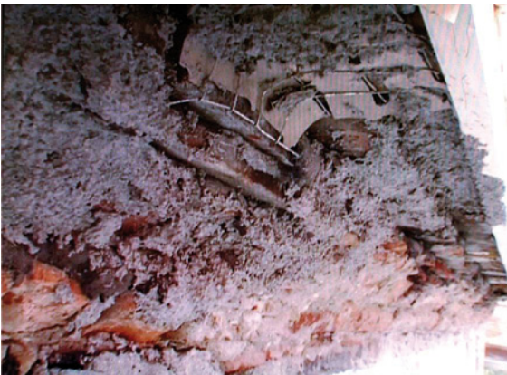
Bild 3: Kalkanwurf als Kontaktschicht auf Traufgesimse- Untersicht mit Einsatz von Stucanet als Putzträger über Holzwerk
