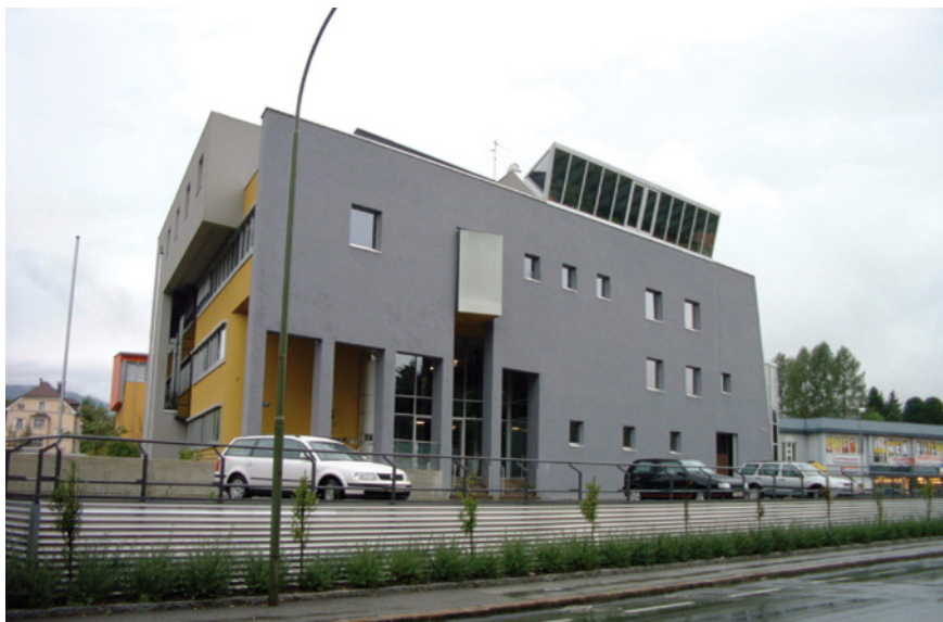
Bild 13: Objekt F: Moderne Architektur, auf Wasserführung verzichtet
