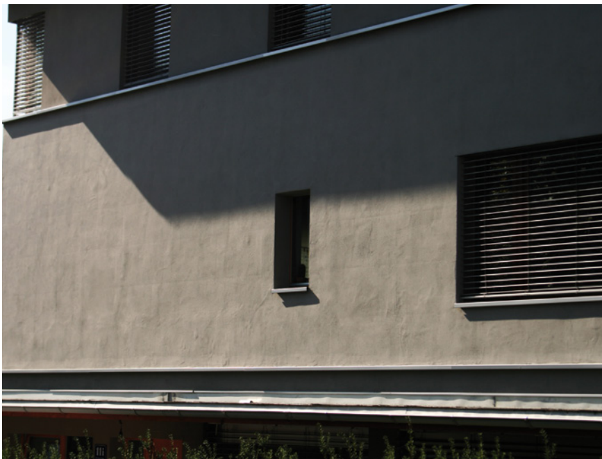
Bild 6: Fugenabzeichnung und hervortretende Dübelköpfe sind Anzeichen für Dämmstoffschwindung
