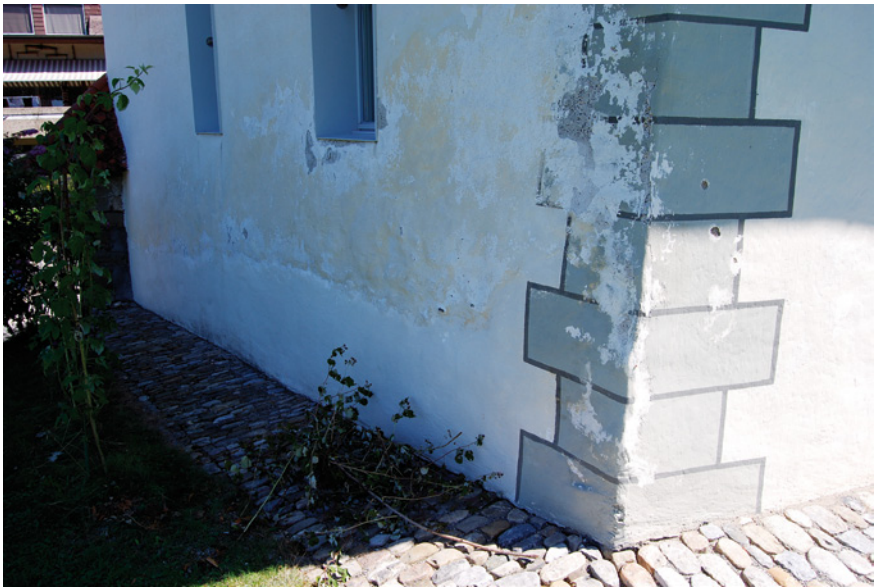
Bild 1: Verfärbungen und Verputzabplat- zungen über hydrophobiertem Sockelputz
