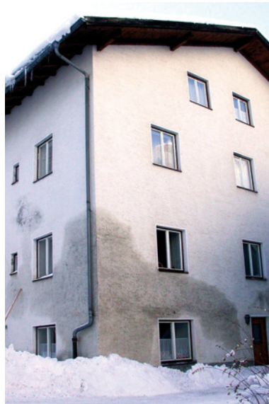
Bild 7: Der starken Nitratsalzbelastung der Fassadenputze dieses Gebäudes wurde bei der Sanierung keine Rechnung getragen, weshalb sich die Salze in den neuen Deckputz verlagerten und dort zu einer Feuchtebelastung führten
