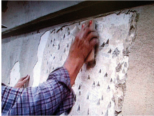
Bild 4: Das Aufrauen von glatten Kalk- schichten, damit ein mechanischer Verbund zum nachfolgenden Anwurf möglich wird
