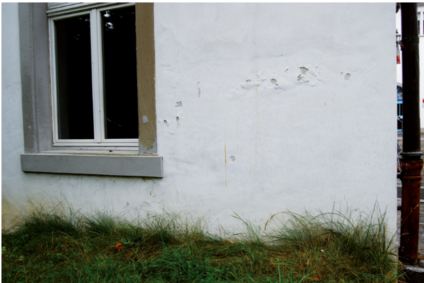
Bild 3: Verdunstungszone durch Hydropho- bierungen auf +/- 2 m erhöht
