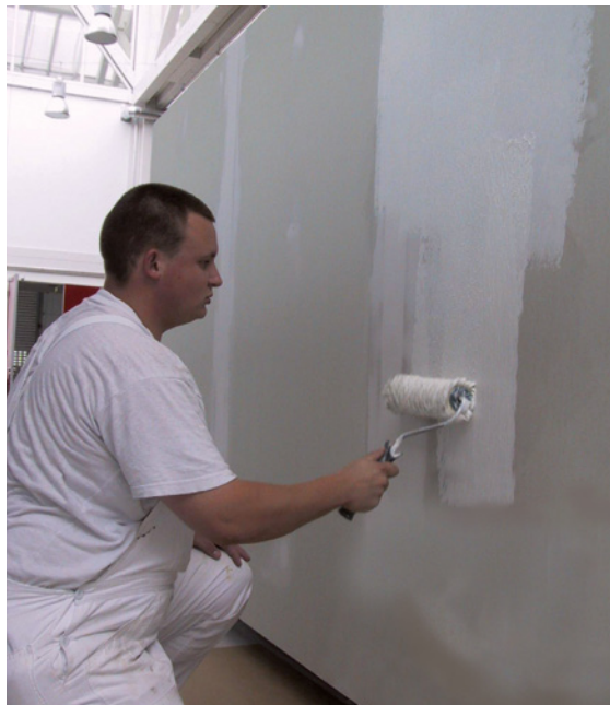
Bild 2: Grundierung, pigmentiert
