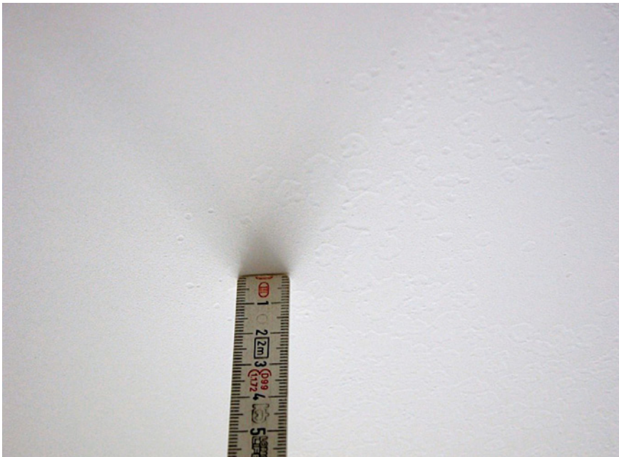
Bild 9: Bildung runder Aufwölbungen wahrscheinlich als Folge von Kondensatbildung im Gipsputz
