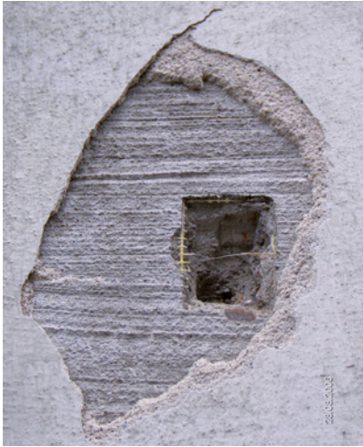
Bild 5: Hydrophobierte Ausgleichsschicht auf mineralischem Grundputz, Deck- putz rein minera- lisch, blättert großflächig ab
