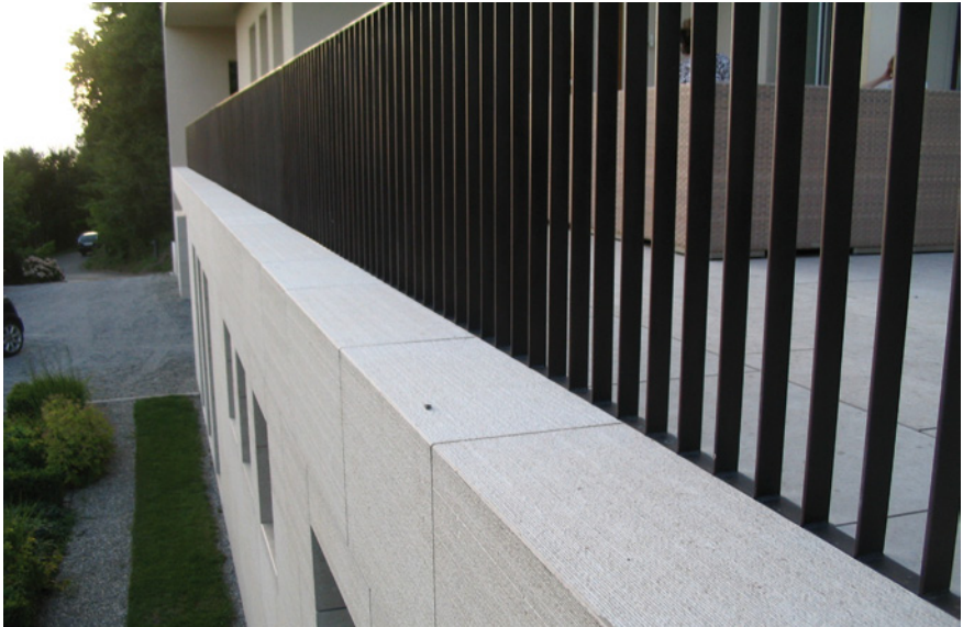
Bild 8: Objekt D: Kein konstruktiver Witterungsschutz
