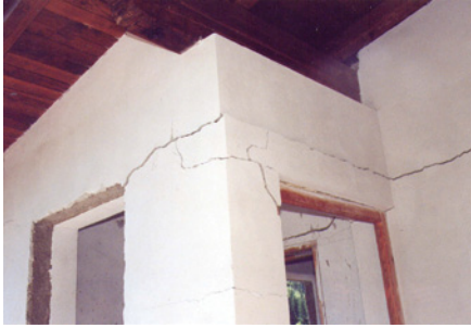
Bild 1: Falsches Anheben einer Bodenplatte bei einem Neben- gebäude in Selt- schach
