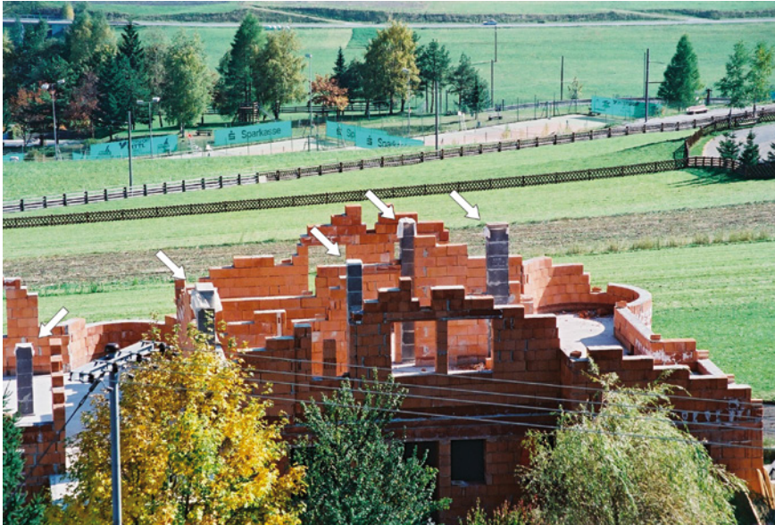
Bild 1: Geradezu akribisch werden hier die fünf frei stehenden Rauchfänge gegen Witterungseinfluss geschützt, während das gesamte Mauerwerk rundum völlig ungeschützt bleibt
