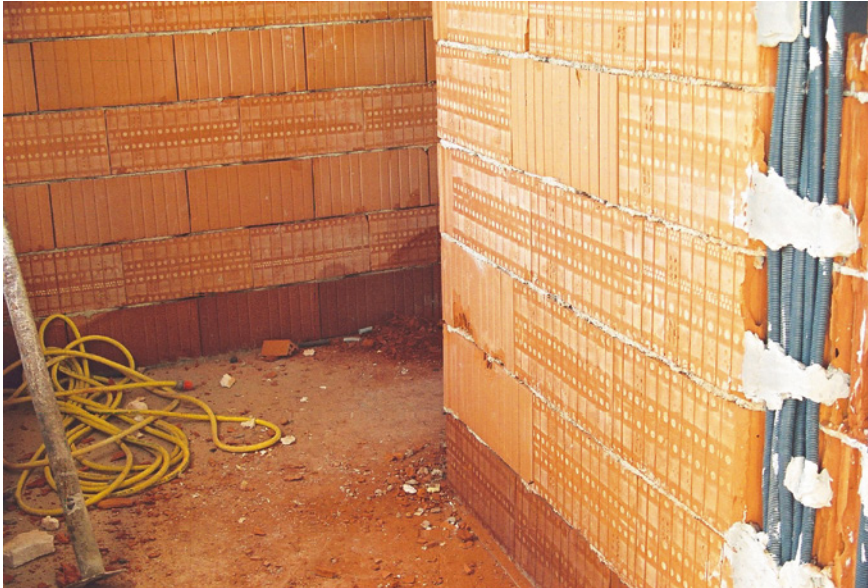
Bild 4: Ergänzung zu Bild 3; Die von außen eingedrun- gene Feuchtigkeit hat sich in der ersten Ziegelreihe hochgezogen
