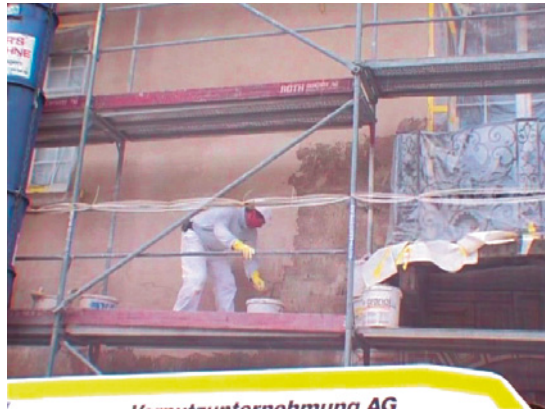
Bild 8: Applikation der Kalkschlänme als horizontal gebürsteten Deckputz
