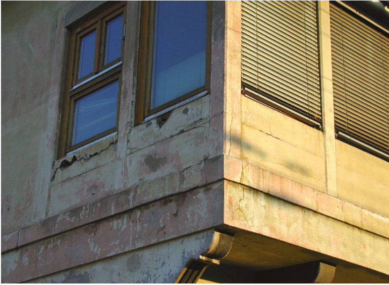
Bild 20: Risse zufolge Materialwechsels in einem Büro- gebäude (vor dem Abbruch)
