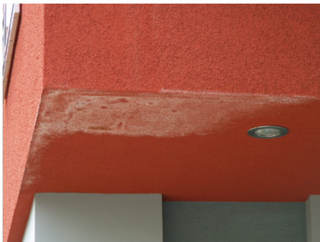
Bild 17: Objekt G: Wasseransamm- lung im System
