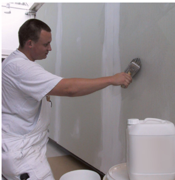
Bild 1: Grundierung, transparent
