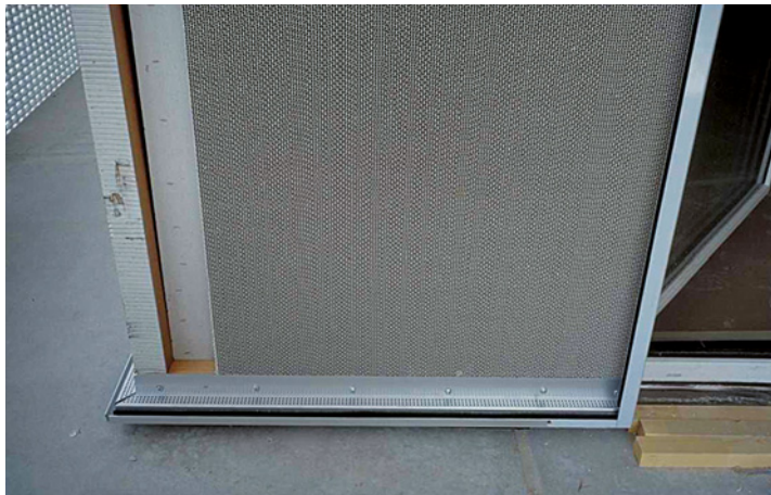
Bild 6: Zur späteren Ersetzbarkeit Schichten der Außenwand nur geschraubt und nicht verklebt, Möglichkeit des Ersatzes der Kartonwabenschicht durch ein Vacuum Insulated Panel
