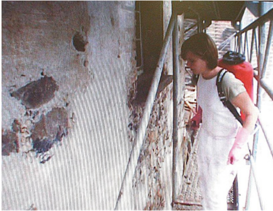
Bild 7: Tragfähigen Kalkputz mit neuem Calcium- hydroxid (Kalksin- ter- oder Kalk- casein-Wasser) durch mehrmali- ges Tränken nähren und verfestigen
