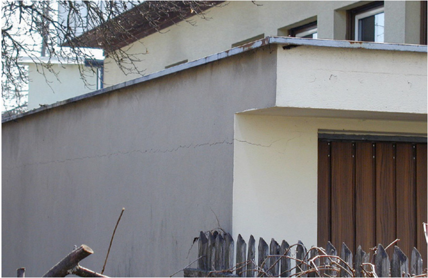
Bild 16: Aufschüsselung der Garagendecke bei einer Wohn- anlage
