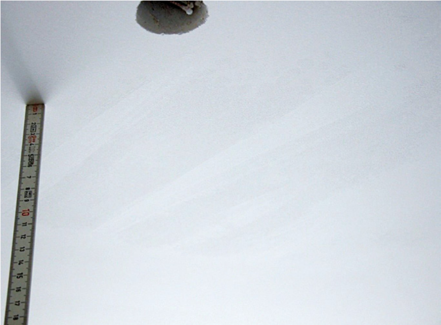
Bild 10: Striemenbildung aufgrund eines nicht ausreichend auf das Saugver- halten des Putzes abgestimmten Anstriches
