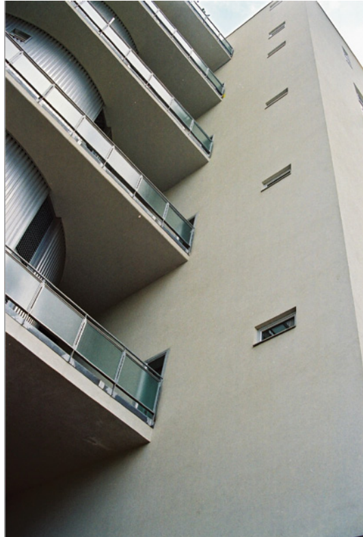
Bild 1: Objekt A: Fassade mit stumpf anstoßen- den Balkonplatten
