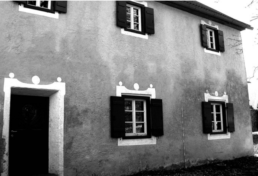
Bild 6: Die an der Fassade dieses Hauses bereits optisch erkennbare Feuch- tebelastung hat ihre Ursache in der hohen Belastung der Baustoffe mit hygroskopisch wirksamen Salzen
