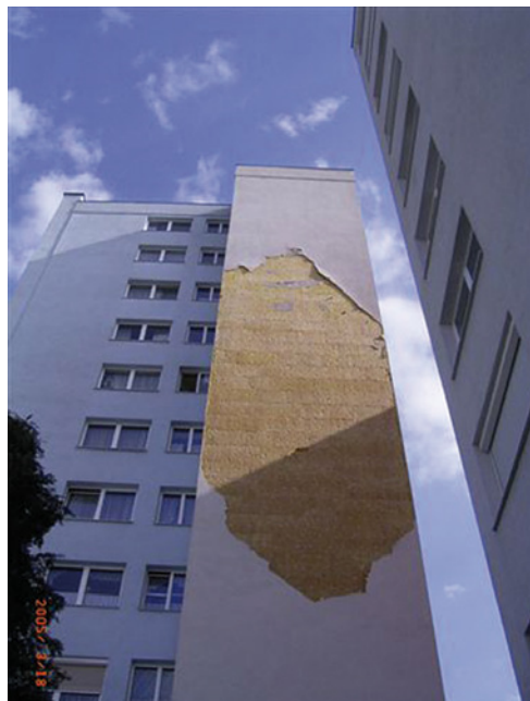
Bild 18: Objekt H: Deckschichtab- sturz nach starkem Wind
