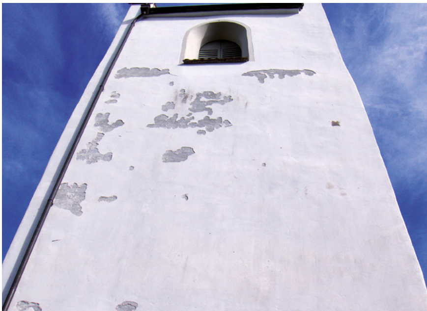
Bild 4: Das in den Deck- putz eindringende Meteowasser kann sich nicht in den Verputzquer- schnitt verteilen und staut sich an der hydrophoben Zwischenschicht
