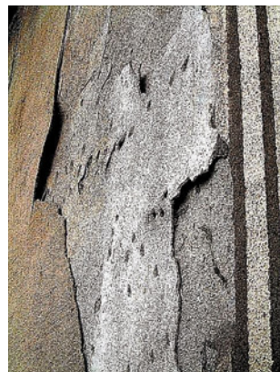
Bild 6: Nicht tragfähige Schichten sorgfältig mecha- nisch erschütte- rungsfrei entfer- nen
