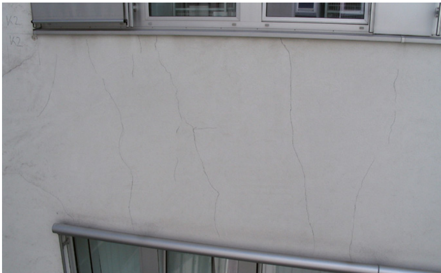
Bild 5: Objekt B: Ungünstige Flächenproportionen. Ausnahmslos vertikale Risse in der breiten niedrigen Fassadenfläche.
