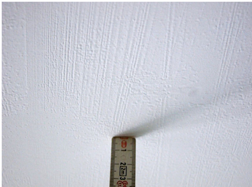
Bild 6: Starke, streifenartige Aufwölbungen des Anstrichs infolge Nachbearbeitung der Putzoberfläche vor Auftrag der Beschichtung
