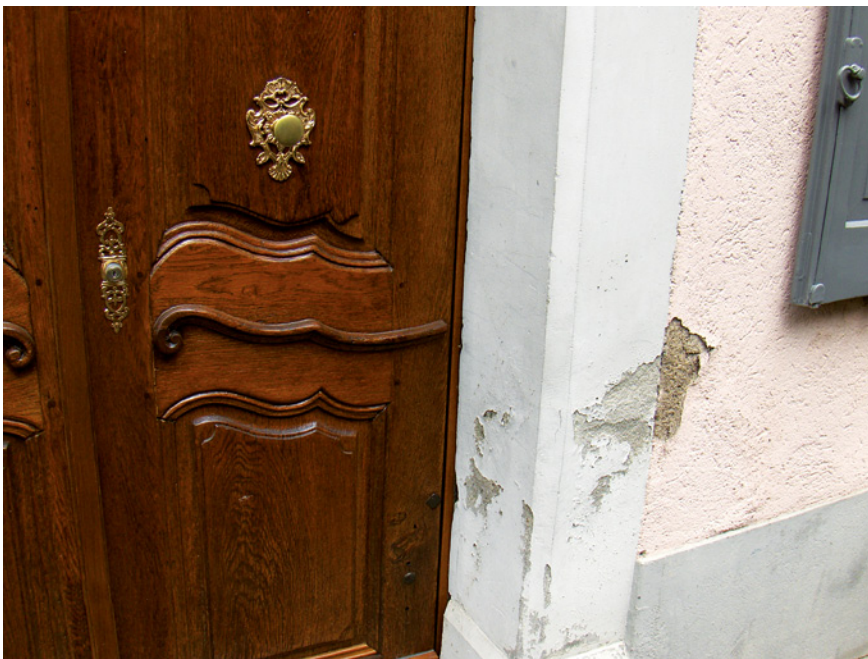
Bild 6: Aufgebaute Verdunstungs- horizonte unter hydrophoben Anstrichstoffen
