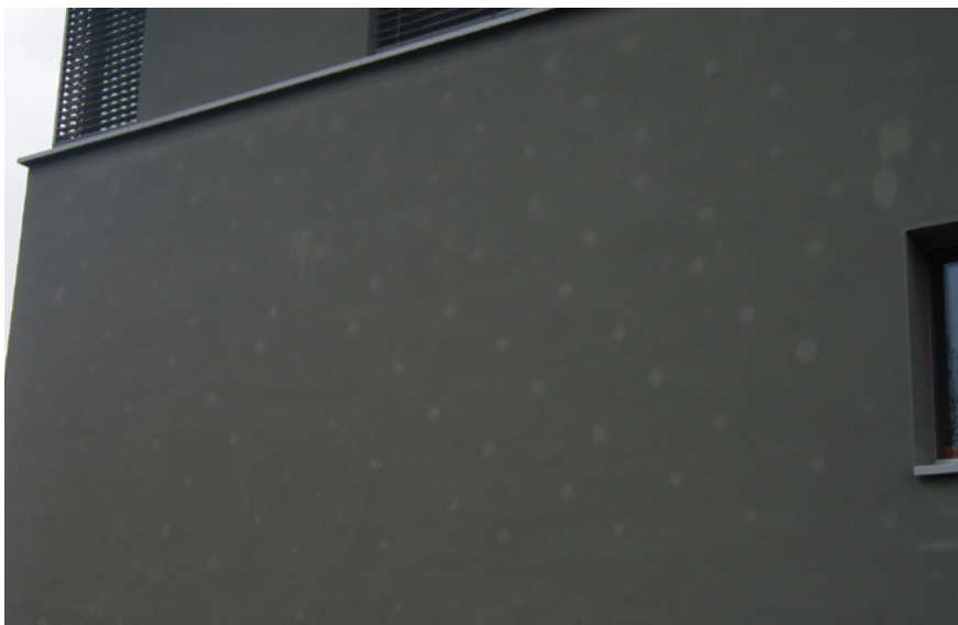
Bild 5: Abzeichnung der Dübelköpfe trotz Rondellen
