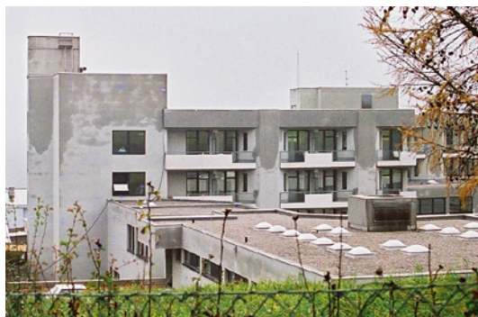
Bild 16: Wasserbelastung bereits nach kurzem Regen
