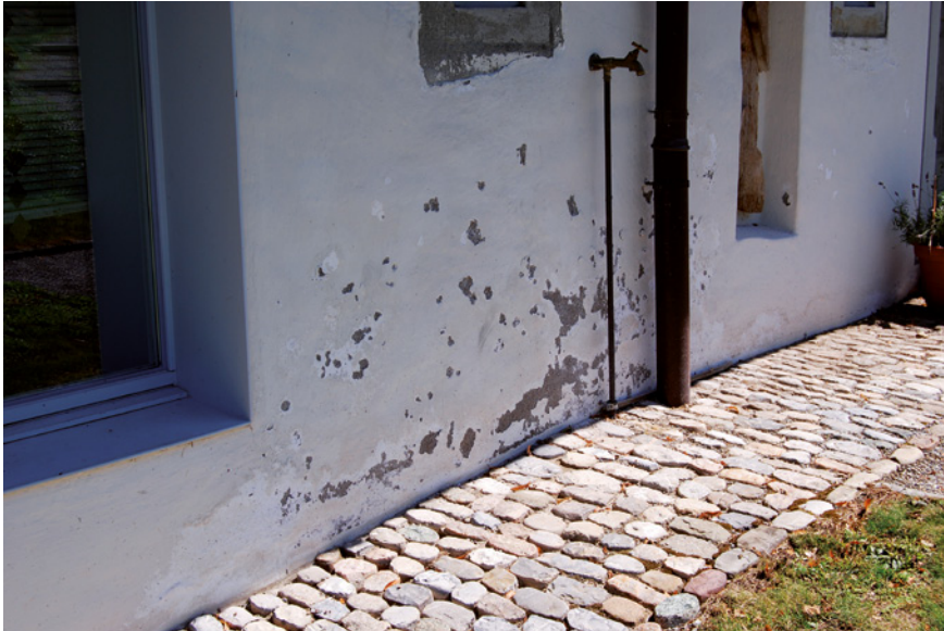
Bild 2: Farb- und Verputz- abplatzungen, dunkler Grund- putz mit feinem, weißem Deckputz, substanzieller Schaden gering, ästhetische Beein- trächtigung groß
