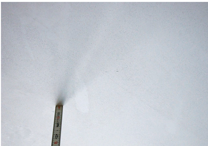
Bild 13: Heller Fleck, z. B. von lokal aufge- tragenem Isolier- anstrich (gegen Rostflecken)
