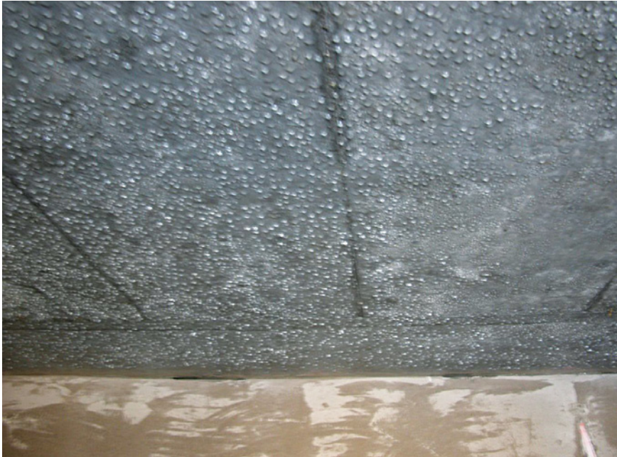
Bild 8: Starke Kondensatbildung an der Untersicht einer rohen Betondecke infolge hoher Luftfeuchtigkeit und eher tiefer Oberflächentemperaturen
