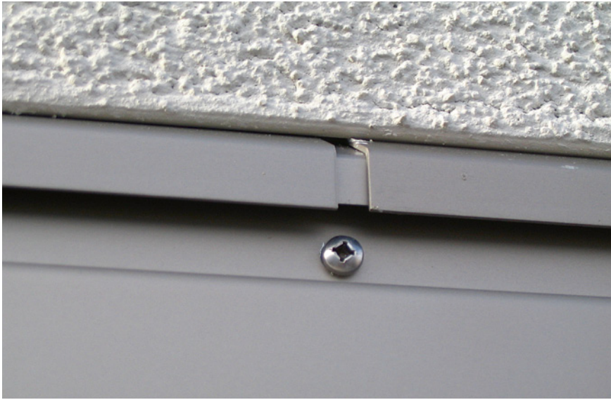
Bild 1: Das im Putz liegende Blech- anschlussprofil lässt auch thermische Verformungen von Metallbauteilen zu.
