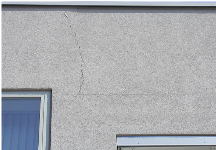
Bild 14: Auflagerbewegung in einem Gewerbebetrieb
