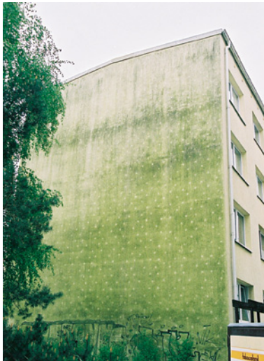
Bild 1: Besonders stark veralgte WDVS- Fassade, mit Dü- belabzeichnungen
