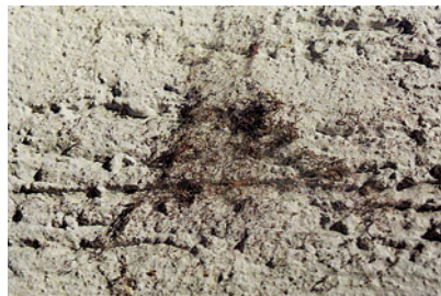
Bild 3: verschmutztes Netz an der Fassade
