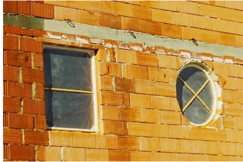
Bild 5: Mit Folien verschlossene Fensteröffnungen behindern den Abtransport von feuchter Innenluft und damit den Austrocknungs- prozess
