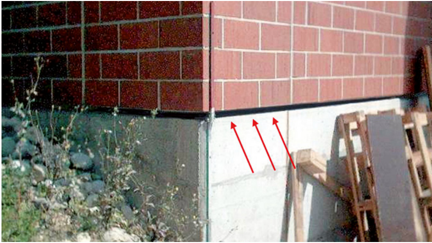
Bild 10: Offene Hinterlüftungs- fugen gestatten das Eindringen von Nagetieren und fördern eine Besiedlung durch Insekten
