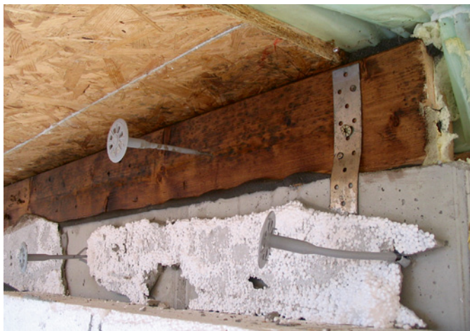
Bild 10: Ausdampfender Dachanschluss. Undichter Untergrund
