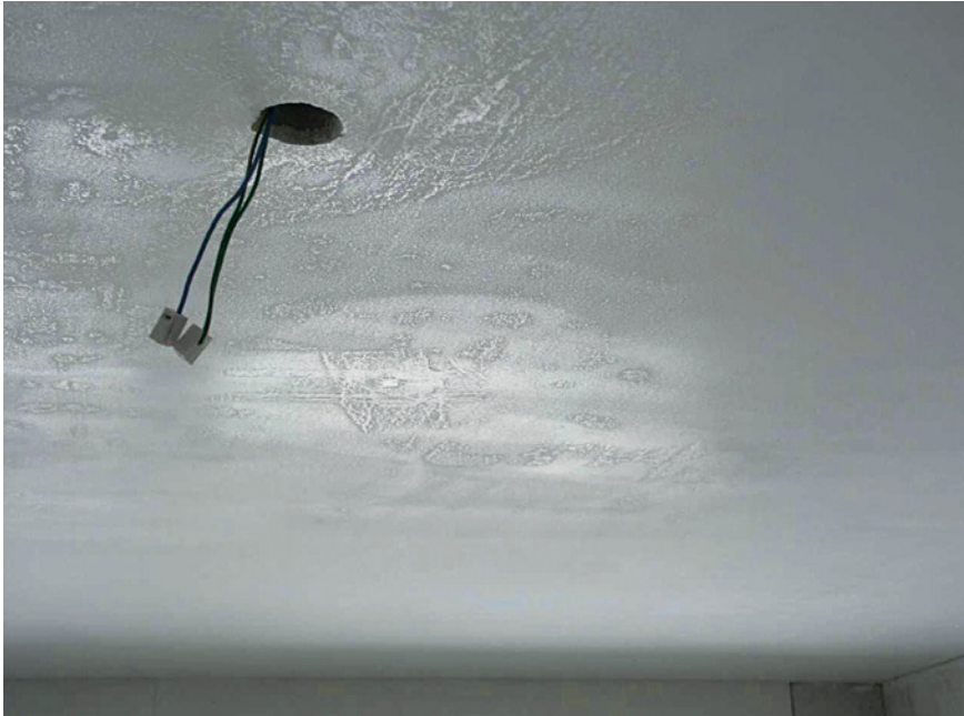
Bild 11: Wolken- und Striemenbildung aufgrund der Verwendung eines zu stark verdün- nten, gespritzten Anstriches
