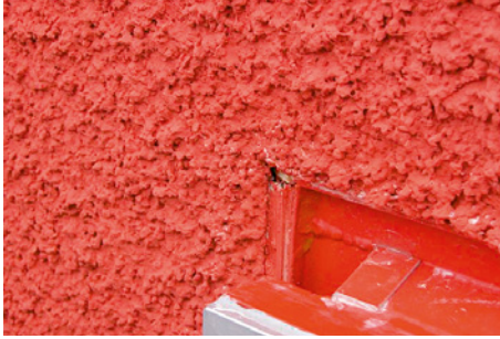
Bild 12: Undichter Anschluss des fassadenbündigen Fensterrahmens
