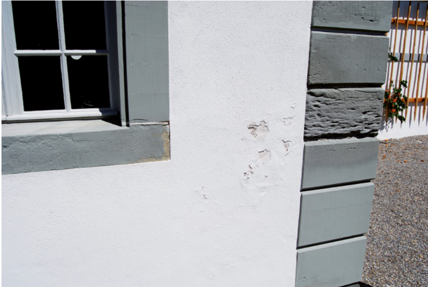
Bild 5: Konzentrierte Schäden über saniertem Bereich
