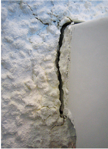
Bild 4: Putzabrissfugen im Bereich der Fensterbankab- schlüsse [Quelle: Holzforschung Austria]
