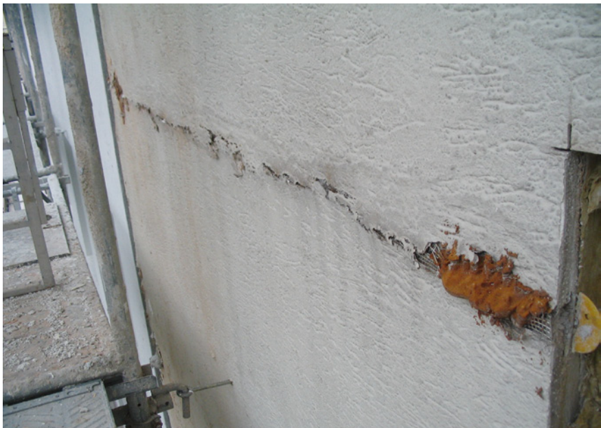
Bild 11: Objekt E: Waag- rechte Risse in Fläche mit einseitiger Längsausdehnung
