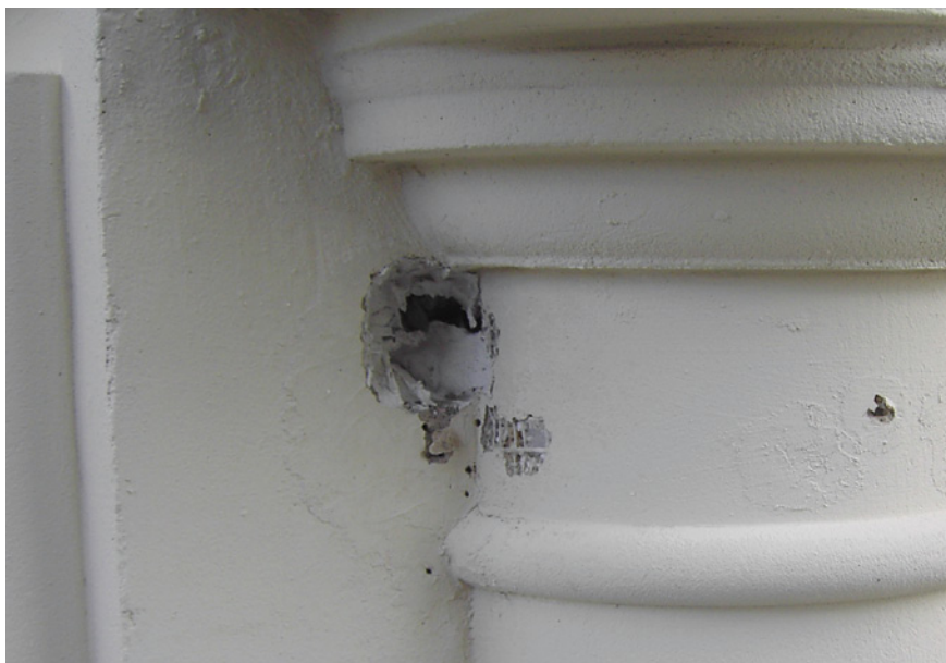
Bild 2: Der Specht deckt es auf: Diese Fassade ist kein echter Stuck, sondern Fer- tigstuck aus Polystyrol- Elementen
