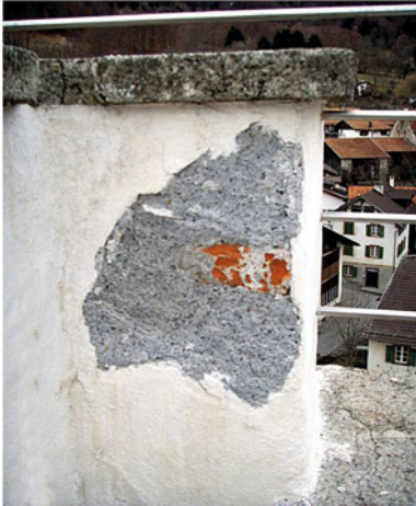
Bild 2: Frostschaden an einer Turmzinne wegen einer schadhaften Abdeckung
