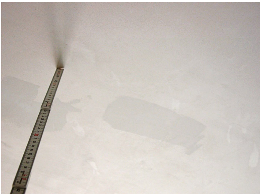
Bild 12: Dunklerer Fleck über einer Spach- telung
