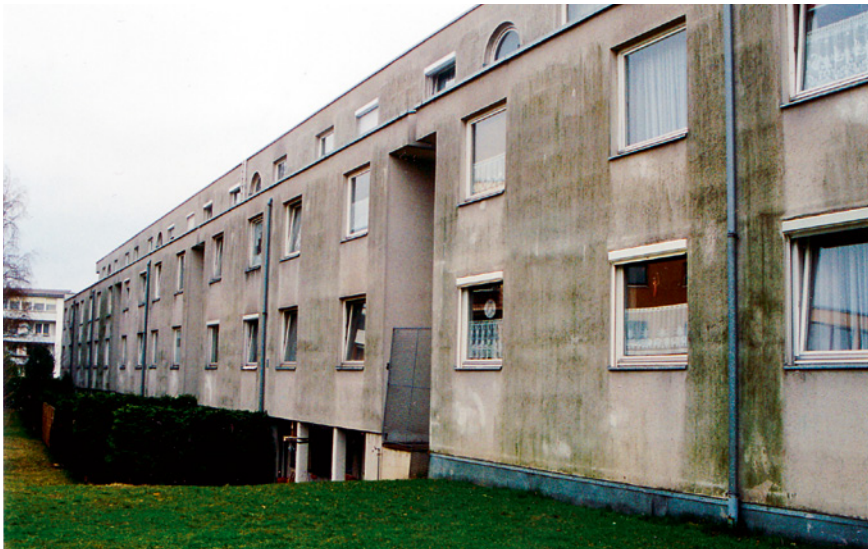
Bild 5 KKU-Architektur ist anfällig für Algenbefall
