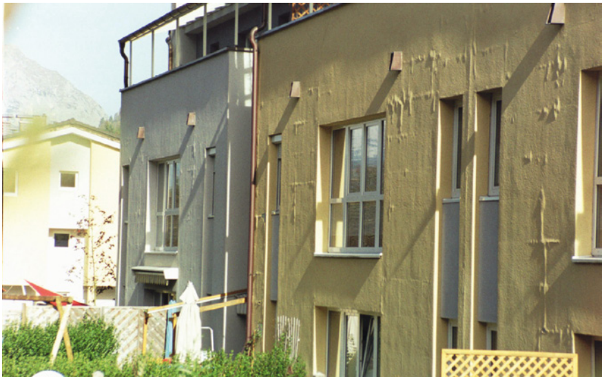
Bild 6: Objekt C: Deckschichtblasen wegen ver- hinderter Filmbildung
