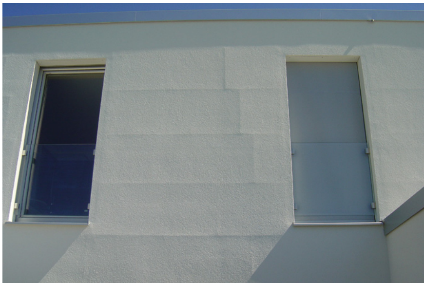
Bild 21: Objekt J: Jede WDVS-Weichfa- serdämmplatte zeichnet sich ab
