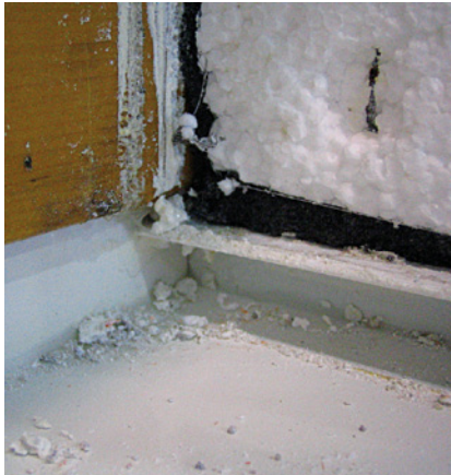
Bild 2: Schlecht eingebautes vorkomprimier- tes Dichtband (links zu wenig komprimiert; rechts zu straff um die Ecke gezogen) im Bereich der Leibung [Quelle: Holzforschung Austria]
