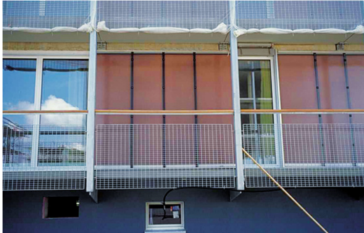
Bild 5: Mit Zellulosefasern gedämmte und außenseitig mit einer Kartonwabenschicht und Glaselementen verkleidete Außenwandkonstruktion
