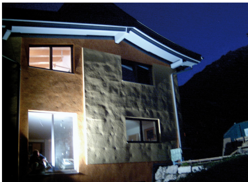
Bild 20: Objekt I: Mit Hilfe extremen Streif- lichts dokumen- tierte Aufwölbun- gen von HWF-Platten
