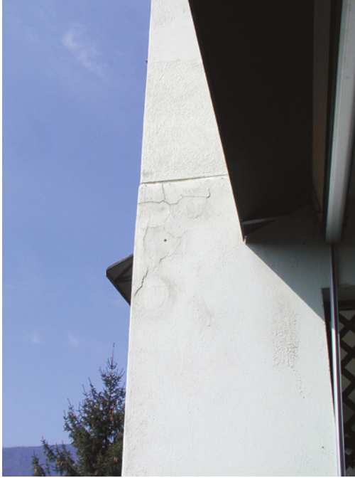
Bild 19: Kantenpressung von Fertigteilen in einem Wohnhaus
