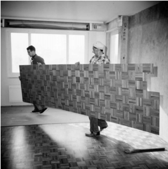
Abbildung 8: System Göhner, vorgefertigter Bodenbelag, September 1966
