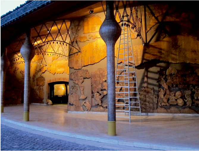
Bildtafel 3: Außenfassade des Gebäudes, Gestaltung Durga-Bai Vyam
