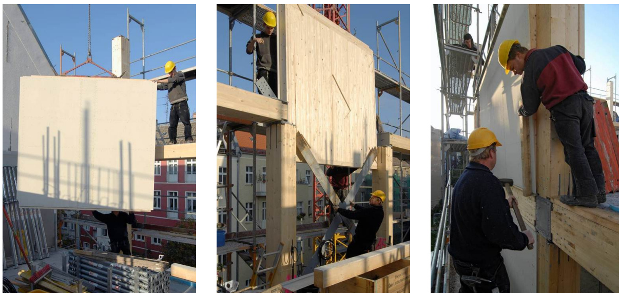
Abbildung 47: Platzsparender Aufbau in der Stadt durch die Verwendung industriell vorgefertigter Produkte
