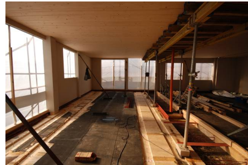
Abbildung 51: Innenausbau beim Holzhaus
