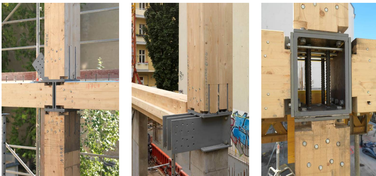
Abbildung 46: Detaillösungen im Holzmassivbau
