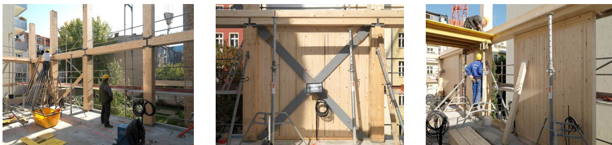
Abbildung 45: Bauphase des siebengeschossigen Holzhauses E3
