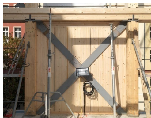
Abbildung 50: Stahlauskreuzungen zur Aussteifung
