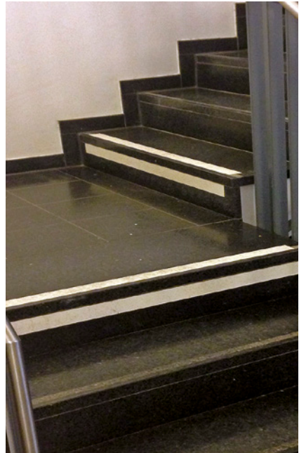
Bild 108 ■ Nachträglich aufgeklebte Stufenmarkierung im Abstand zur Stufenvorderkante auf einer Treppe mit gefliestem Stufenbelag
