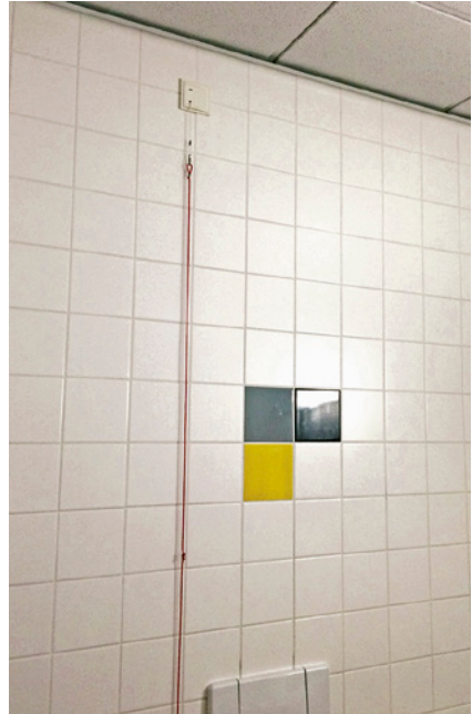
Bild 61 ■ Notrufzugschalter mit roter Schnurverlängerung vor einer weiß gefliesten Wand)
