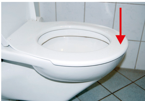
Bild 50 ■ Vertikaler Messpunkt der Sitzhöhe eines WCs
