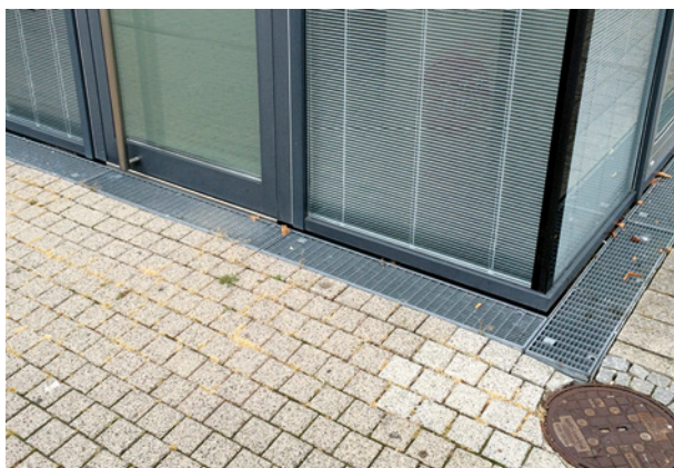
Bild 8 ■ Gitterrost des Entwässerungssystems vor einer erdberührten schwellenfreien Außentür
