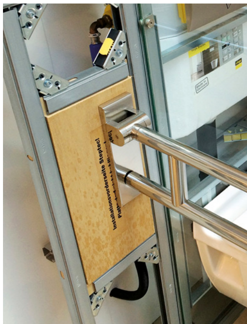
Bild 52 ■ Befestigungspunkt eines Stützklappgriffs
