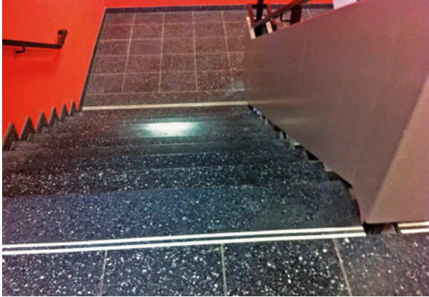
Bild 110 ■ Doppelliniger Streifen am Treppenende
