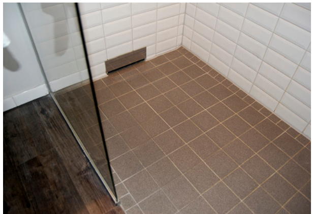
Bild 76 ■ Gefliester Duschplatz mit einer Wandentwässerung
