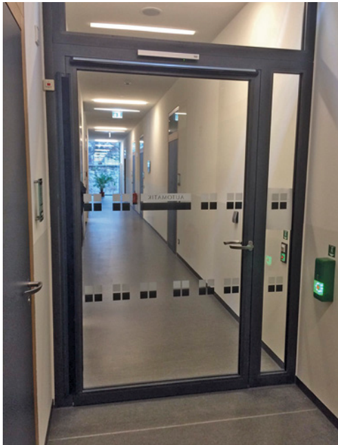
Bild 136 ■ Glasmarkierung im Wechselkontrast an einer Glastür mit seitlicher Festverglasung
