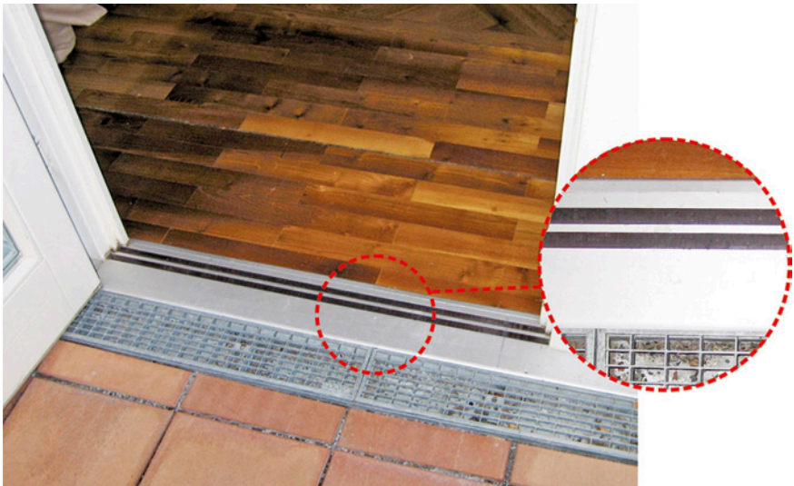
Bild 1 ■ Schwellenfreie Außentür
