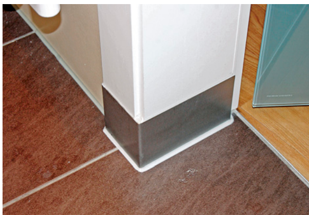
Bild 41 ■ Schutz des unteren Anschlusspunktes einer Türzarge durch ein Edelstahlblech
