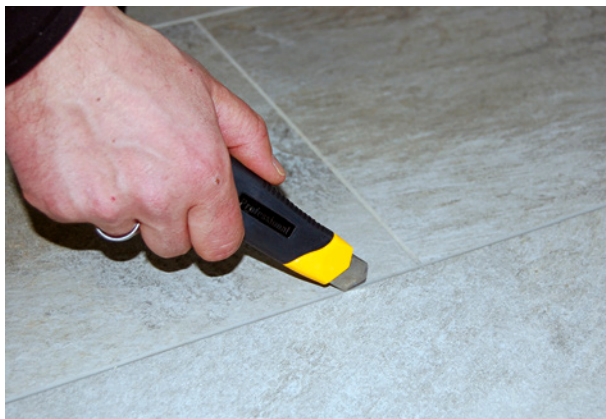
Bild 81 ■ Zerstörende Ablösung einer elastomerbasierten Wartungsfuge (Silikon) mit einem Cuttermesser
