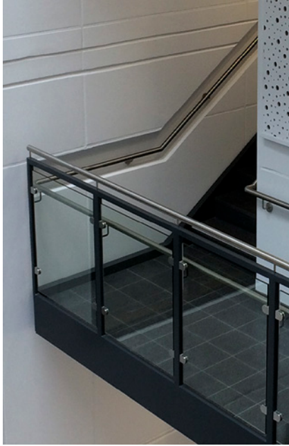
Bild 99 ■ In die Außenwandseite der Treppe eingebrachte Handläufe
