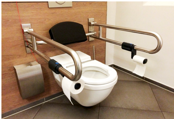
Bild 53 ■ WC mit Rückenstütze an der Stützklappgriffkonstruktion
