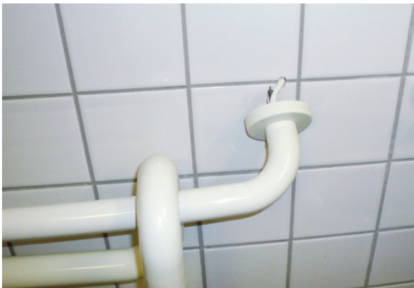
Bild 83 ■ Überlastetes Befestigungssystem eines Duschsitzes
