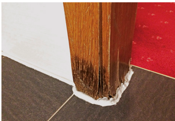
Bild 38 ■ Zerstörungen an einer Holztürzarge durch Quellungen sowie Schimmel
