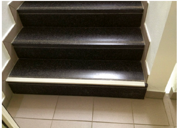
Bild 121 ■ Eingebautes Stufenprofil aus Kunststoff an Bestandstreppe aus Naturstein
