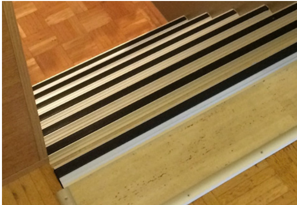
Bild 118 ■ Nachgerüstete Stufenmarkierungen mit Profilschienen
