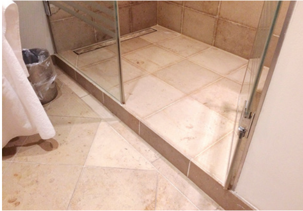
Bild 72 ■ Schwelle vor einem als niveaugleich vorgesehenen Duschplatz
