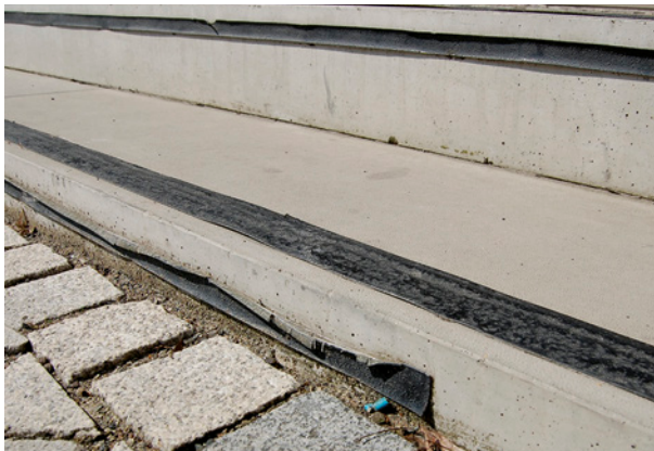
Bild 105 ■ Detail der nachträglich aufgetragenen Stufenmarkierung nach ca. zwei Jahren
