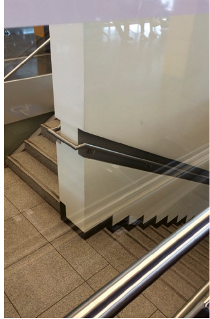
Bild 99 ■ In die Außenwandseite der Treppe eingebrachte Handläufe
