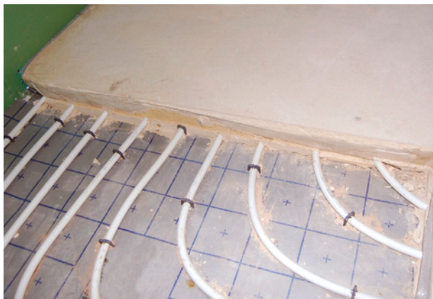
Bild 80 ■ Warmwasser-Fußbodenheizung ohne Separierung der Heizkreise
