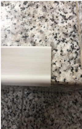
Bild 121 ■ Eingebautes Stufenprofil aus Kunststoff an Bestandstreppe aus Naturstein
