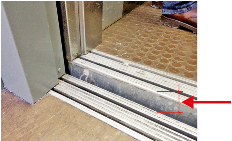
Bild 92 ■ Vertikaler Höhenunterschied beim Halt zwischen dem Fahrkorb und der Fahrschachttürschwelle
