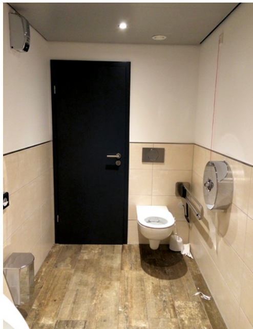
Bild 69 ■ Unterlassung der beidseitigen Anordnung von zwei Stützklappgriffen
