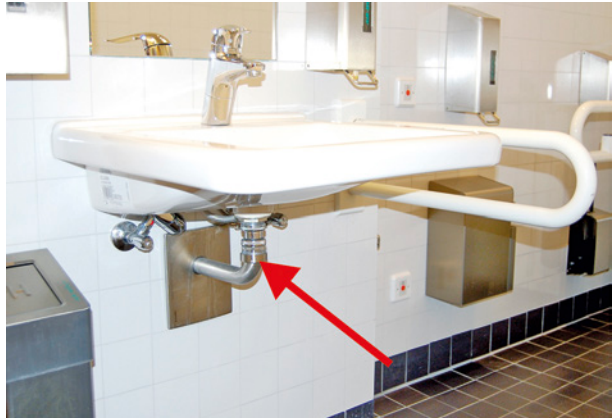
Bild 54 ■ Zulauf zu einem in die Wand integrierten Geruchsverschluss an einem unterfahrbaren Waschtisch
