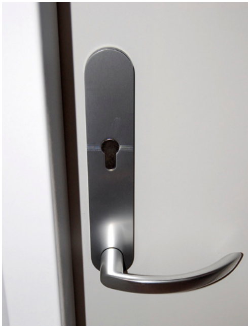
Bild 28 ■ Türdrücker mit darüber liegendem Schlüsselloch
