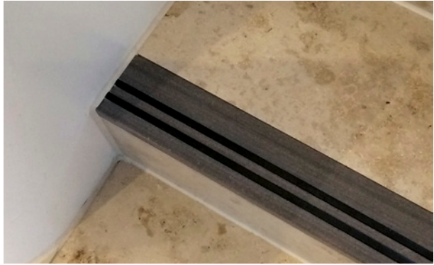
Bild 115 ■ Im Treppenbelag integrierte Stufenmarkierung
