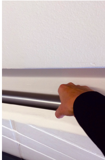
Bild 102 ■ Nachträglich in die Außenwandseite der Treppe eingebrachter Handlauf
