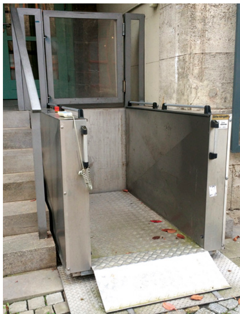
Bild 89 ■ Plattformlift mit Anrampung
