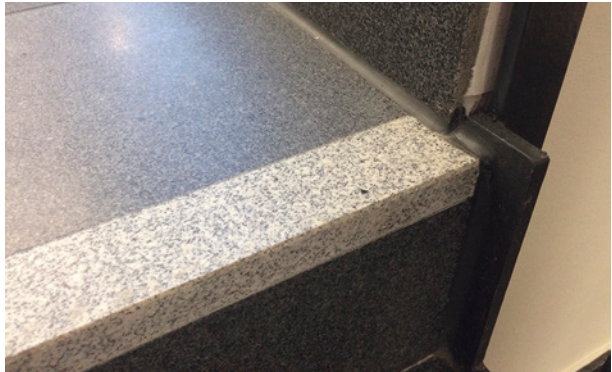
Bild 116 ■ Im Treppenbelag integrierte Stufenmarkierung
