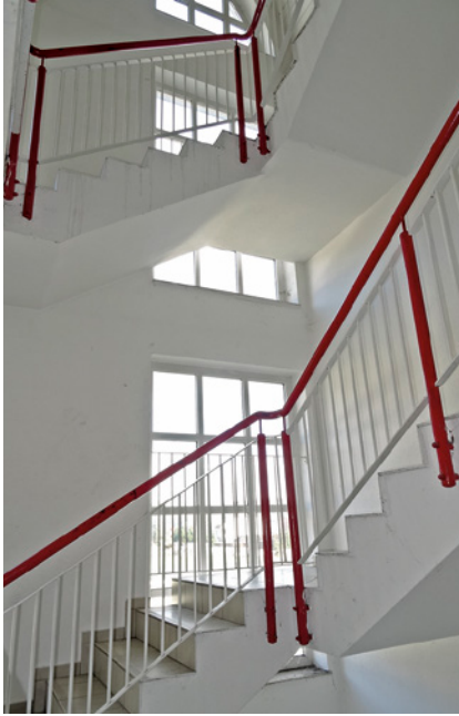
Bild 94 und Bild 95 ■ Treppen mit einseitigem Handlauf
