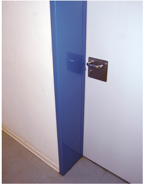
Bild 32 ■ Innentür mit einer übergroßen Laibungstiefe
