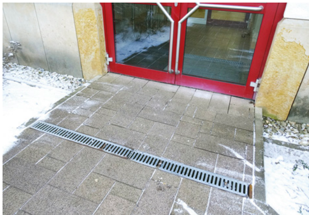
Bild 12 ■ Entwässerungssystem mit Lochschlitzabdeckung vor einer Außentür
