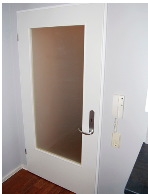
Bild 26 ■ Positionierung der Drehachse eines Türdrückers auf 85 cm Höhe
