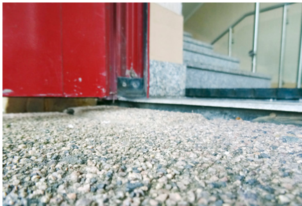
Bild 13 ■ Unplanmäßige Schwelle vor einer niveaugleichen Türkonstruktion aufgrund von Geländesetzung
