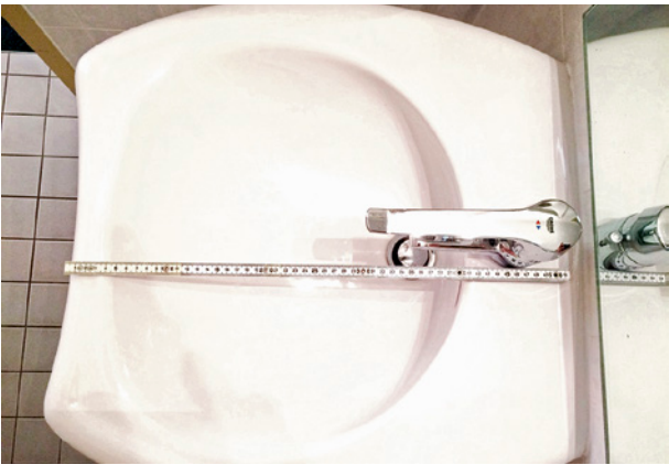
Bild 56 ■ Waschtisch mit Darstellung des Abstands zur Bedienung der Armatur
