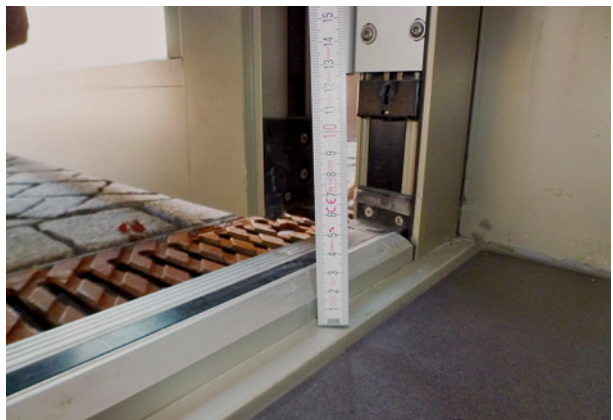
Bild 3 ■ Schwellen vor und innerhalb der Konstruktion der Eingangstür
