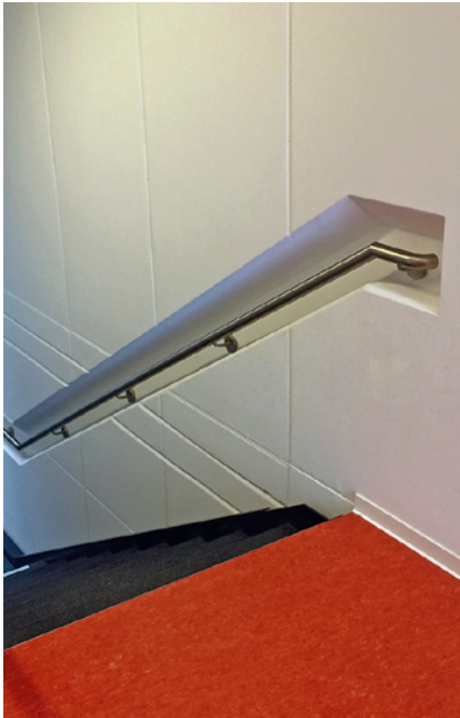
Bild 102 ■ Nachträglich in die Außenwandseite der Treppe eingebrachter Handlauf
