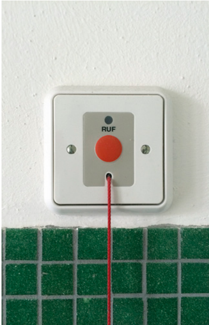
Bild 60 ■ Notrufzugschalter mit roter Schnurverlängerung
