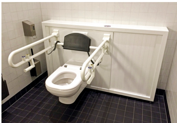
Bild 49 ■ Horizontal verschiebbares WC-System
