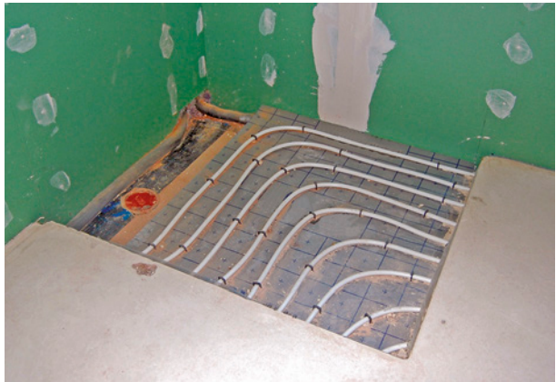
Bild 79 ■ Niveaugleicher Duschplatz in Verbindung mit einer Warmwasser-Fußbodenheizung
