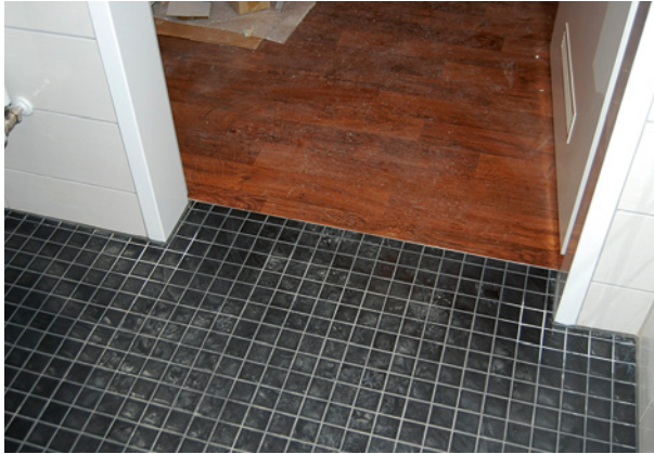
Bild 36 ■ Schwellenfreie Ausführung einer Innentür zu einem Sanitärraum mit Belagswechsel
