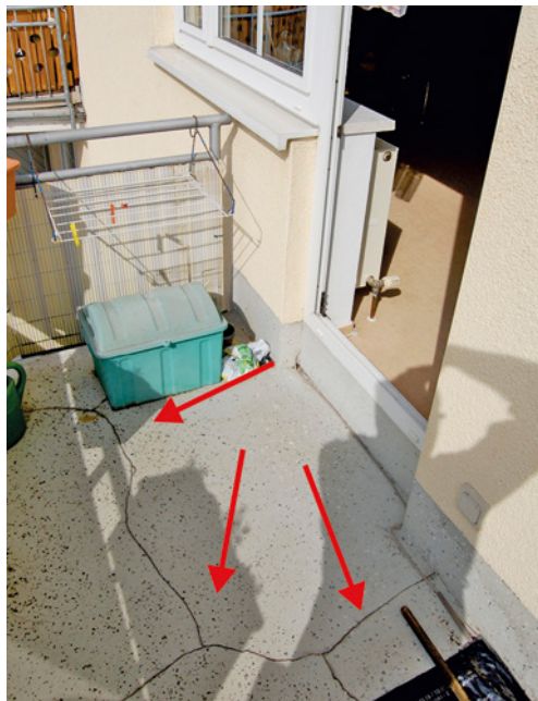
Bild 20 ■ Risse in der Abdichtung
