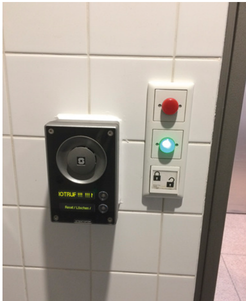
Bild 62 ■ Beispiel eines Notrufschalters mit digitaler Anzeige
