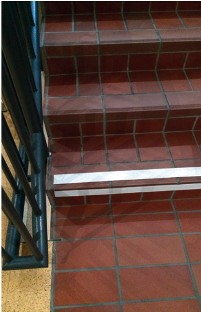
Bild 108 ■ Nachträglich aufgeklebte Stufenmarkierung im Abstand zur Stufenvorderkante auf einer Treppe mit gefliestem Stufenbelag
