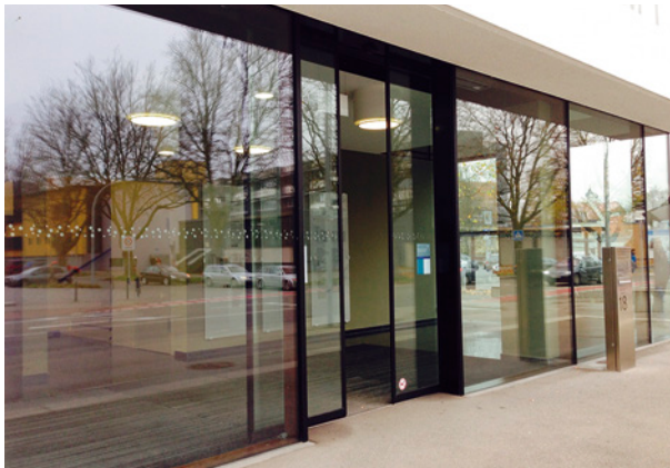
Bild 133 ■ Eingangssituation in einer Glasfassade mit Glasmarkierungen
