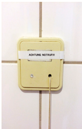
Bild 58 ■ Notruffschalter – Zugtaster mit Zugschnur
