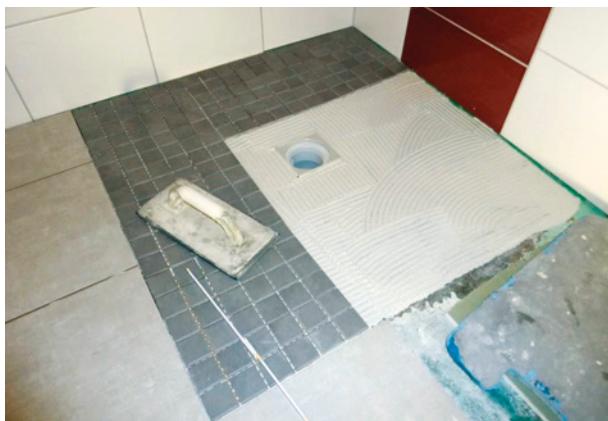
Bild 74 ■ Gefliester Duschplatz vor der Fertigstellung
