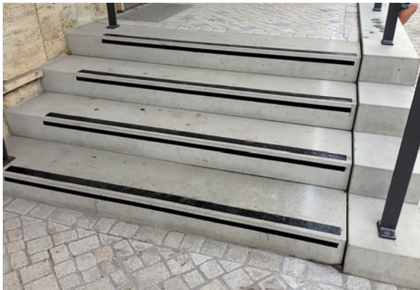
Bild 104 ■ Nachträglich aufgetragene Stufenmarkierung
