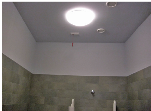
Bild 58 ■ Notruffschalter – Zugtaster mit Zugschnur
