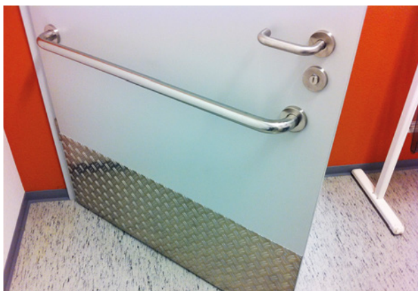
Bild 30 ■ Zuziehhilfe unterhalb des Türdrückers an einem Türflügel
