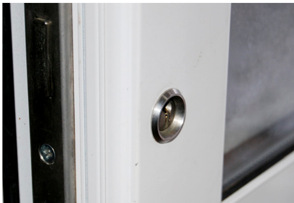
Bild 29 ■ Konkav gestaltete Einfassung eines Schließzylinders
