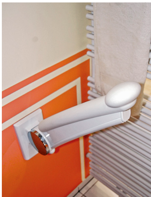
Bild 67 ■ Stützklappgriff in einer frei wählbaren Klappposition
