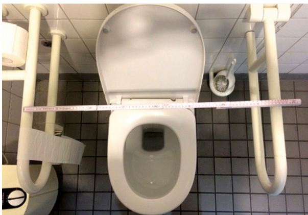
Bild 47 ■ Darstellung der Längen und des Abstands zwischen dem Stütz- sowie Stützklappgriff
