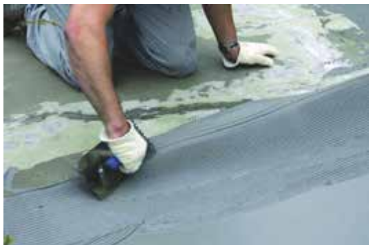
Abb. 5: Auftrag einer flexiblen Schlämme (Foto: PCI-Augsburg GmbH)
