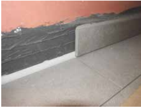
Abb. 13 Einbau eines Schnittschutzes vor einer Verbundabdichtung (links: Estrich-Wand, rechts: Wand-Wand)
