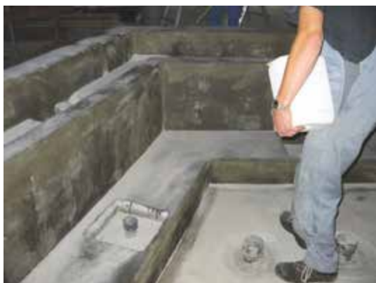
Abb. 6: Aufbringen einer Reaktionsharzabdichtung, hier: Grundierung/Abstreuerung (Foto: Sopro Bauchemie GmbH)
