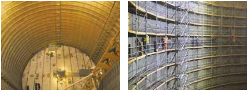
Bild 5: Verstärkung eines Zuckersilos mit Carbonbeton (Foto: Ammar Al-Jamous)
