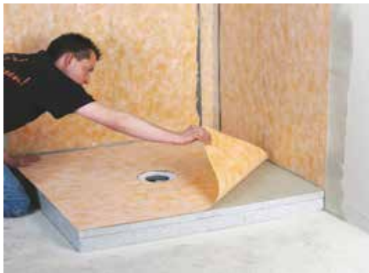
Abb. 15: XPS-Formteil für die Konstruktion einer bodengleichen Dusche mit bahnenförmiger Verbundabdichtungen (Foto: Fa Schlüter/Systems KG)
