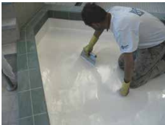
Abb. 7: Aufbringen einer Reaktionsharzabdichtung, hier: Applikation Boden (Foto: Sopro Bauchemie GmbH)
