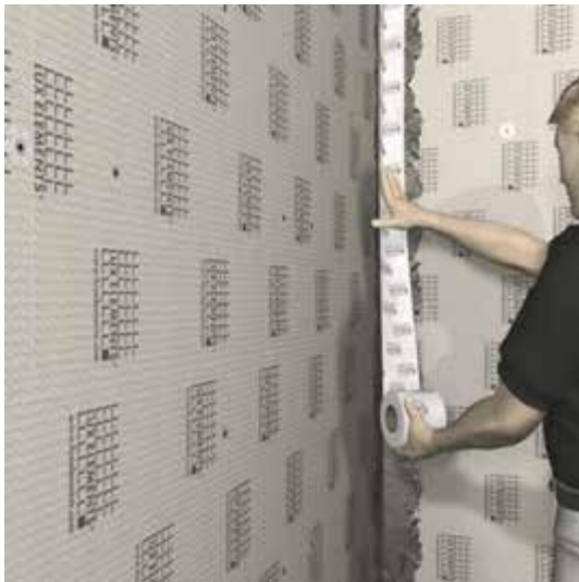
Abb. 9: Abdichten der Plattenstöße im Spritzwasserbereich mit Dichtungsbändern (Foto: LUX ELEMENTS GmbH & Co. KG)
