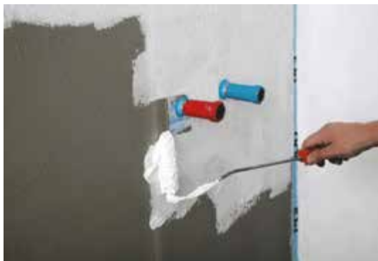
Abb. 4: Auftrag einer Polymerdispersion (Foto: PCI-Augsburg GmbH)
