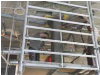
Bild 4: Verstärkung von Stahlbetonstützen mit Carbonbeton (Foto: Ammar Al-Jamous)
