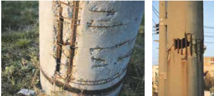
Bild 6: Vorhandene Schäden an Stahlbetonmasten (Foto: Ammar Al-Jamous)
