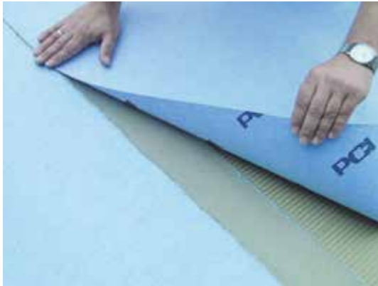
Abb. 8: fehlstellenfreies Verkleben der Stöße mittels flexibler Dichtungsschlämme (Foto: PCI-Augsburg GmbH)
