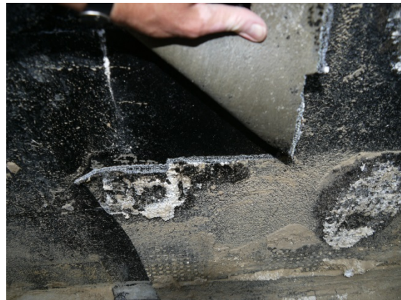
Bild 5: ohne Kraftaufwand vom Untergrund abgelöste Abdichtung
