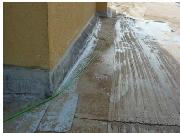
Bild 4: Ansicht der überarbeiteten Abdichtungsabschlüsse vor der Komplettsanierung
