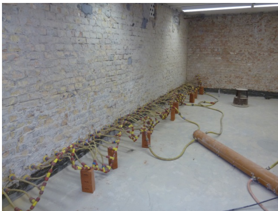
Bild 6: thermisch konvektive Vortrocknung
