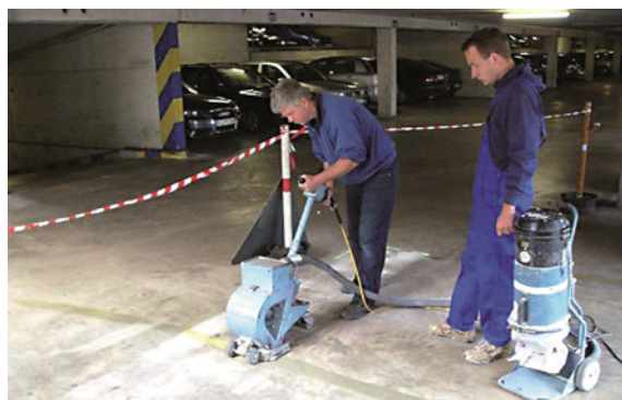
Bild 7: Kugelstrahlen für die Herstellung von Probeflächen der Parkdeckinstandsetzung
