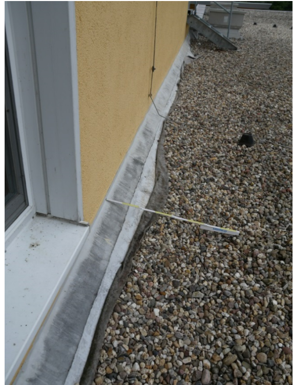
Bild 3: Ansicht der straff gespannten Abdichtungsabschlüsse entlang des angrenzenden Gebäudes
