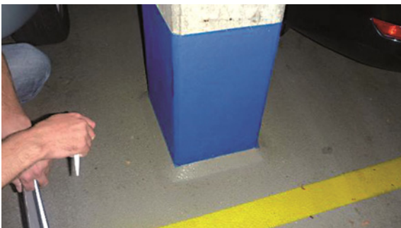
Bild 11: Instandsetzung der Stützenfüße
