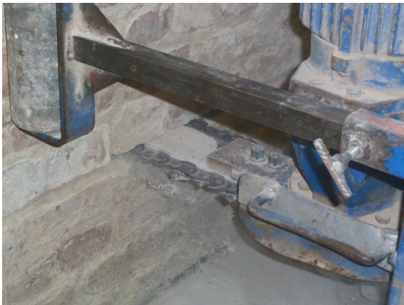
Bild 1: mechanische Verfahren - hier das Mäuersägeverfahren - sind häufig an durchgehende Lagerfugen gebunden
