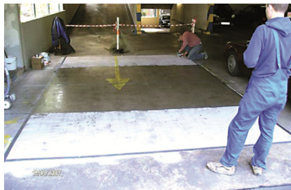
Bild 8: Herstellung von Probeflächen der Parkdeckinstandsetzung
