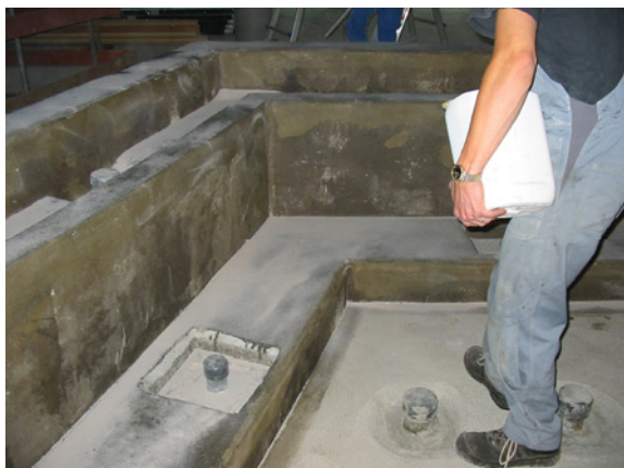
Bild 6: Aufbringen einer Reaktionsharzabdichtung, hier: Grundierung/Abstreuerung (Foto: Sopro Bauchemie GmbH)
