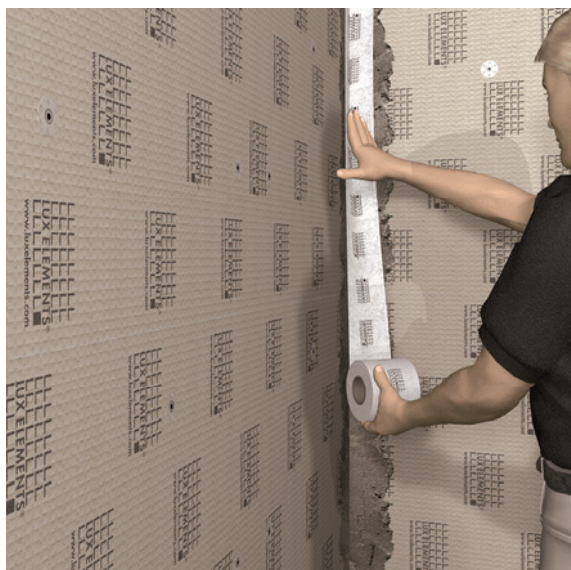
Bild 9: Abdichten der Plattenstöße im Spritzwasserbereich mit Dichtbändern (Foto: LUX ELEMENTS GmbH & Co. KG)
