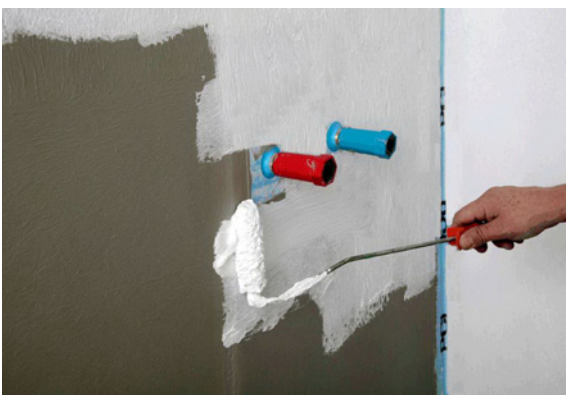
Bild 4: Auftrag einer Polymerdispersion (Foto: PCI-Augsburg GmbH)
