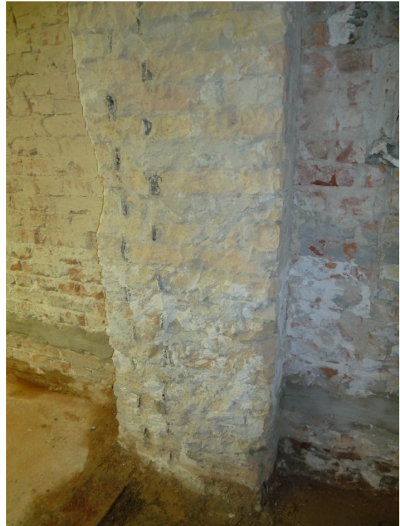
Bild 2: senkrechte Flachstähle im Mauerwerksverband - Querschnittsabdichtung mit mechanischen Verfahren ausgeschlossen
