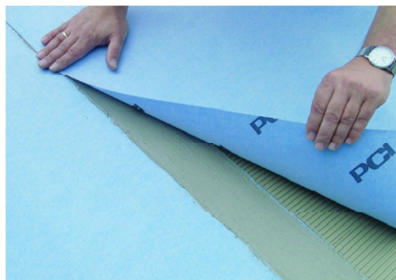
Bild 8: fehlstellenfreies Verkleben der Stöße mittels flexibler Dichtungsschlämme (Foto: PCI-Augsburg GmbH)
