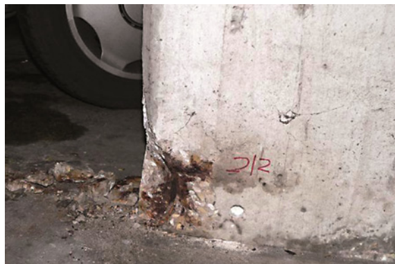
Bild 6: Fuß einer Stütze im Pfützenbereich
