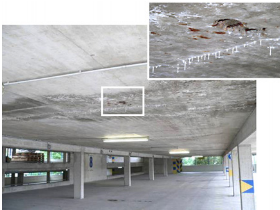
Bild 4: Rissbereich in einer Deckenplatte eines unbeschichteten Parkdecks
