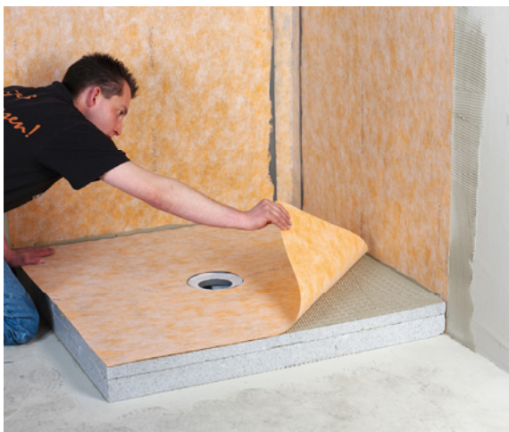
Bild 15: XPS-Formteil für die Konstruktion einer bodengleichen Dusche mit bahnenförmiger Verbundabdichtung (Foto: Fa Schlüter-Systems KG)
