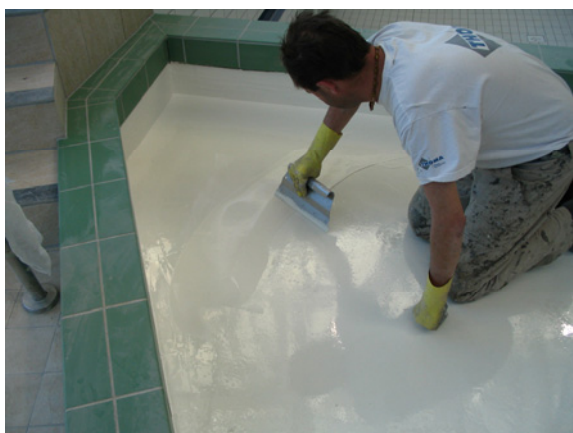
Bild 7: Aufbringen einer Reaktionsharzabdichtung, hier: Applikation Boden (Foto: Sopro Bauchemie GmbH)
