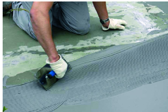
Bild 5: Auftrag einer flexiblen Schlämme (Foto: PCI-Augsburg GmbH)
