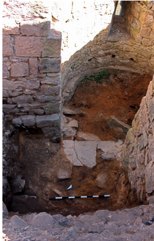
Bild 6 Blick auf die Sohle eines Flankierungsturmes mit den gut erkennbaren Balkenlöchern (hangseitig) der bauzeitlichen Fußbodenkonstruktion
