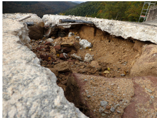
Bild 4 Bauteilöffnung der Mauerkrone mit Erdverfüllung
