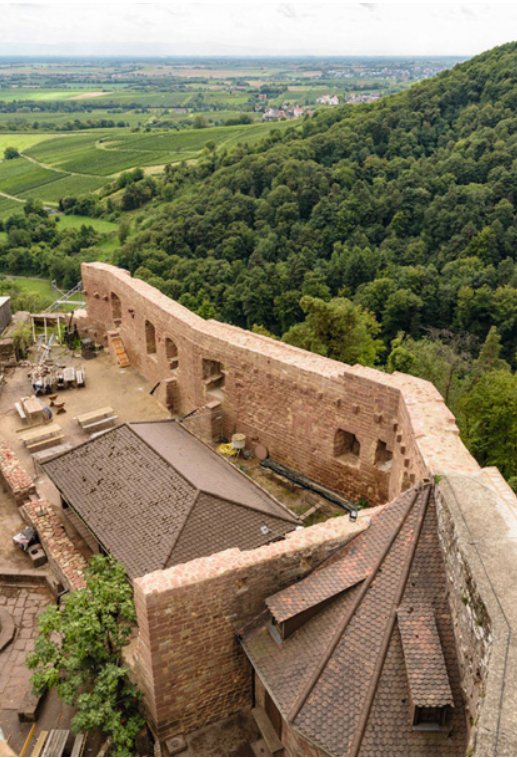
Bild 10 Verfüllen des Wehrgangs mit Aufmauerung der Mauerkrone
