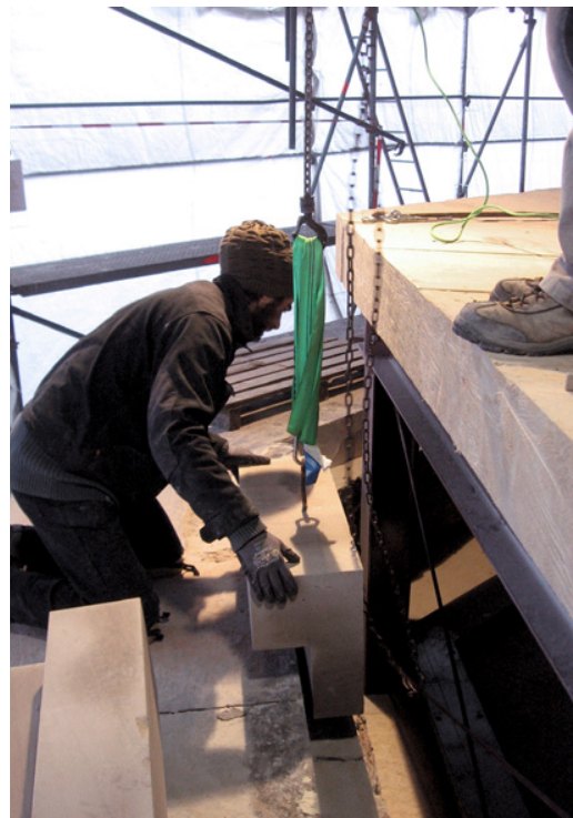
Bild 30 Kranhub eines Traufgesims- steines, Länge ca. 1,80 m
