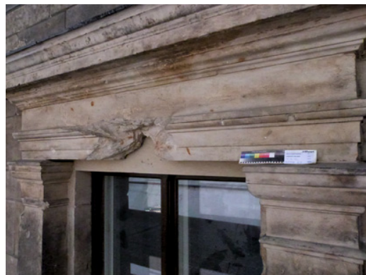
Bild 20 Ertüchtigung der Tragfähigkeit durch Einbringen von Edelstahlarmierung über gesamte Sturzlänge
