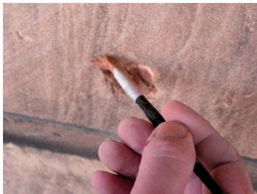
Bild 9 Schusswunde, Einbringen von kieselsolgebundener Schlämme
