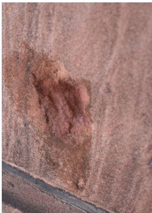
Bild 10 Schusswunde, Abnahme der Schlämme damit die Füllstoffe nur in ausgewitterten Bereichen stehen bleiben
