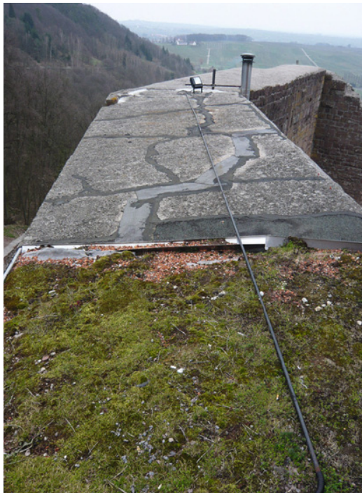
Bild 3 Rissreparatur durch Verfüllung mit Flüssigbitumen
