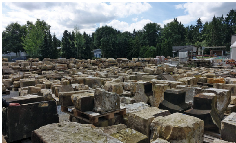
Bild 16 Lagerung des zurückgebauten Natursteinmaterials
