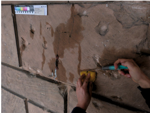
Bild 6 Rissversorgung mit KSE Festigung
