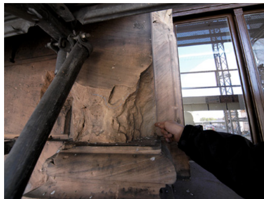
Bild 22 Schusswunde Gewände, Tragfähigkeit durch Restquerschnitt vorhanden
