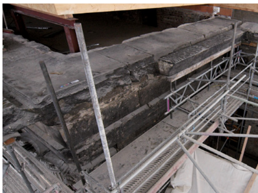
Bild 29 Traufgesimssecke, durch Bom- benschaden zerstört
