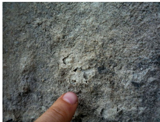
Bild 2 dünne, spannungsreiche Kruste mit aufgeplatzten Pusteln, dahinter entfestigter Sandstein
