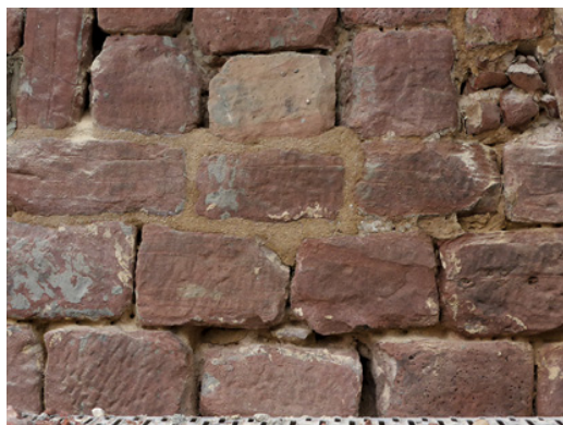
Bild 8 Musterfläche für die farbliche Anpassung des Reparaturmaterials (Bildmitte: neuer Mörtel, rechts oben: historischer Bestand)
