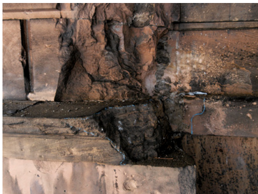
Bild 27 Fehlstelle/Abbruch Gurtgesims
