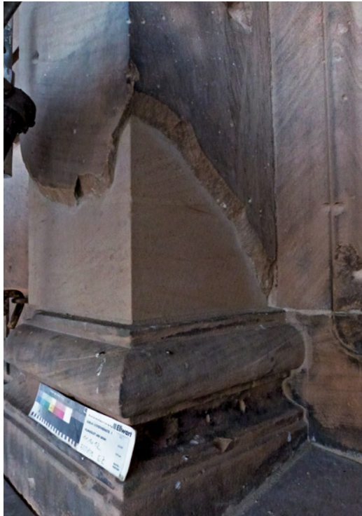
Bild 25 konturverfolgende Vierung, zurückliegend
