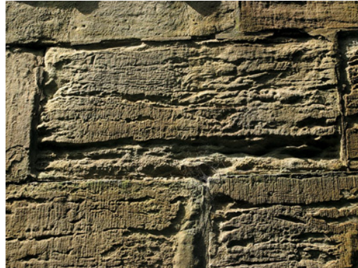
Bild 6 Beispiel für typische Schäden an den Pylonen
