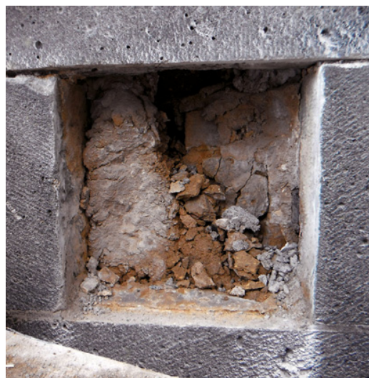
Bild 12 Zerrüttung von Drachenfels-tracht an einem Chormauwerkstück
