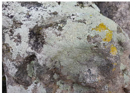
Bild 8a+b Massiver biogener Bewuchs durch unterschiedliche Flechten, Relief „Fuchsjagd“
