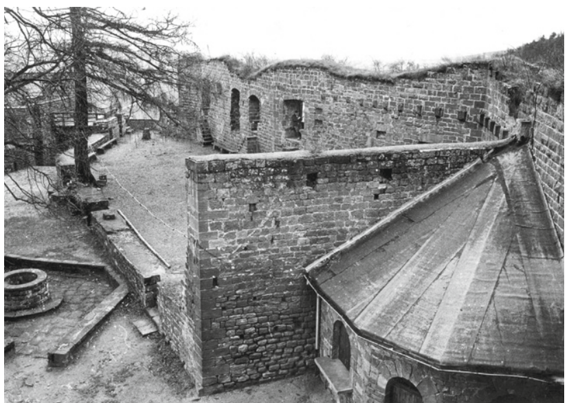
Bild 3 Reste der westlichen Ringmauer mit nachträglich eingefügten Fenstern und Konsolen 1971; bei der polygonalen Erweiterung im Bildfordergrund handelt es sich um einen neueren Zubau der Gastronomie.
