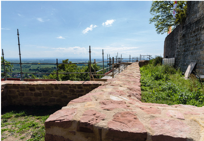
Bild 12 Mörtel mit wasserhemmenden Eigenschaften (schnellere Trocknung als Sandsteine)
