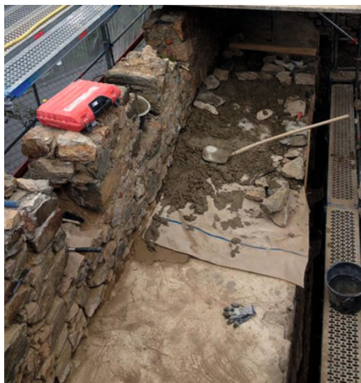
Bild 9 Reduzierung des Wassereintrages durch eine Bentonitmatte auf einer Mauerkrone
