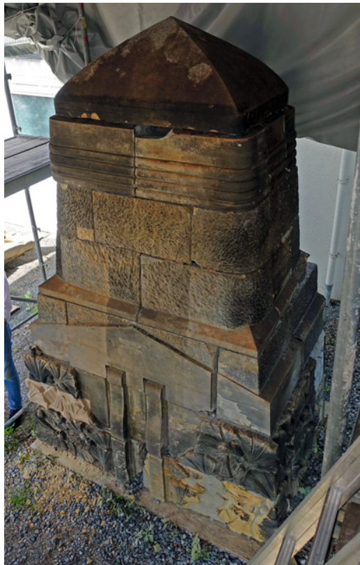
Bild 17a+b provisorischer Wiederaufbau der Pylone (links) und Bemusterung der Reinigung
