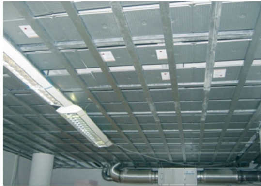
Abb. 69: Metallbehälter mit DELTA-COOL 24 (links) [24]; abgehängte Decke des Besprechungsraums mit PCM-Behältern (rechts)
