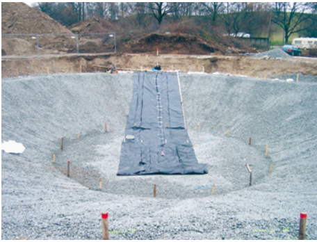
■ Abb. 55: Wärmedämmung aus Glasschaumschotter, Speicherboden aus Ortbeton
