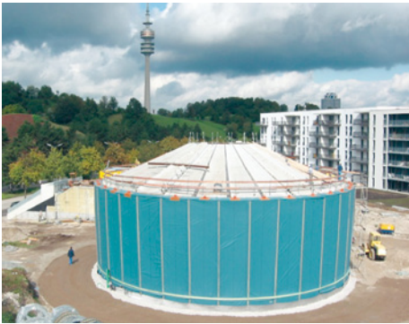
■ Abb. 53: Heißwasserspeicher der Solaren Nahwärmanlage am Ackermannbogen in München [21]
