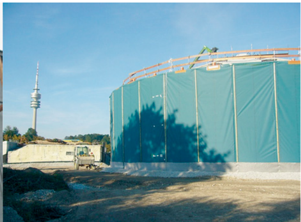
■ Abb. 57: Holzunterkonstruktion (links) und Membranverkleidung (rechts) für Wärmedämmschüttung aus Blähglasgranulat
