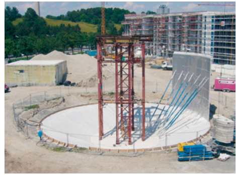
■ Abb. 55: Wärmedämmung aus Glasschaumschotter, Speicherboden aus Ortbeton
