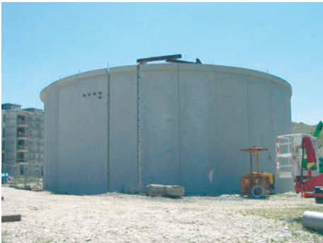
■ Abb. 56: Seitenwände und Dach des Speichers aus Betonfertigteilen
