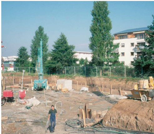
■ Abb. 52: Erdwärmesonden-Speicher solare Nahwärme Neckarsulm
