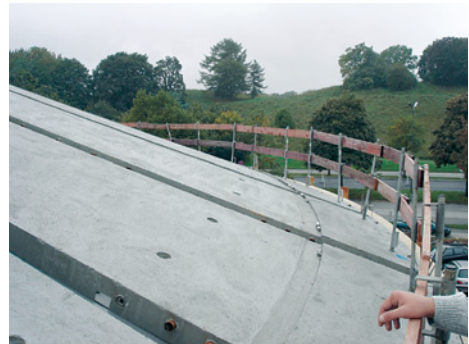
■ Abb. 56: Seitenwände und Dach des Speichers aus Betonfertigteilen
