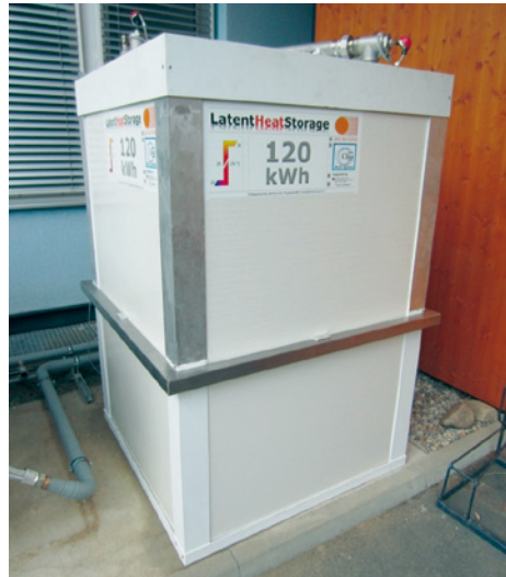
■ Abb. 71: Teilkristallisierter Latentwärmespeicher (links), 120 kWh Speicher im solaren Klimatisierungssystem (rechts)
