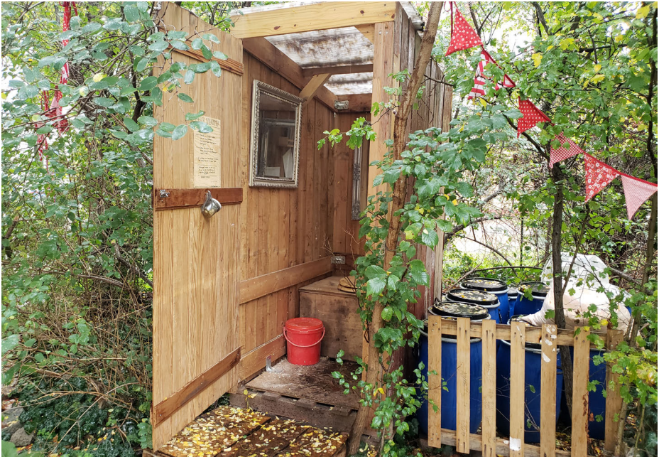
Abbildung 4: Selbstgebaute Komposttoilette auf der Insel Weissensee (eigene Aufnahme)
