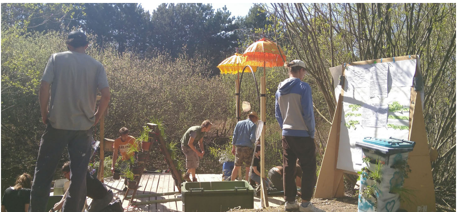
Abbildung 3: Gemeinsames Bauen am Inselgarten, im Vordergrund eine Pinnwand mit angepinnten Plänen (eigene Aufnahme)
