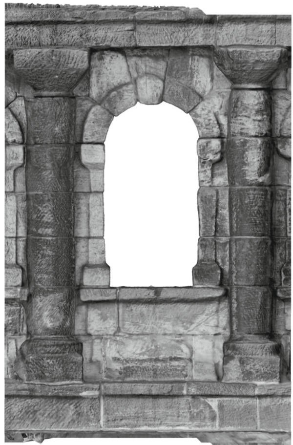
Abb. 6: Tachymeteraufmaß in der Porta Nigra
