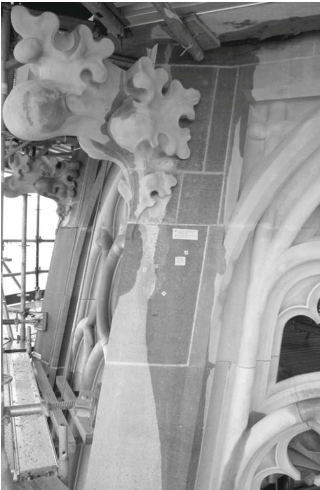
Abb. 3: Nach einem starken Regenfall bleibt der Bereich unter der Krabbe aus Obernkirchener Sandstein zunächst trocken. Genau in diesem Bereich zeigen sich im Zuger Sandstein die stärksten Schäden, meist Schalenbildungen und oberflächliche Verwitterungsbilder.
