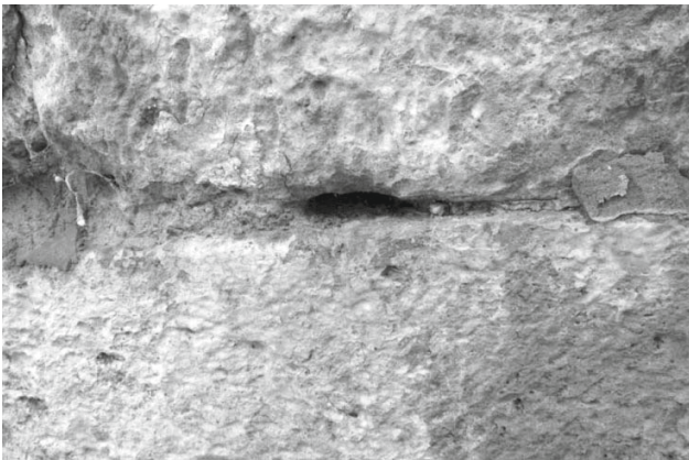
Abb. 15: Schmale Fugen mit hinterschnittiger Aufweitung an der Stirnwand (a)
