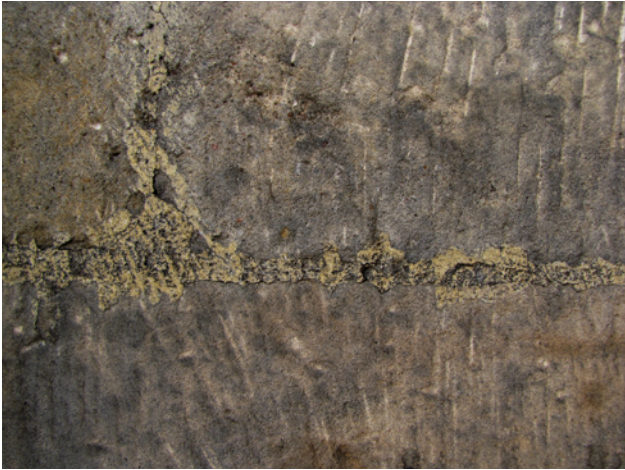
Abb. 35: Scharrier-/Beilspuren, auch über die Fugen des Quadermauerwerks
