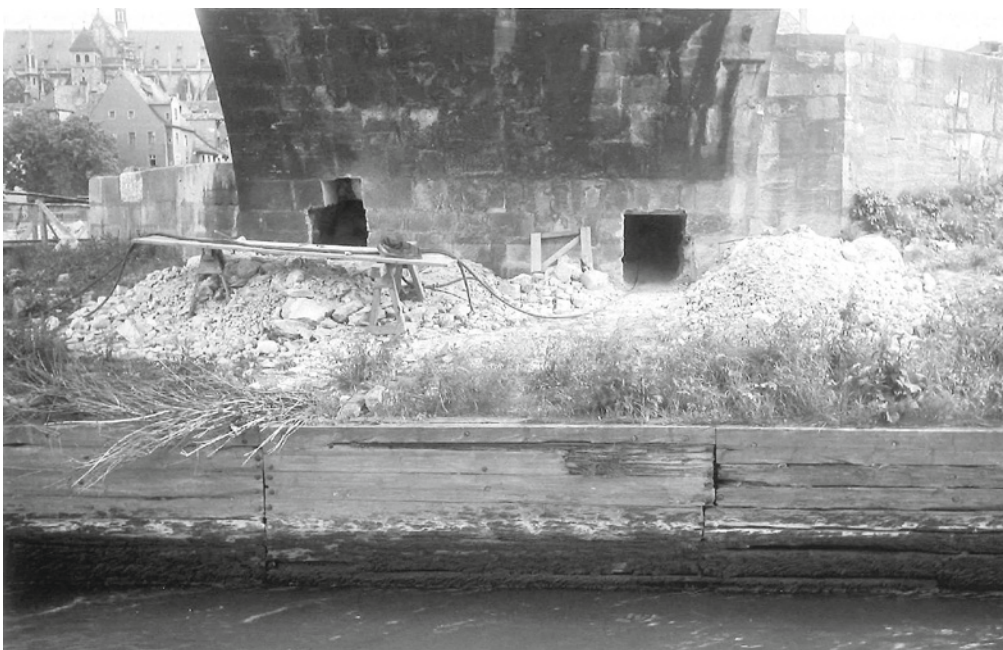
Abb. 9: Sprengkammern: Herstellung 1953 in Nordseite von Pfeiler 4
