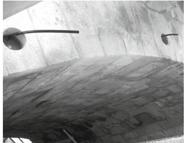
Abb. 16: Ankerköpfe für Quervorspannung von Einbau der Vierungen
