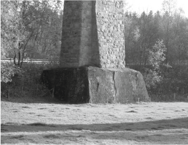
Abb. 17: Stützenfundament aus Stahlbeton
