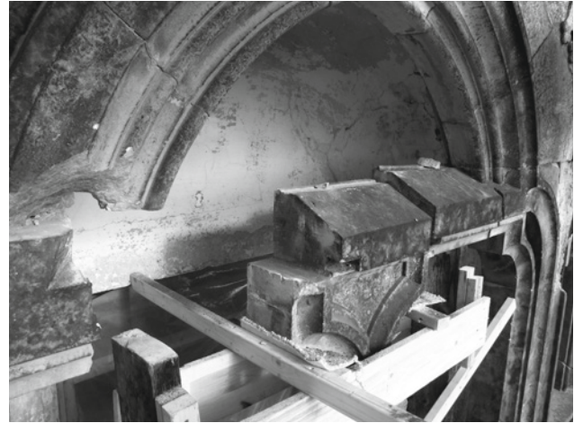
Abb. 11: Sicherung und Demontage des gerissenen Sturzes am Mittelgiebel
