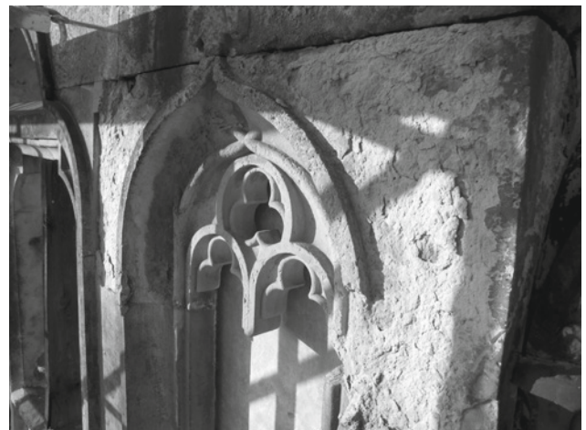
Abb. 9: Hohe Substanzverluste durch Schichtspaltung und Abschuppen
