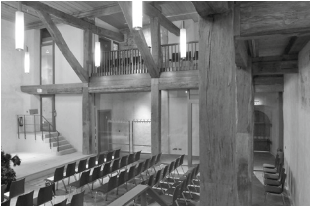
Abb. 19: Erdgeschoss, ehemalige Schlosskirche mit den erhaltenen tragenden Holzbauteilen von 1509f. – heute als Veranstaltungssaal genutzt – nach Abschluss der Restaurierung, Zustand 2011
