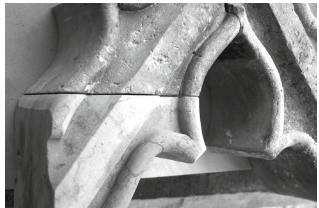
Abb. 21: Einbau von Vierungen an konstruktiven Fehlstellen, Brüstungsplatte
