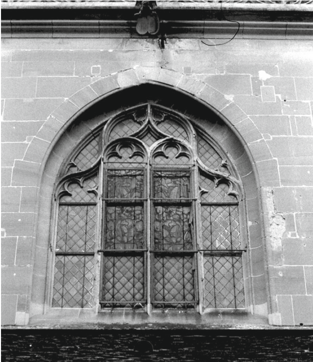
Abb. 18 und 19: Obergadenfenster Nord, Totalersatz durch die Münsterbauhütte 1995
