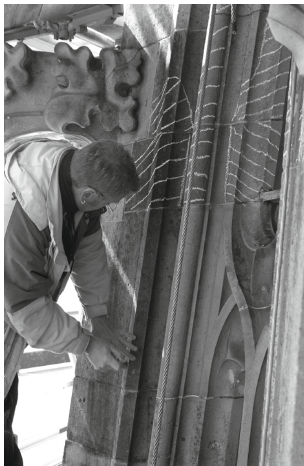
Abb. 7: Detektion von Schalen mit dem Bleiklopfer. Die mit weißer Kreide markierten Bereiche lassen sich bei der Reinigung der Oberfläche mühelos wieder entfernen.
