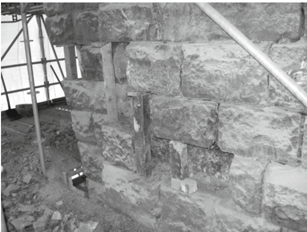
Abb. 10 und 11: Steinaustausch im Pilgerschritt
