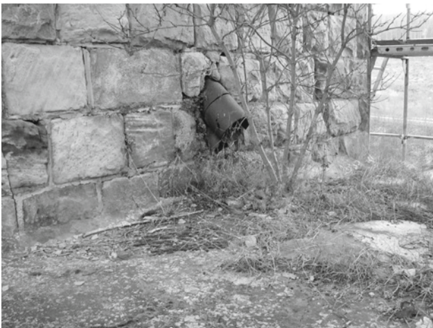
Abb. 3: Schäden durch Spontanvegetation
