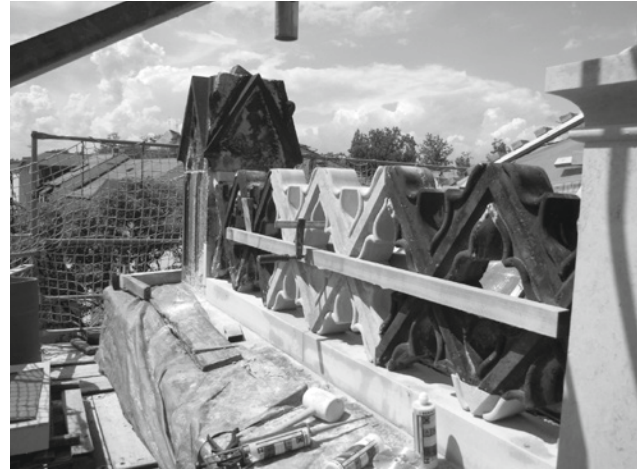
Abb. 32: Wiedermontage der instandgesetzten und Einbau der rekonstruierten Bauteile
