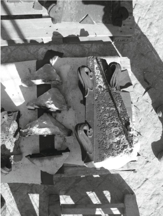
Abb. 14: Geborgene Einzelteile einer zerstörten Fiale
