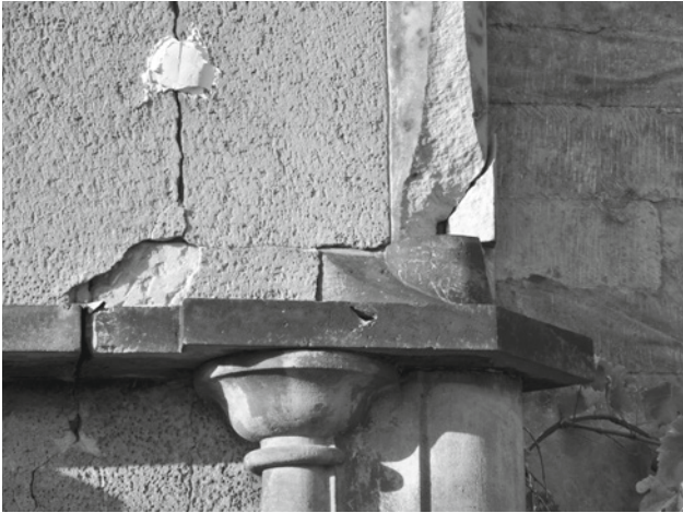
Abb. 4: Risse in der Fassade durch Setzungen des Gebäudes
