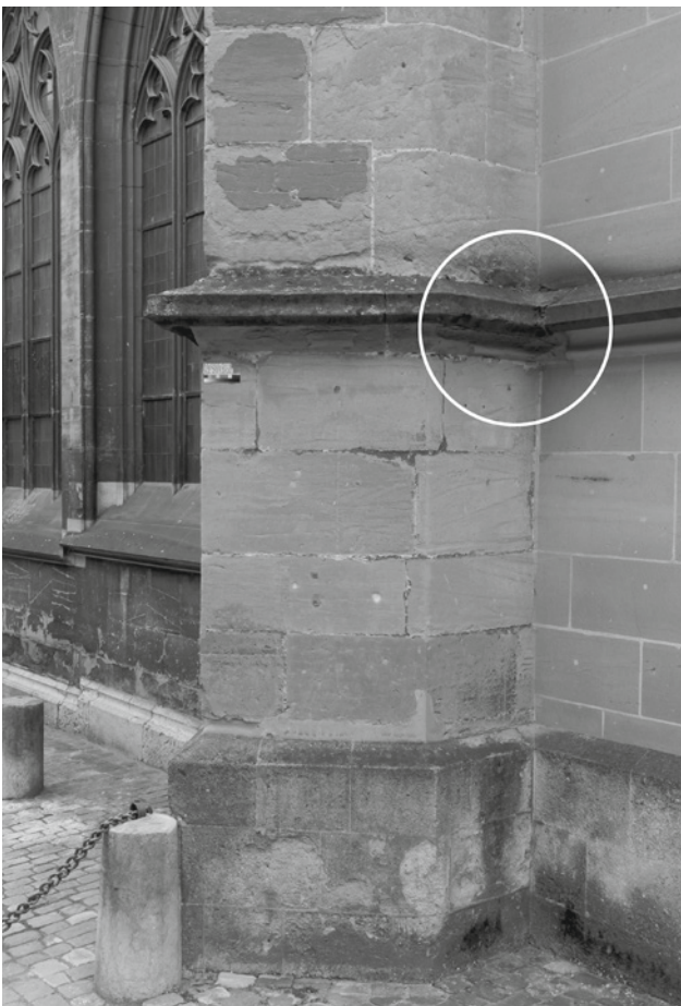
Abb. 20: Rekonstruktion: Beim Erneuern aller Kaffgesimse um 1900 wurde an der nordwestlichen Gebäudeecke ein einziges Originalgesims (15. Jh.?) ausgelassen.
