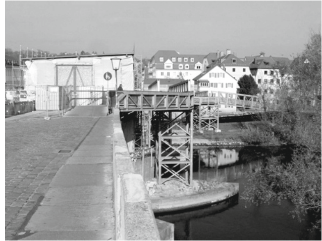
Abb. 11: Behelfsteg und Einhausung im 1. Bauabschnitt
