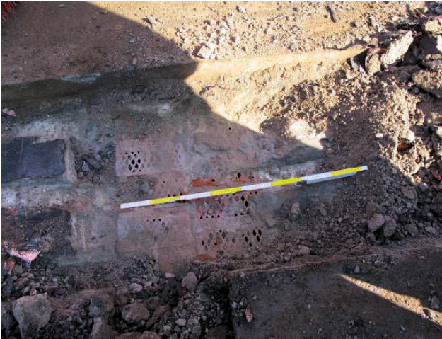
Abb. 8: Ziegelschott, links Reste der metallischen Abdichtung
