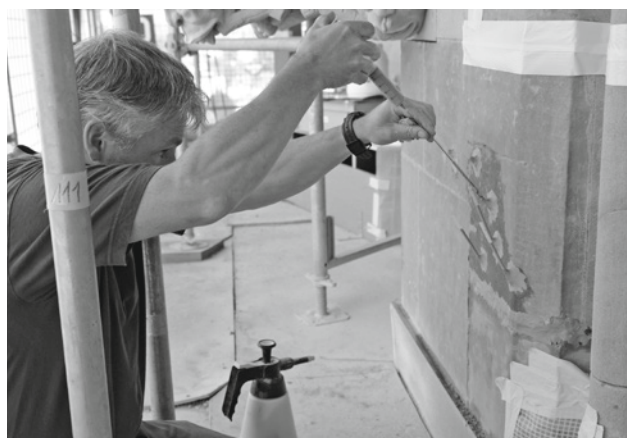
Abb. 12: Inzwischen werden die Injektionen meist über Trinkhalme, befestigt mit Ton, durchgeführt. Eine einfache aber sehr effektive Methode wenn ohne Druck verfüllt wird.
