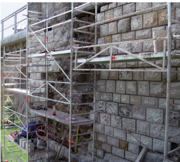
Abb. 14, 15, 16: Widerlager Nordost: Ersatz der Spritzbetonsicherung durch eine neue Vorsatzschale
