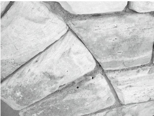
Abb. 12 und 13: In die Vorverfugung eingebaute Injektionsschläuche und endverfugtes Mauerwerk
