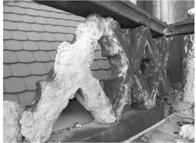
Abb. 5: Kompletter Substanzverlust durch mindere Materialqualität
