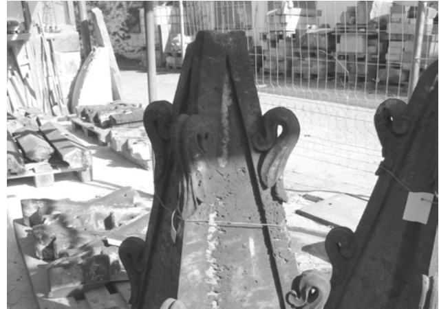
Abb. 15: Einlagerung der demontierten und nummerierten Werksteine auf dem Werkplatz
