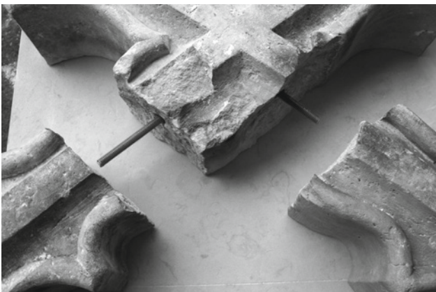
Abb. 20: Vernadeln gebrochener Werksteine, Brüstungsplatte
