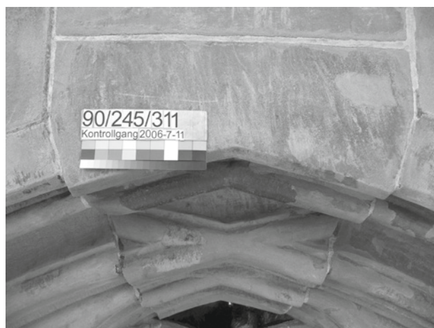
Abb. 15: Detail Schlussstein: Schlusszustand nach der Restaurierung
