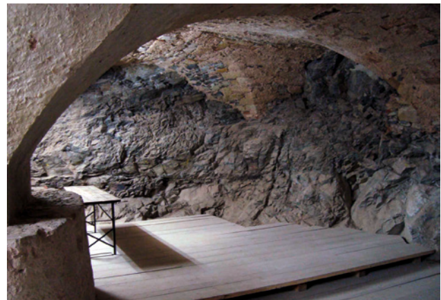
Abb. 15: Anstehender abgearbeiteter Felsen zum Einbau der Gewölbe im zweiten Untergeschoss, Zustand 2009
