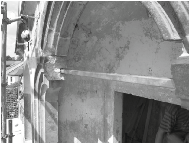
Abb. 27: Einbau eines Zug- und Halteankers für den Sturz des Mittelgiebels
