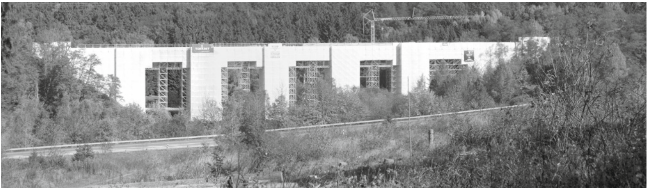
Abb. 2: Einrüstung des Brückenbauwerks
