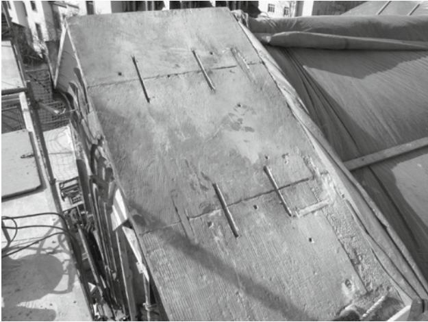
Abb. 10: Sicherung und Verklammerung der Giebelspitze zur Vorbereitung der Demontage der Seitenteile des Giebels
