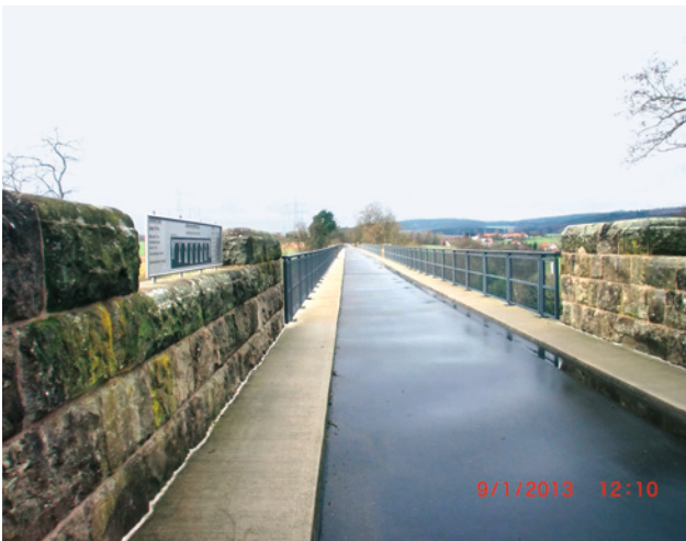
Abb. 5, 6, 7: Abbruch der Gleisanlage und Neuausbildung der Fahrbahn einschließlich Geländer
