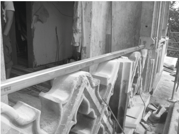
Abb. 29: Einbau eines Halteankers für die Brüstung des Balkons des Mittelgiebels
