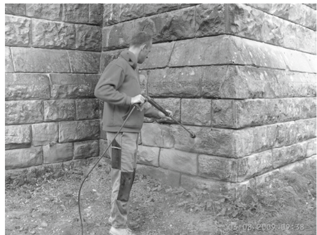
Abb. 4: Schonende Wasserstrahlreinigung
