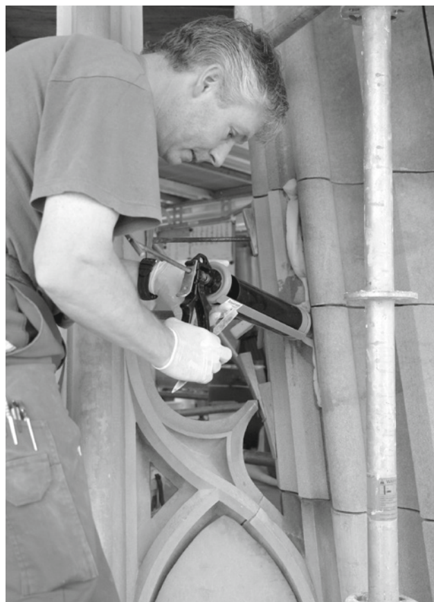
Abb. 17: Einbringen des Verpressmörtels bei den Vierungen am Turmhelm
