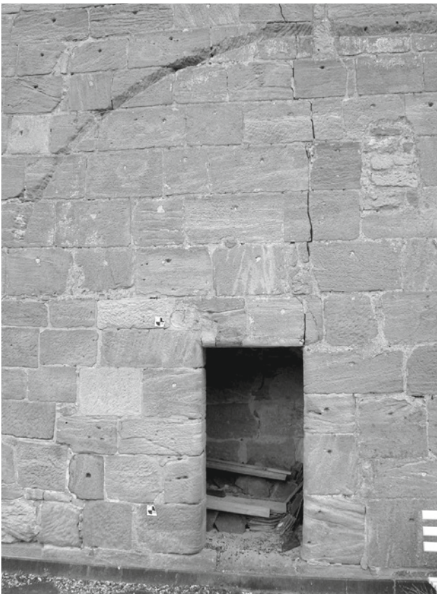
Abb. 20: Detail des Quadermauerwerks am Nordwestgiebel nach der Restaurierung; die Ansätze früherer Gewölbeansätze des Küchenbaus sind ablesbar, Zustand 2011
