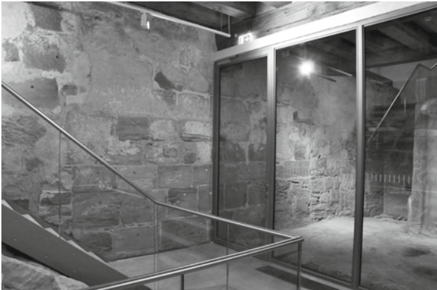
Abb. 17: Erdgeschoss, Zustand des mittelalterlichen Quadermauerwerks im Inneren nach der Restaurierung mit konservierten Putzbefunden, Zustand 2011
