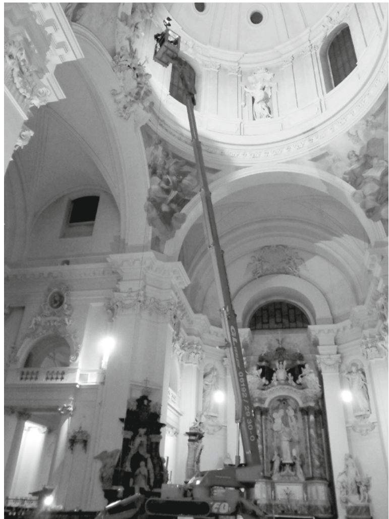
Abb. 3: Einsatz einer Arbeitsbühne für Messbildaufnahmen in der Vierungskuppel
