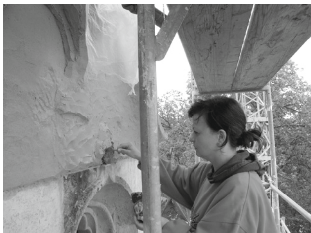
Abb. 24: Antragen des Fertigkompressenmörtels an der Fassade
