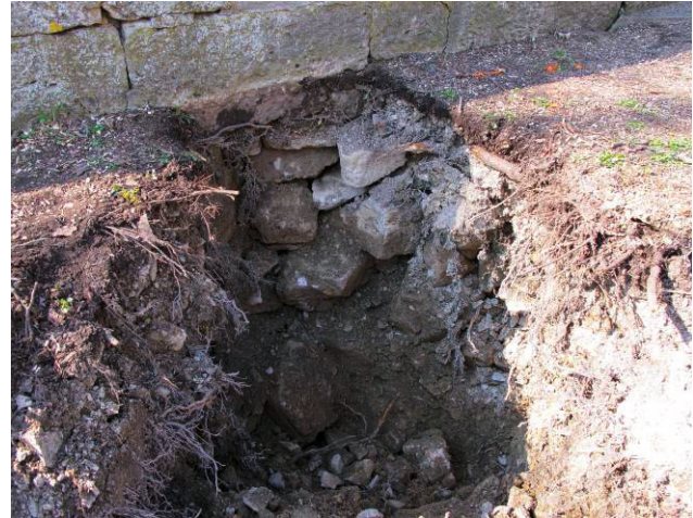
Abb. 10: Schurf hinter der Flügelwand Oberstrom
