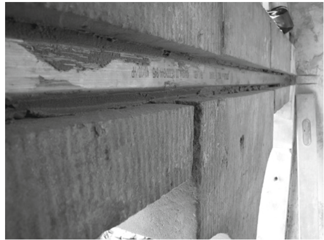
Abb. 28: Anker mit den aufgeschobenen Teilen des Sturzes des Mittelgiebels
