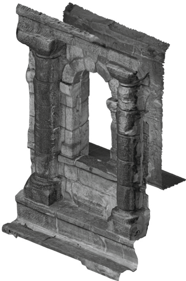
Abb. 7: Texturiertes 3D-Bild und Orthofoto eines Fensterdetails
