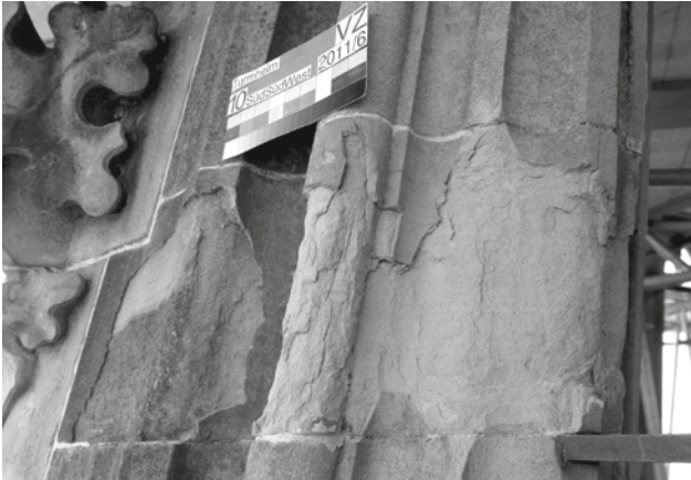
Abb. 2: Stark geschädigte Turmhelmsstrebe aus Zuger Sandstein aus der Zeit der Turmaufstockung um 1890.
