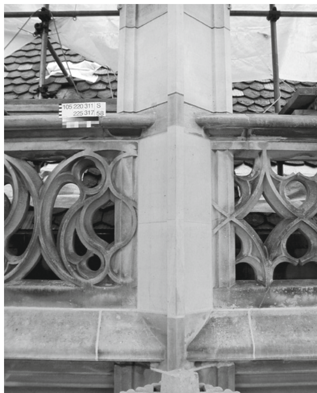
Abb. 17: Ersatz der Werkstücke aus Zuger Sandstein mit Obernkirchener Sandstein. So kann eine bessere Stabilität des Bauteils gewährleistet werden.
