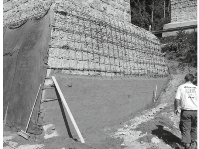
Abb. 18: Stützenfußverstärkung mit Spritzbeton
