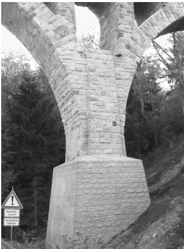
Abb. 21, 22, 23: Pfeiler vor und kurz nach der Instandsetzung mit TORKRET Relief® und nach Bewitterung
