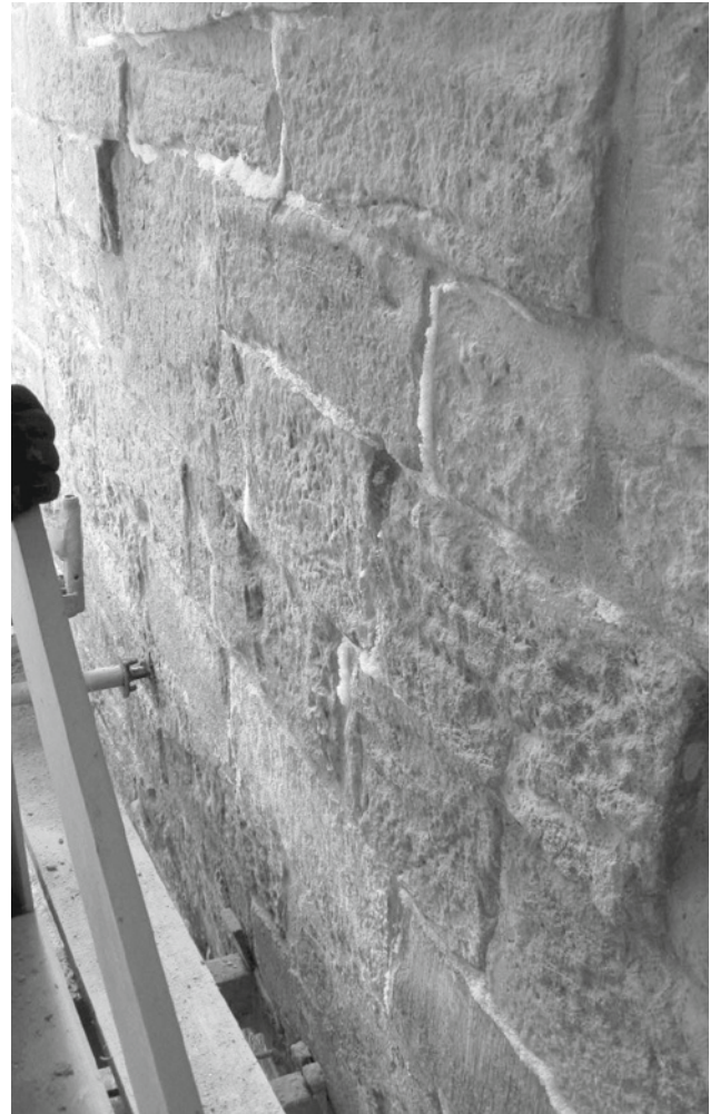
Abb. 14: Salzbärte auf intaktem Fugmörtel
