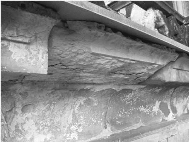
Abb. 6: Substanzverluste in Folge der defekten Entwässerung
