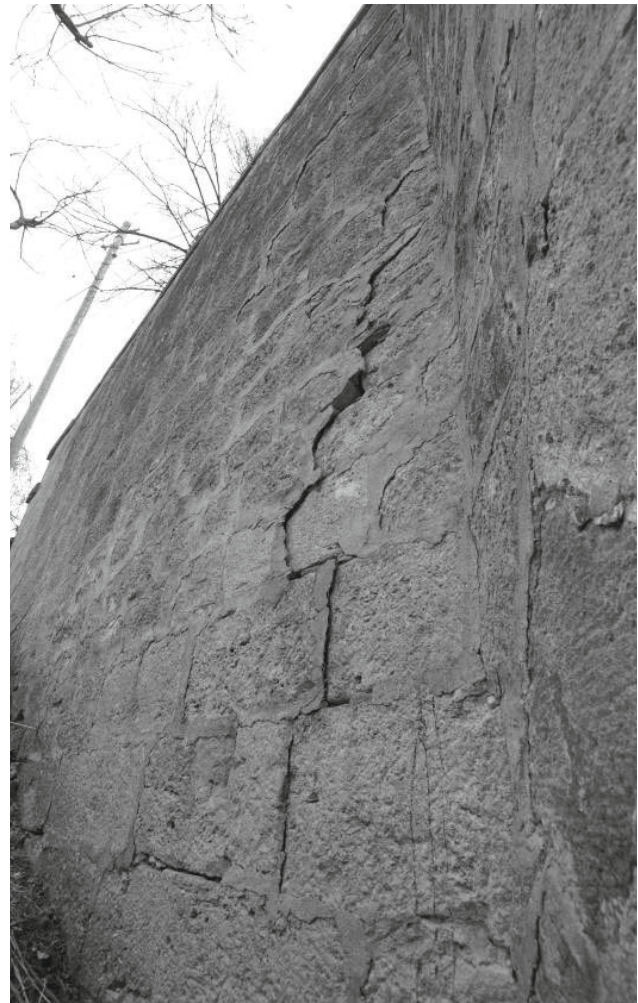
Abb. 1: Verformung rechte (östliche) Flügelwand, Unterstrom
