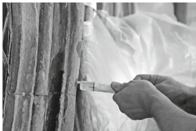
Abb. 10: Sehr wichtig ist die Reinigung des Bohrloches vor der Injektion.
