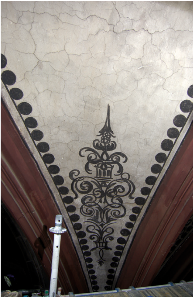
Abb. 25: Gewölbekappe Chor: Zustand vor Anlegen des Reinigungsmusters (Foto: Cornelia Marinowitz)
