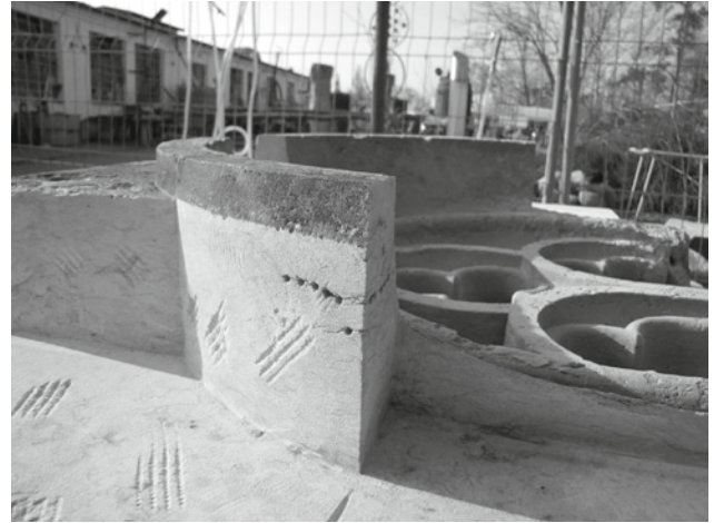
Abb. 17: Verkleben von Rissen, Vorhangbogen
