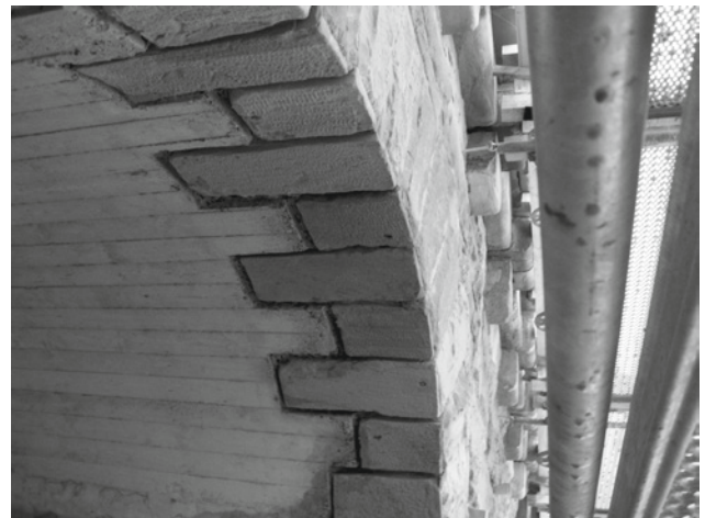
Abb. 12 und 13: In die Vorverfugung eingebaute Injektionsschläuche und endverfugtes Mauerwerk
