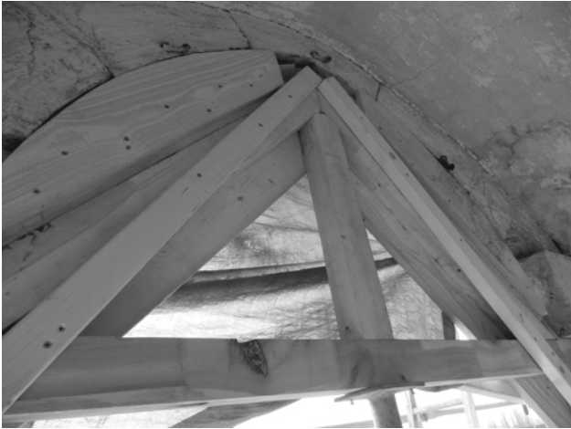
Abb. 12: Aussteifung des Bogens zur Vorbereitung der Demontage der Seitenteile des Giebels
