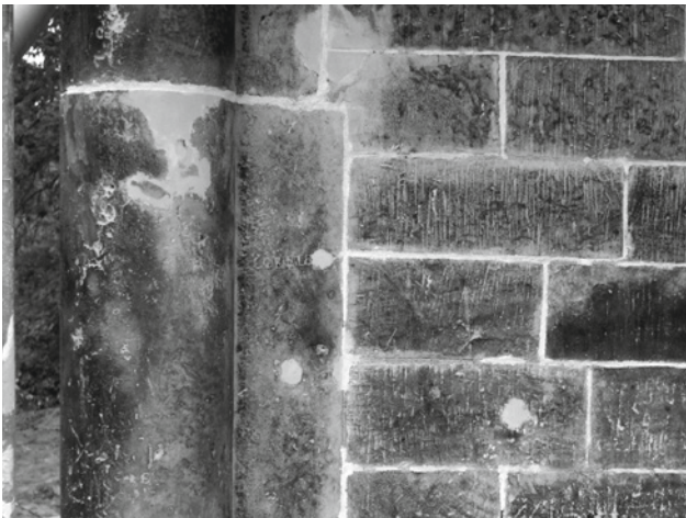
Abb. 33: Ergänzung Fehlstellen von Pilaster und Quadermauerwerk mit Antragungen
