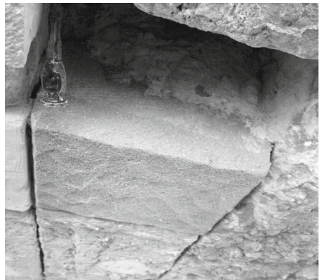
Abb. 15: Schutzantrag (Oberfläche noch unbearbeitet)
