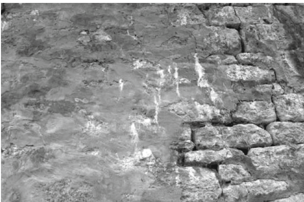
Abb. 17: Tief ausgewitterte, breite Fugen an der Gewölbeuntersicht (c)
