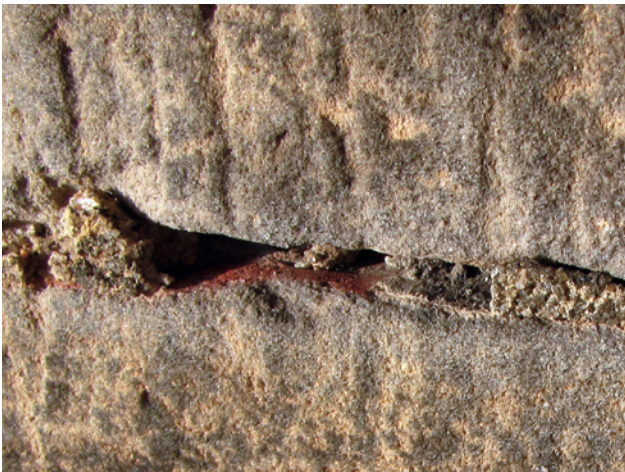
Abb. 37: Reste roter Farbpigmente in der Fuge
