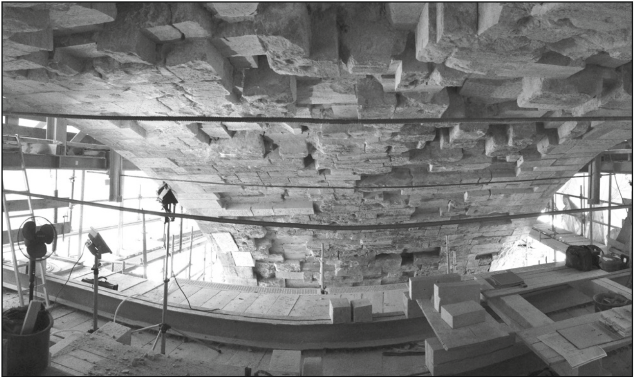
Abb. 17: Bauzustand Bogen XII: Rohzustand, vorbereitete Steinoberflächen, Aufbauquader, Tiefenverzahnungen)
