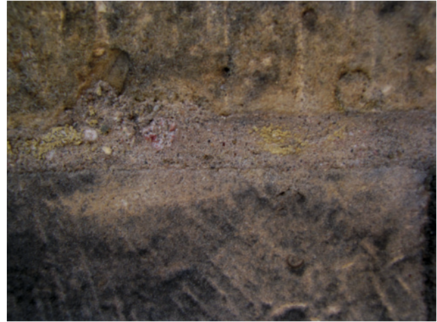
Abb. 36: Befund von gelblicher und roter Fassung auf den Fugen
