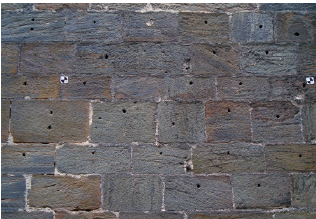
Abb. 14: Zustand des mittelalterlichen Quadermauerwerks an der Nordostfassade vor der Restaurierung, Zustand 2009
