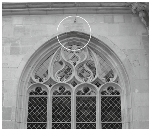
Abb. 13: Zeitzeugnis: Der sichtlich bereits früh verrutschte Schlussstein beim Fenster 90 am nördlichen Seitenschiff wurde nicht gerichtet, sondern in situ restauriert (Münsterbauhütte 2004)
