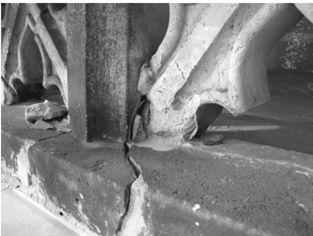
Abb. 8: Risse durch Korrosionssprengung
