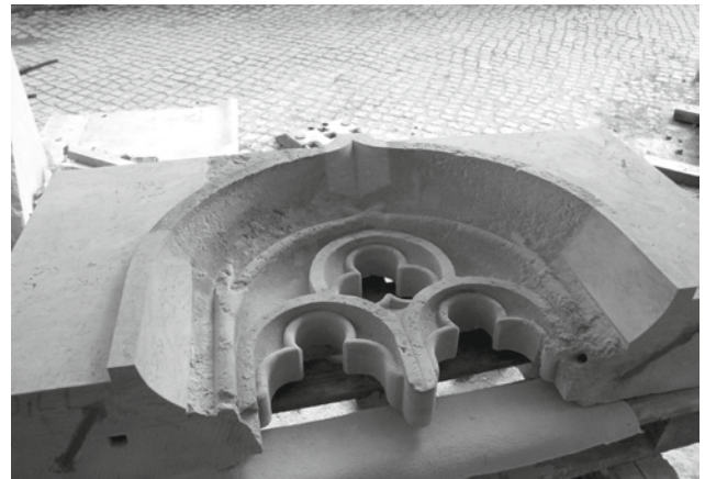
Abb. 19: Gesicherter und mit Vierungen ergänzter Vorhangbogen
