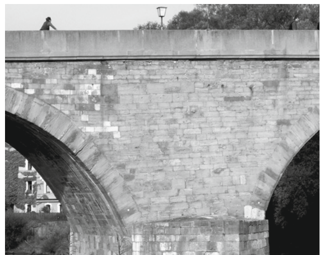
Abb. 5: Längsrisse im Bereich der Pfeilermitte infolge Bogensenkungen
