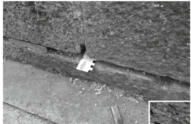
Abb. 16: Breitere Fugen mit ca. 1,5–2,5 cm Breite an der Innenseite der Brüstung (b)
