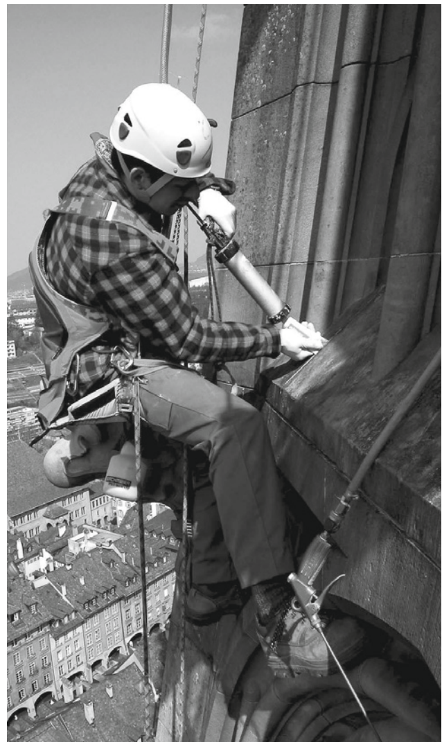
Abb.12: Provisorisches Schließen offener Fugen mit einem Fugenmörtel auf der Basis von reinem Edelmalk (2003)
