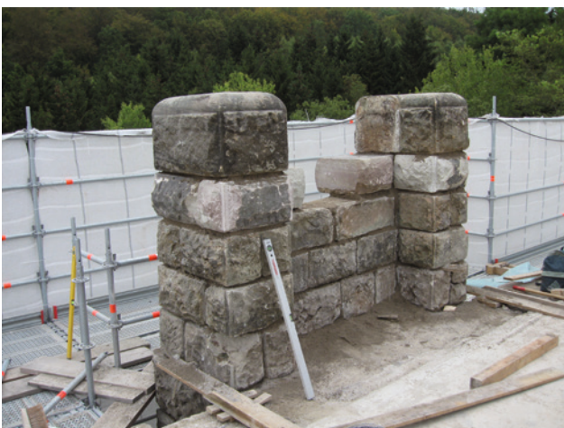
Abb. 8 und 9: Wiederaufmauerung der Postamente mit zusätzlicher Steinlage
