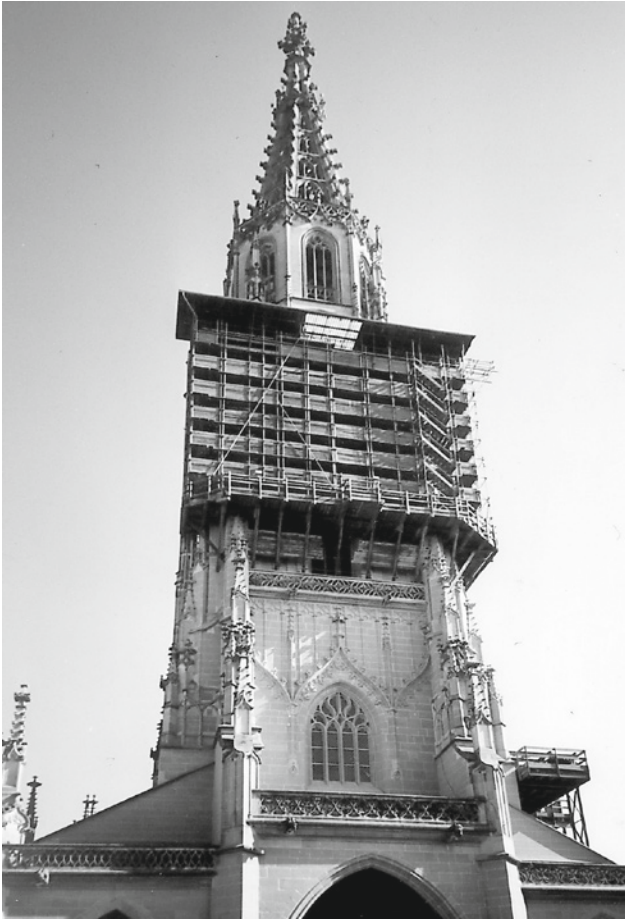
Abb. 5: Letzte umfangreiche Renovationsstufe: Oberes Turmviereck West, Steinaustausch 100%. Standzeit des Gerüsts an diesem Fassadenabschnitt: 1982–2002
