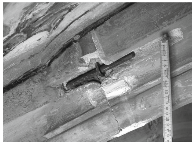
Abb. 4: Freilegung der rostenden Dübel und Ersatz derselben durch Dübel aus Edelstahl wo sinnvoll und notwendig
