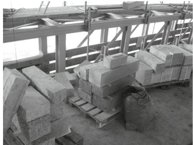
Abb. 13: Aus den Rohblöcken geschnittene Grünsandsteinquader vor dem Einbau
