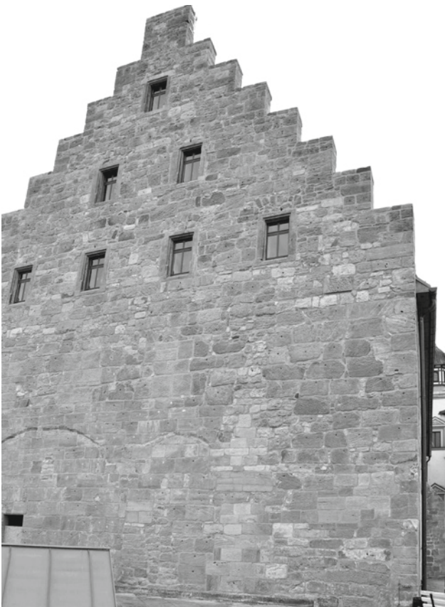
Abb. 18: Zustand des Quadermauerwerks am Nordwestgiebel nach der Restaurierung; Im unteren Bereich ist der mittelalterliche Bestand erhalten, der Treppengiebel wurde 1832 ff. erneuert, Zustand 2011
