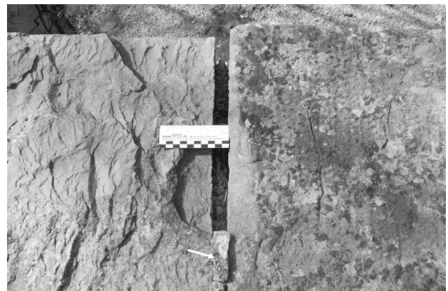
Abb. 18: Horizontale Fugen mit Steinzerstörung zwischen den Abdeckplatten (d)
