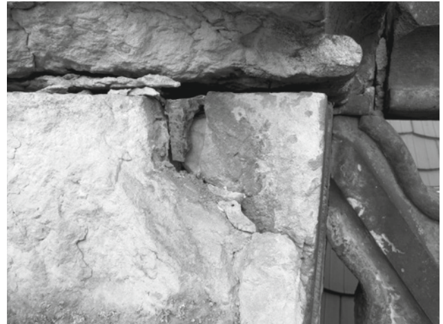
Abb. 7: Materialverlust, eingeleitet durch Korrosionssprengung
