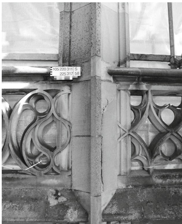
Abb. 16 „Baumangel“: Die Schaftstücke der Brüstungsmaße über dem Chor (Zuger Sandstein) wiesen im Verbund mit den umgebenden Brüstungsmaßwerken aus Obernkirchener Sandstein starke Risse auf.
