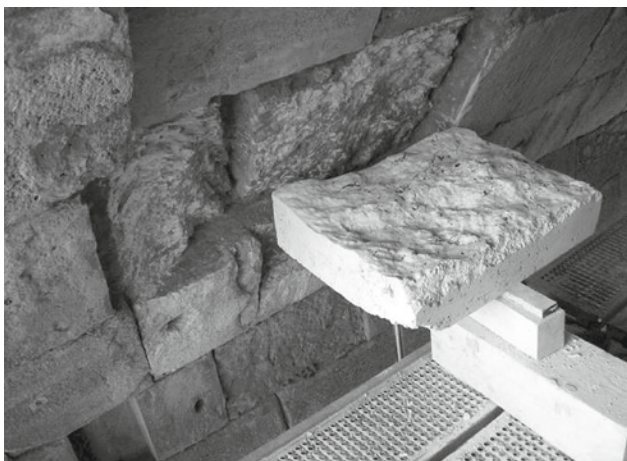
Abb. 18: Krone aus Kalkstein vor Einbau (aus Block mittel 3D-Scan gefräst)
