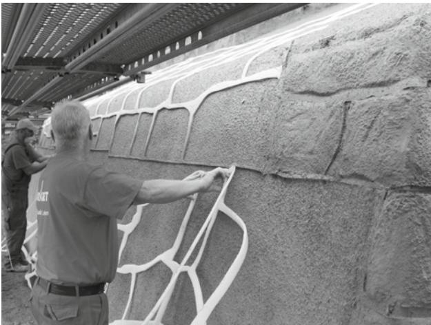
Abb. 19: Reliefmatrize wird hilfsweise eingelegt
