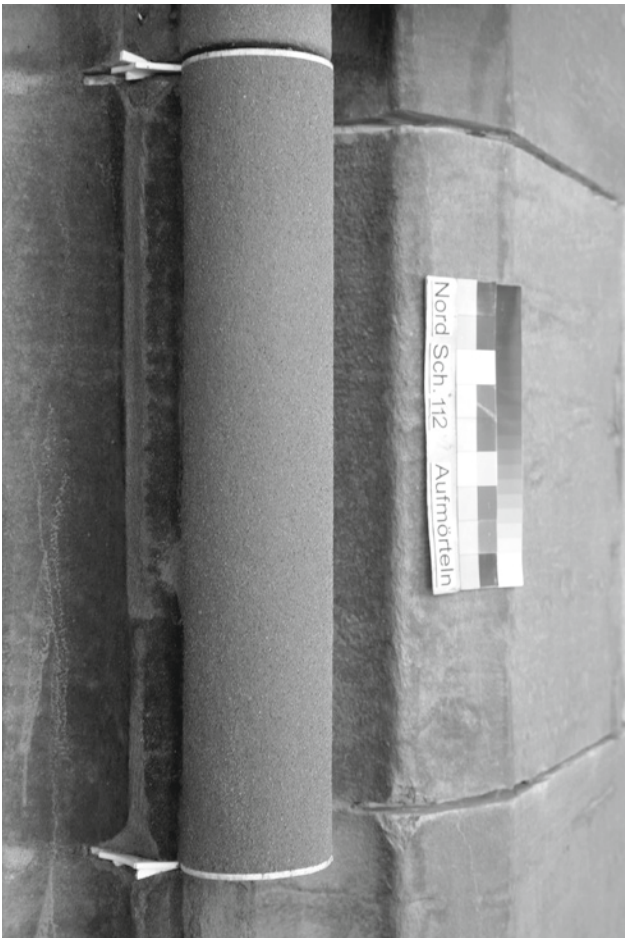
Abb. 15: Fertige Mörteloberfläche, abgetupft mit dem Mikroporenschwamm
