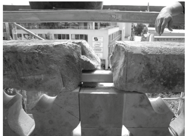
Abb. 30: Montage der Abdeckung der Brüstung des Balkons auf den Halteanker
