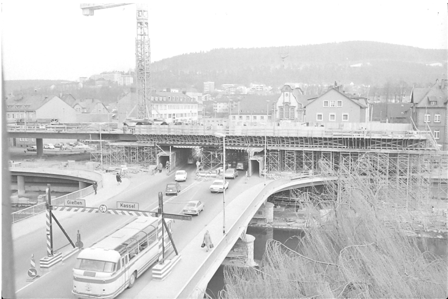
Abb. 2: Autobahnhochbrücke vor dem Bahnhof im Bau
