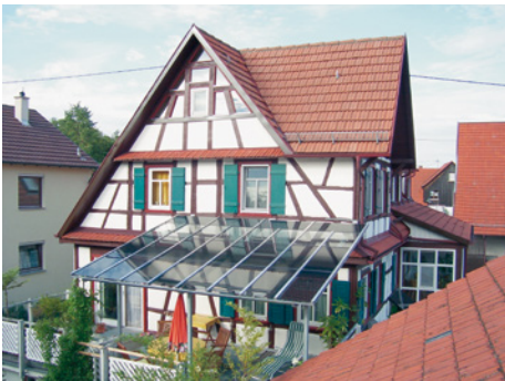
■ Abb. 86: Links: Terrassenüberdachung mit semitransparenten CIS-Modulen, rechts: Bahnsteigüberdachung mit Doppelglas-Modulen am Hauptbahnhof in Berlin
