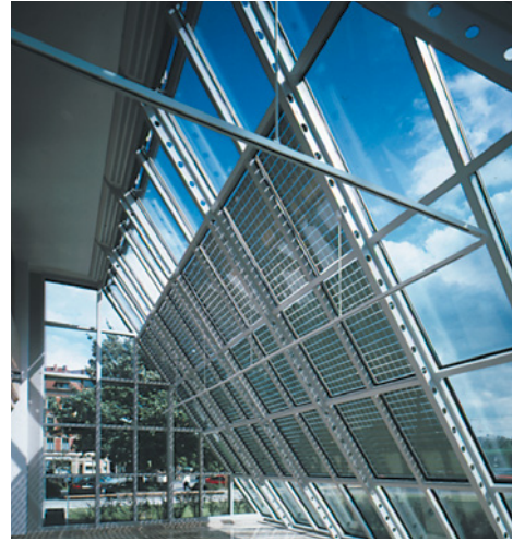
■ Abb. 79: Links: Warmfassade mit semitransparenten PV-Modulen am Produktionsgebäude der Firma SMA in Niestetal, rechts: Geneigte Warmfassade mit semitransparenten Modulen am Hastra-Gebäude in Hannover
