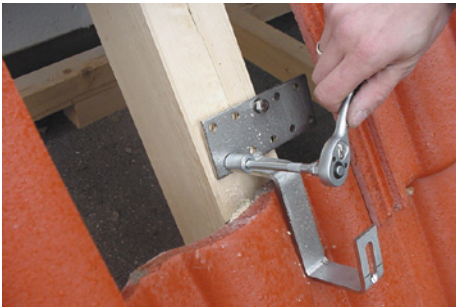
■ Abb. 63: Je nach Dachstein sind Aussparungen an den Pfannen notwendig, damit diese nach der Dachhakenmontage wieder plan aufliegen ohne Belastung durch den Dachhaken. Das gelingt am besten mit einem Winkelschleifer (Flex).
