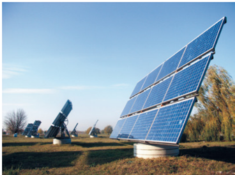
■ Abb. 87: Freiflächen-Anlagen: Links: Zweiachsig nachgeführte PV-Anlagen »Solon Mover«, rechts: Fünf Megawatt Freiflächenanlagen Leipziger Land, aufgeständert auf Holzfachwerkkonstruktion.
