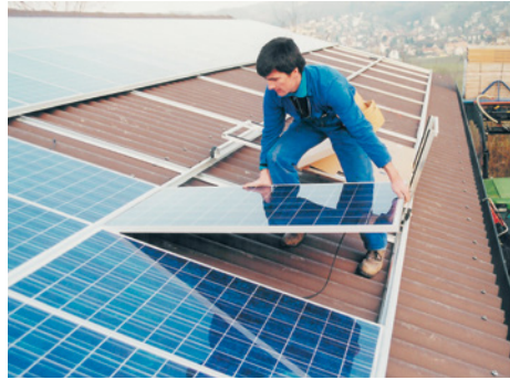
■ Abb. 68: Links: Linienförmige Befestigung mit Klemmleiste, rechts: Modulmontage am Einlegesystem
