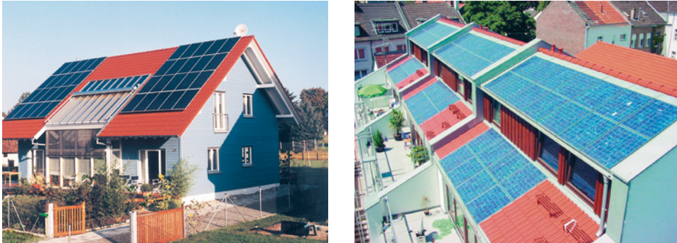
Abb. 2: Photovoltaik-Anlagen mit Auf-Dach-Montage (links), komplettes In-Dach-Montage-System (rechts)
