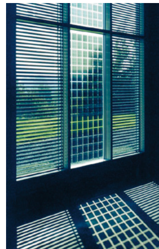
■ Abb. 23: Semitransparente Module mit kristallinen Solarzellen sowie Lamellen aus amorphen Solarzellen in Isolierglas
