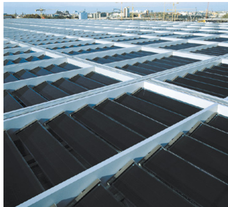
■ Abb. 85: Links: Klinisch-molekularbiologisches Forschungszentrum der Uni Erlangen mit Solarmarkisen und nachgeführten Photovoltaik-Solarlamellen, rechts: amorphe Dünnschichtmodule als Sonnenschutz-Lamellen auf dem Paul-Löbe-Haus in Berlin
