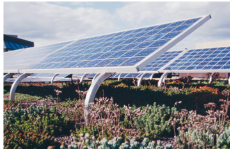
■ Abb. 73: Links: Wannensystem ConSole aus Kunststoff, rechts: Module auf dem Wannensystem Solgreen für Gründächer
