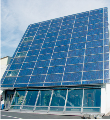
■ Abb. 79: Links: Warmfassade mit semitransparenten PV-Modulen am Produktionsgebäude der Firma SMA in Niestetal, rechts: Geneigte Warmfassade mit semitransparenten Modulen am Hastra-Gebäude in Hannover
