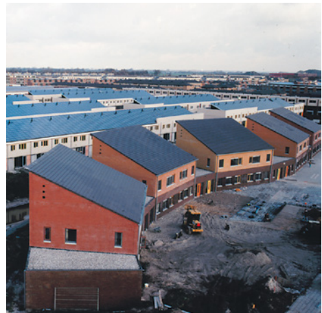
■ Abb. 21: Braas-Solardachziegel mit dunkler Tedlarfolie auf der Megawatt-Siedlung in Nieuwland bei Amersfoort (Niederlande)
