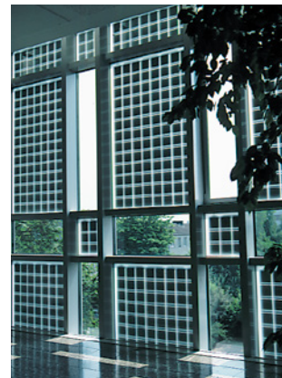
■ Abb. 81: Transparente Warmfassade mit Isolierglasmodulen und Presshalteleisten am Gebäude der STAWAG, Aachen. Außen- und Innenansicht
