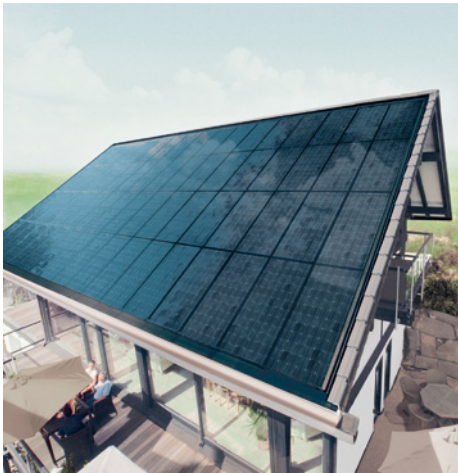
■ Abb. 70: Links: In-Dach-System als Energiedachlösung, rechts: In-Dach-Konstruktion mit semitransparenten Sondermodulen an der Bayerischen Landesbank
