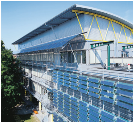
■ Abb. 85: Links: Klinisch-molekularbiologisches Forschungszentrum der Uni Erlangen mit Solarmarkisen und nachgeführten Photovoltaik-Solarlamellen, rechts: amorphe Dünnschichtmodule als Sonnenschutz-Lamellen auf dem Paul-Löbe-Haus in Berlin
