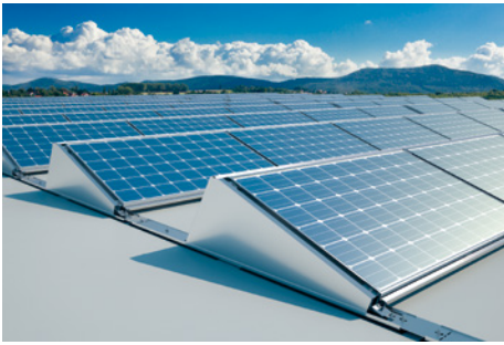
■ Abb. 75: Aerodynamisch optimierte Aufständerungen
