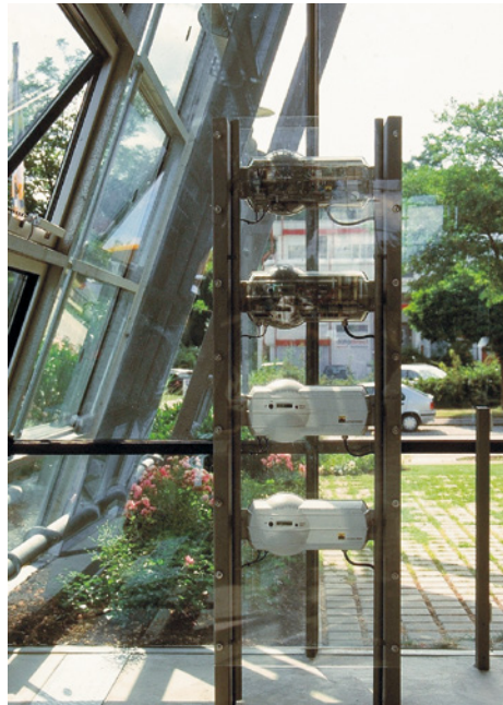
■ Abb. 51: Die Wechselrichter im Gebäude der Solarfabrik Freiburg wirken wie Designobjekte.
