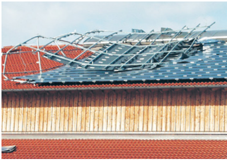
■ Abb. 112: Links: Sturmschäden an nicht ausreichend befestigtem Solargenerator, rechts: Schneedruckschaden und PV-Anlage
