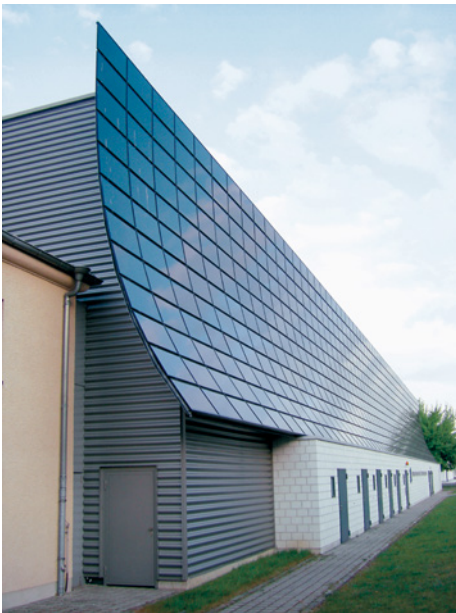
■ Abb. 80: Kaltfassade mit gerahmten CIS-Standardmodulen am Ferdinand-Braun-Institut für Höchstfrequenztechnik in Berlin
