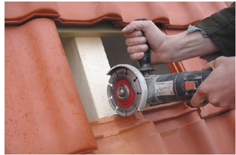
■ Abb. 63: Je nach Dachstein sind Aussparungen an den Pfannen notwendig, damit diese nach der Dachhakenmontage wieder plan aufliegen ohne Belastung durch den Dachhaken. Das gelingt am besten mit einem Winkelschleifer (Flex).
