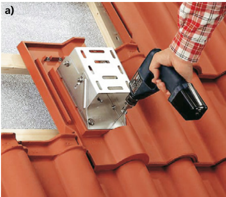
■ Abb. 63: Je nach Dachstein sind Aussparungen an den Pfannen notwendig, damit diese nach der Dachhakenmontage wieder plan aufliegen ohne Belastung durch den Dachhaken. Das gelingt am besten mit einem Winkelschleifer (Flex).
