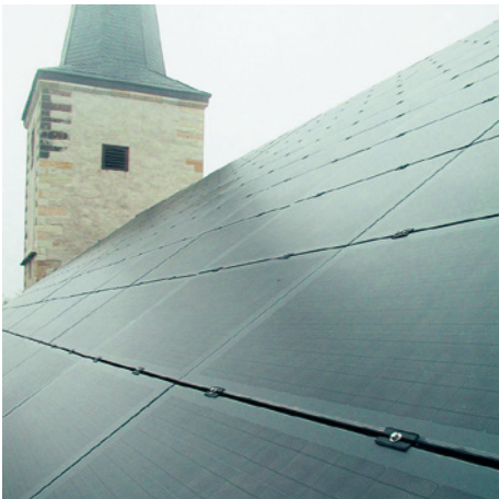
■ Abb. 20: Angepasstes Design von Glas-Folien-Modulen auf der denkmalgeschützten Kirche von Rietnordhausen (Thüringen). Dunkelgraue Rückseitenfolien, rahmenlose Module und gefärbte Frontkontakte bewirken einen sehr homogenen Flächeneindruck und passen zur Schieferendeckung des übrigen Kirchendachs
