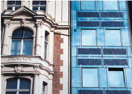
■ Abb. 84: Doppelglas-Module an der Kaltfassade des Bürohauses Ökotec 3 in Berlin, rechts: Punkthalter für Doppelglas-Module
