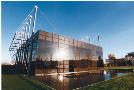
■ Abb. 82: SSG-Fassade am Gebäude des Schreibgeräteherstellers Lamy in Heidelberg
