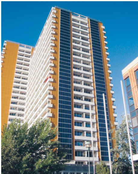
■ Abb. 83: Links: Kaltfassade mit Doppelmodulen am Wohnhochhaus Helene-Weigel-Platz in Berlin; rechts: Fassadenschnitt
