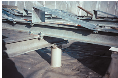
■ Abb. 74: Verankerung am Dach der Landesbank Berlin. Links: Blick auf das Dach, rechts: Modulunterkonstruktion
