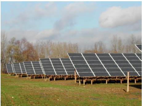
■ Abb. 87: Freiflächen-Anlagen: Links: Zweiachsig nachgeführte PV-Anlagen »Solon Mover«, rechts: Fünf Megawatt Freiflächenanlagen Leipziger Land, aufgeständert auf Holzfachwerkkonstruktion.
