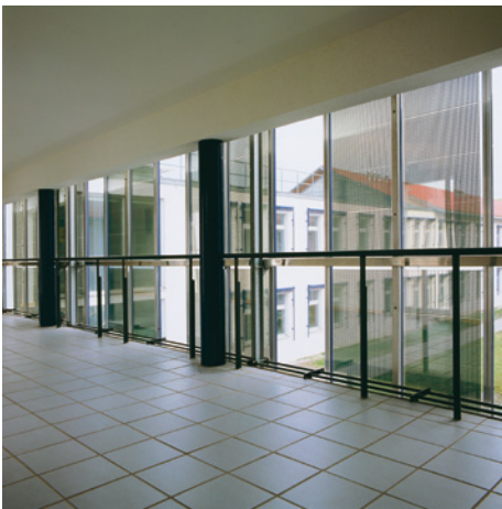
■ Abb. 12: Semitransparente amorphe Dünnschichtmodule an der Fachhochschule Trier, Umweltcampus Birkenfeld
