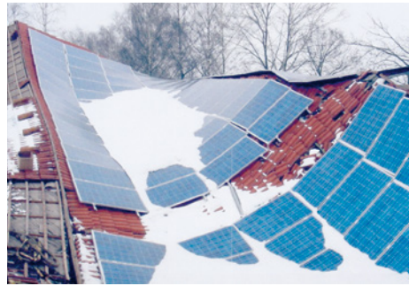
■ Abb. 112: Links: Sturmschäden an nicht ausreichend befestigtem Solargenerator, rechts: Schneedruckschaden und PV-Anlage
