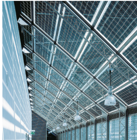
■ Abb. 70: Links: In-Dach-System als Energiedachlösung, rechts: In-Dach-Konstruktion mit semitransparenten Sondermodulen an der Bayerischen Landesbank
