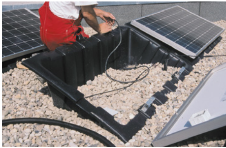
■ Abb. 73: Links: Wannensystem ConSole aus Kunststoff, rechts: Module auf dem Wannensystem Solgreen für Gründächer
