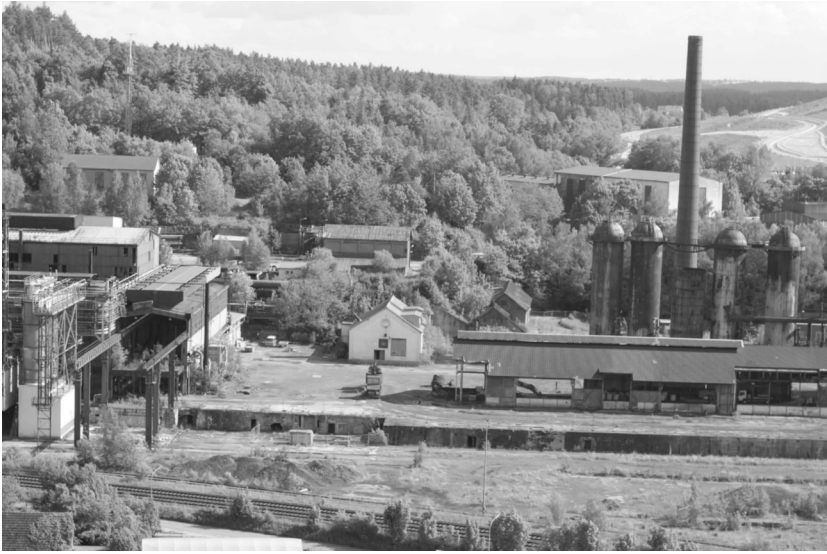
Abbildung 1: Blick auf die Maxhütte
