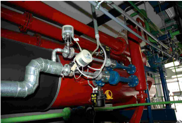
■ Abb. 116: Zweistufige Dampfstrahlkältemaschine (12/9/6°C) mit ca. 550 kW Kälteleistung in der zentralen Kälteerzeugung der Energieversorgung Gera, liegende Bauart (vgl. mit Abb. 32), Hilfs-Dampfstrahlverdichter im Vordergrund, Dampfstrahlverdichter oben (insgesamt sechs Verdichter), Verdampfer (links) und Mischkondensator (rechts) im Hintergrund
