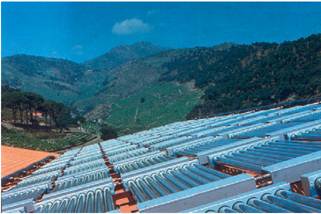
■ Abb. 101: Kollektorfeld der solar-autonomen Kühlung eines Weinlagegebäudes in Banyuls, Südfrankreich.
