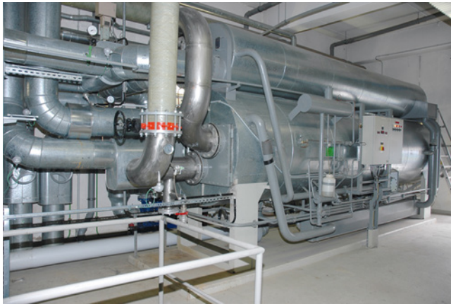
■ Abb. 19: LiBr-H 2 O-Absorptionskältemaschine der Fa. Carrier, 1 800 kW Kälteleistung, Betrieb mit Fernwärme, maximale Vorlauftemperatur des Heizmediums 120 °C
