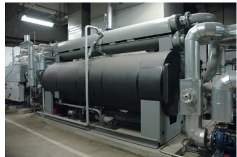
■ Abb. 137: Blick auf das neue Bettenhaus im Klinikum Chemnitz (links), LiBr-H 2 O-Absorptionskältemaschine, Fernwärmenutzung (rechts, alte Zentrale)
