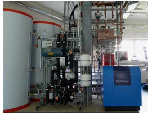
Abb. 108: 13 m 2 Viessmann Vakuumröhren Kollektorfeld mit südlicher Ausrichtung (links), Installation mit Speichersystem, Hydraulikgruppe und Adsorptionskältemaschine (rechts).
