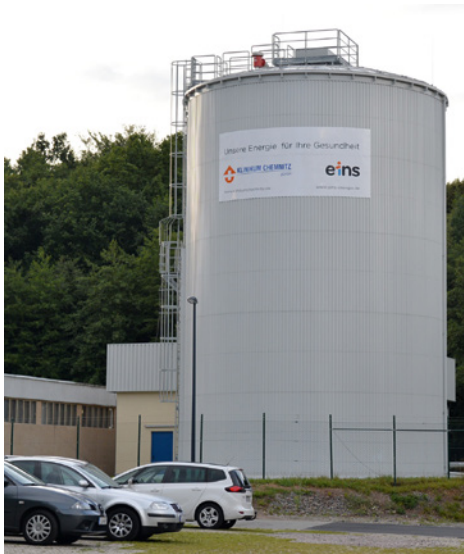
■ Abb.138: Kältezentrale Klinikum Chemnitz (im Hintergrund) mit 1000 m 3 Kaltwasserspeicher im Vordergrund
