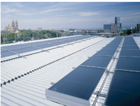
■ Abb. 102: a) Kollektorfeld der IHK-Anlage auf dem Gebäudedach, b) Innenansicht des kleinen Raumes (Cafeteria)
