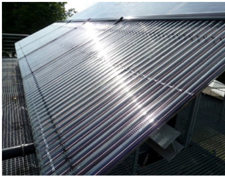
Abb. 108: 13 m 2 Viessmann Vakuumröhren Kollektorfeld mit südlicher Ausrichtung (links), Installation mit Speichersystem, Hydraulikgruppe und Adsorptionskältemaschine (rechts).
