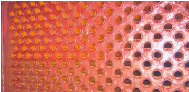
■ Abb. 127: Geöffneter Wärmeübertrager (Rohrbündel) einer Absorptionskältemaschine (vgl. mit Abb. 17) zur Inspektion
