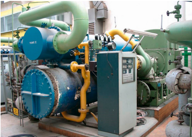
■ Abb. 121: R12-Kaltwassersersatz mit Turboverdichter, Baujahr 1973, Betrieb in der zentralen Kälteerzeugung bis 1992
