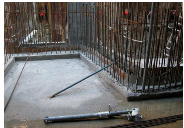
Bild 12: Abdichtung des Sohle-Wand-Anschlusses mit einem unbeschichteten Arbeitsfugenblech
