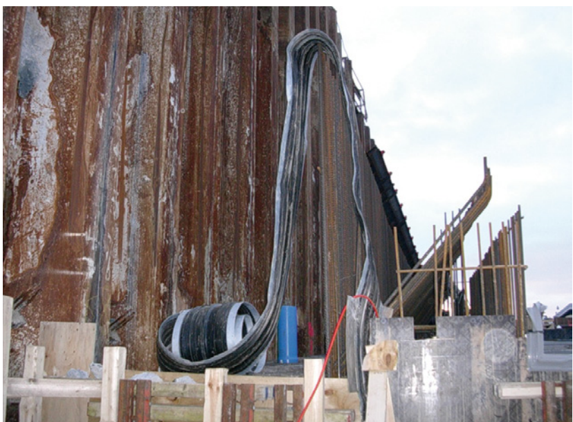
Bild 11: Fachgerechte (linkes Bild) und nicht fachgerechte (rechtes Bild) Verwahrung des Fugenbandes bis zum Betonieren des nächsten Betonierabschnittes
