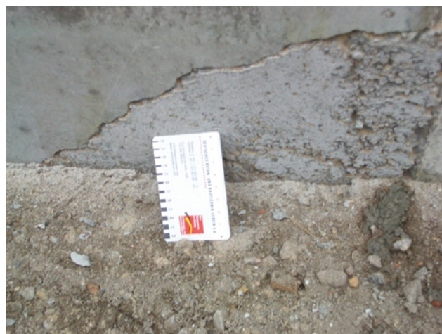
Bild 5: Lagerfuge Halbfertigteile
