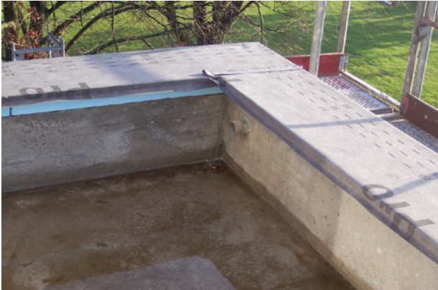
Bild 3: Attika Dachterrasse mit Notüberlauf
