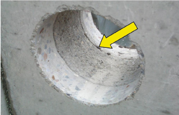
Bild 10: Bohrung durch eine schadhafte Elementwand
