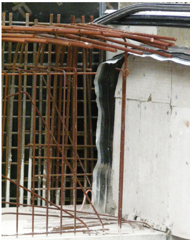
Bild 1: Fugenabdichtung bei einem wasserundurchlässigen Bauwerk aus Beton
