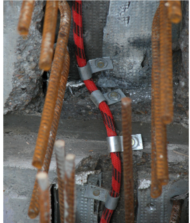
Bild 17: Arbeitsfuge mit einem Injektionsschlauchsystem
