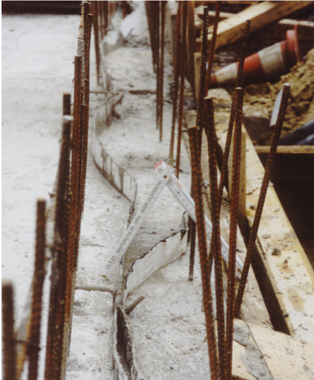
Bild 15: Schlecht ausgeführter Überlappungsstoß
