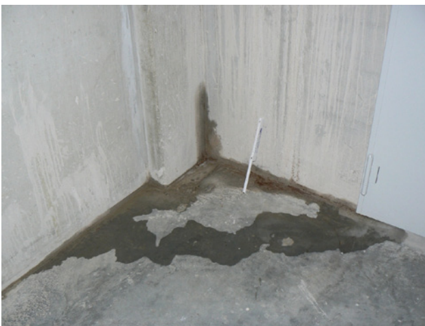
Bild 3: eindringendes Wasser an einer Elementwand
