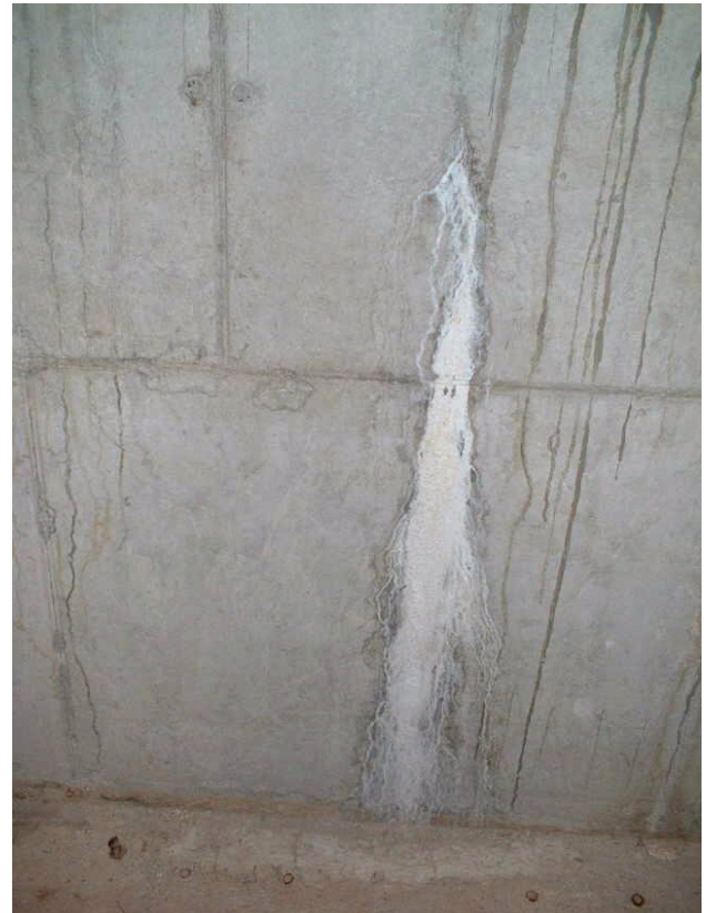
Bild 2: geheilter Riss in der Wand, nicht mehr wasserführend
