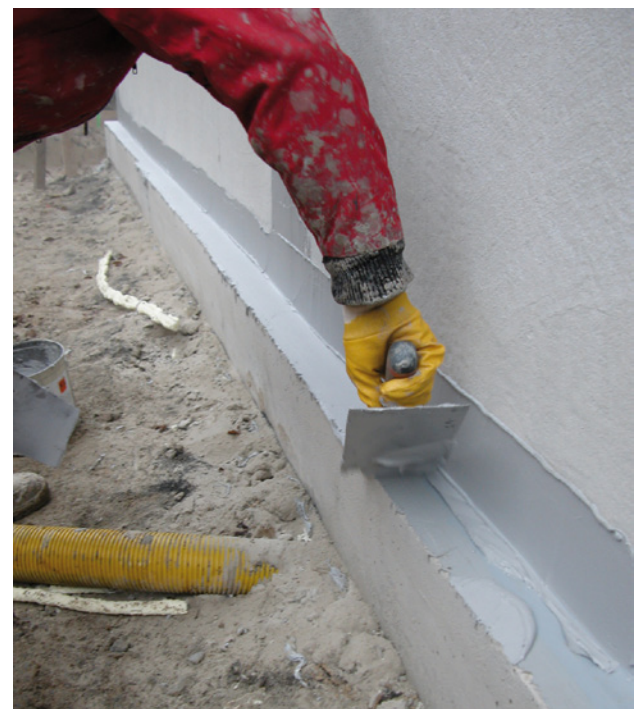
Bild 31: Fugenabdichtung einer Arbeitsfuge mit einem streifenförmigen vollflächig aufgeklebten Fugenabdichtungsband bei einer Elementwand
