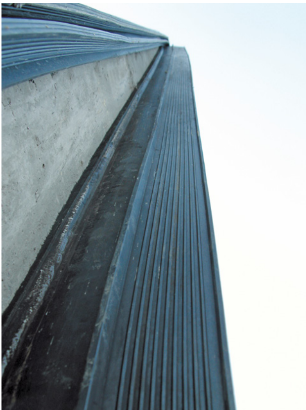
Bild 3: Fugenabschlussband und innenliegendes Fugenband in der Dehnfuge einer Hochwasserschutzwand
