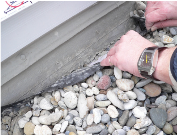
Bild 8: Kritischer Bereich Betonaufkantung für Lichtkuppel und Notausstieg
