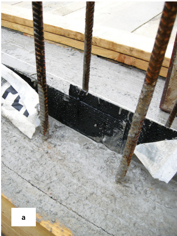
Bild 22: Beispiele für eine fachgerechte (a) und mangelhafte (b) Stoßausbildung bei beschichteten Fugenblechen
