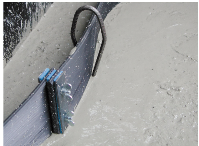
Bild 26: Fachgerechte Stoßausbildung mittels Klemmlaschen mit quellfähiger Zwischenlage
