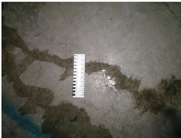
Bild 1: wasserführender Riss in der Bodenplatte
