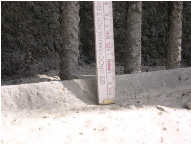
Bild 13: Fehlerhafter Einbau eines unbeschichteten Fugenbleches (h = 30 cm) im Bodenplatte-Wand-Anschluss
