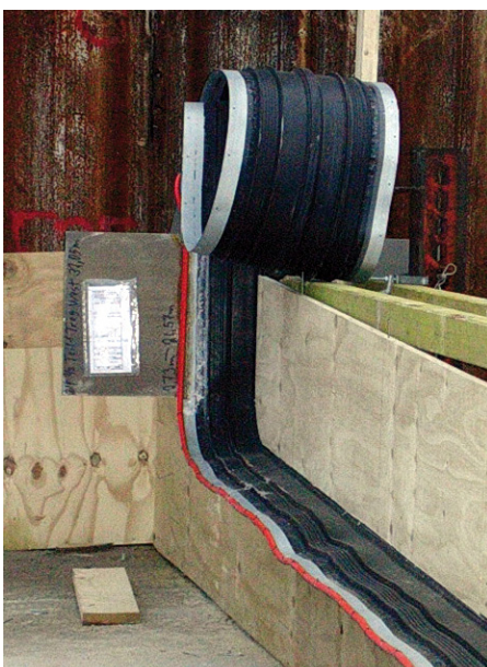
Bild 11: Fachgerechte (linkes Bild) und nicht fachgerechte (rechtes Bild) Verwahrung des Fugenbandes bis zum Betonieren des nächsten Betonierabschnittes
