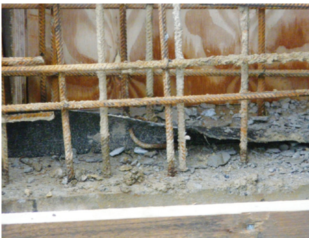
Bild 23: Umgeknicktes beschichtetes Fugenblech in einer verschmutzten Arbeitsfuge
