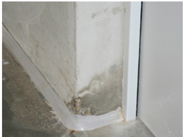
Bild 4: Stirnseite einer Elementwand, nach versuchter innen liegender Abdichtung
