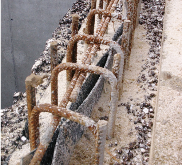
Bild 27: Nicht fachgerechte Stoßausbildung durch Überlappung von Kombi-Arbeitsfugenbändern
