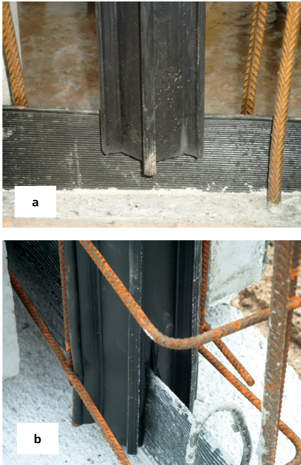
Bild 35: Fachgerecht (a) und falsch (b) ausgeführter Fußpunkt beim Dichtrohr
