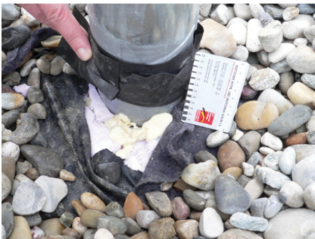
Bild 7: Kritischer Bereich der Rohrdurchführung
