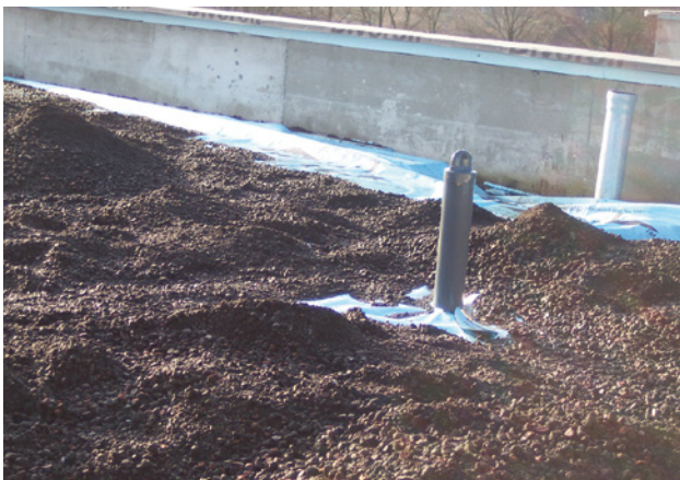
Bild 5: Dachvlies mit Trennvlies und teilweise ausgeführter Bekiesung
