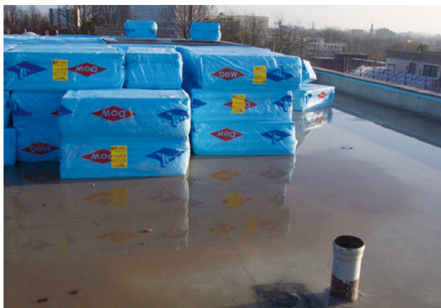
Bild 2: Geflutete Dachfläche vor Aufbringung der Dämmung
