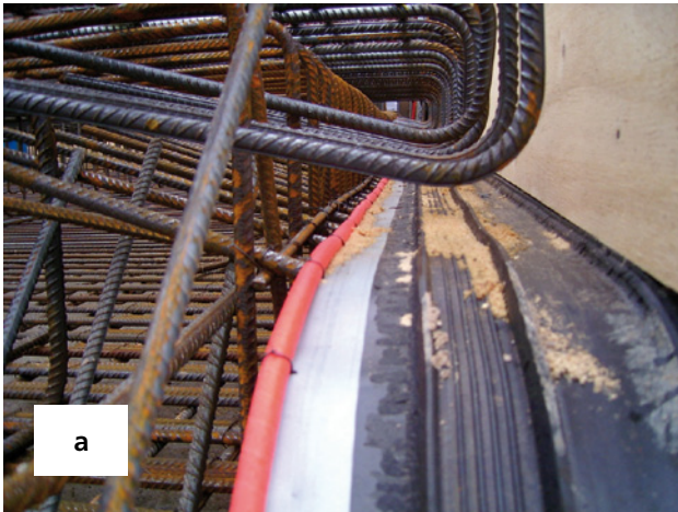
Bild 10: v-förmiges Verlegen von innenliegenden Fugenbändern in horizontalen und leicht geneigten Bauteilen
