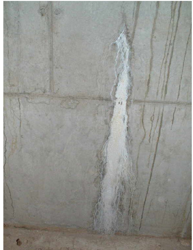
Bild 4: Calciumcarbonatfahne nach Selbstheilung
