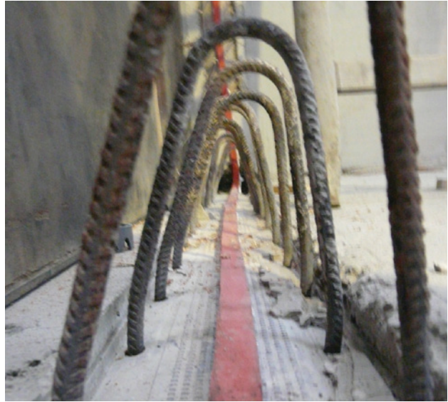
Bild 28: Arbeitsfuge mit quellfähiger Fugeneinlage
