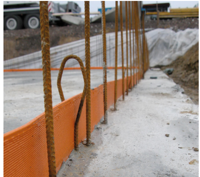
Bild 25: Kombi Arbeitsfugenband KAB auf der obersten Sohlbewehrung nach dem Betonieren der Bodenplatte
