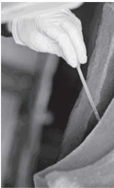
Partielle Festigung mit KSE (Abb. 85)
