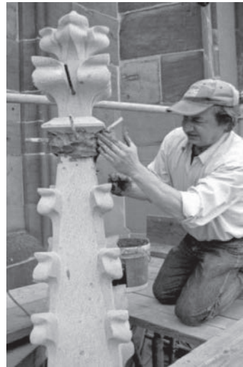
Vorarbeit für den Bleiverguss (Abb. 89)
