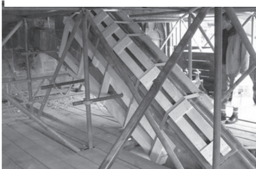
„Korsett“ am Strebebogen (Abb. 94)
