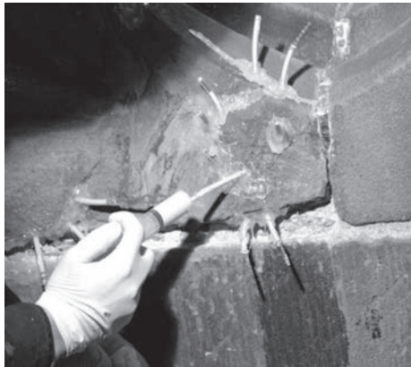
Verfüllung von Hohlräumen mit Silikatkleber (Abb. 87)
