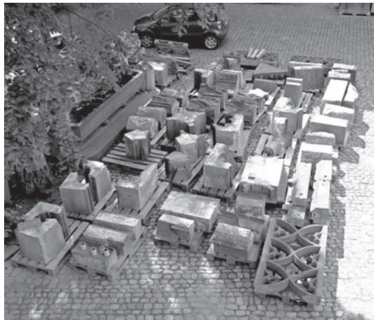
Zerlegter Aufsatz des Chorstrebepfeilers 13/14 Süd im Hof der Schoferstr. 4 (Abb. 66)
