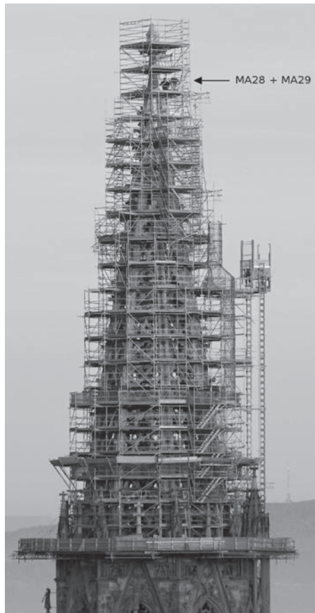
Der Turmhelm 2007 von Osten her mit Fangboden, Aufzug und Gerüst (Abb. 101)
