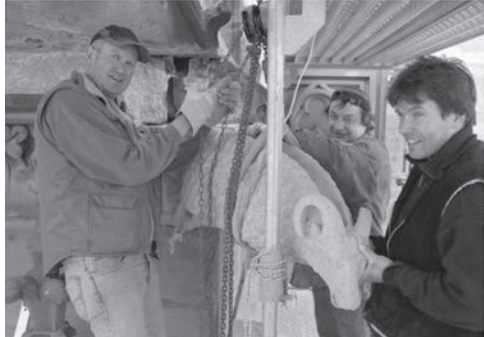
Versetzen eines neuen Wasserspeiers (Abb. 90)
