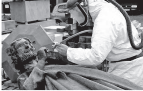
Mikro-Strahlen mit Glaspudermehl (Abb. 84)
