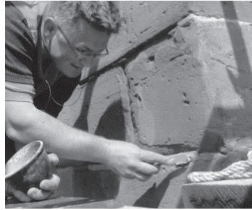
Verfugarbeiten (Abb. 88)
