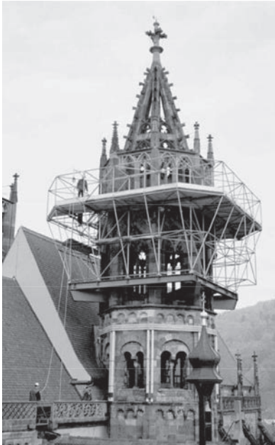
Einrüstung des südl. Hahnenturms 2002 (Abb. 98)
