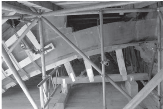
Unterfang-Konstruktion am Strebebogen (Abb. 93)
