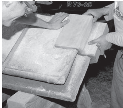
Einpassen einer Vierung (Abb. 67)
