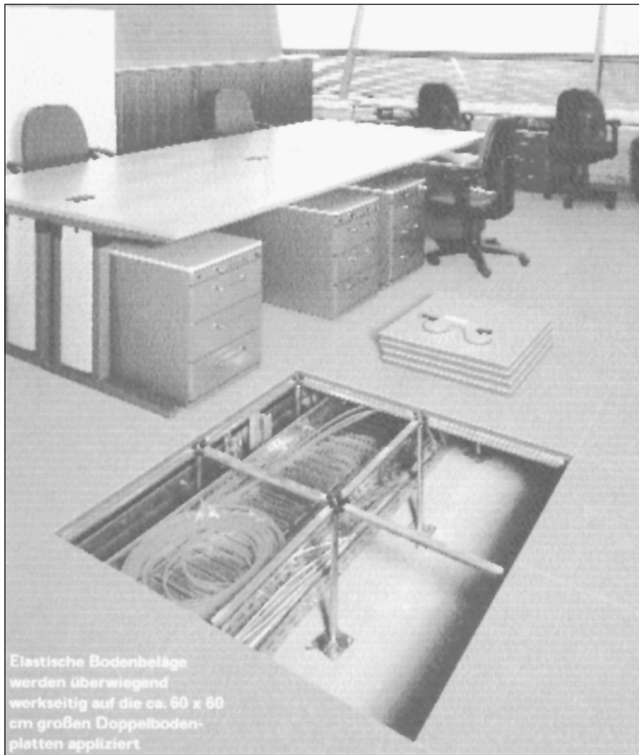
Abb. 6-4: Beispiel Doppelboden [7]
