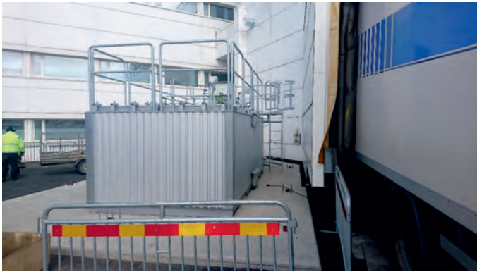
Bild 5: Elektrisch betriebene RTO (Baugröße 7.500 m 3 /h; Anwendung: Pharmabranche; Quelle: MEGTEC Systems AB, Göteborg)
