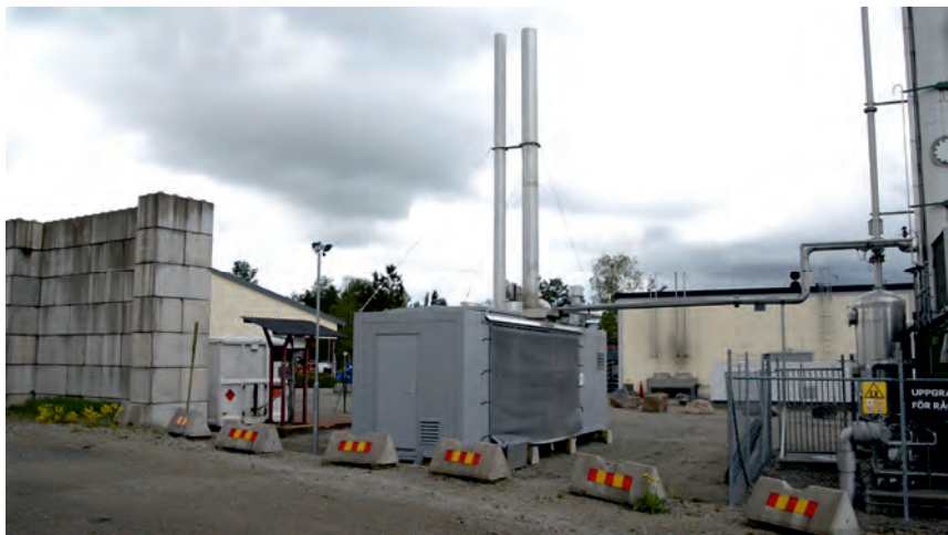
Bild 7: Realisierte Anlage einer elektrisch beheizten RTO mit Wärmeauskopplung auf Gotland, Schweden (Quelle: MEGTEC Systems AB)
