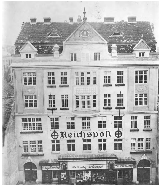
Abb. 47: Das neue Redaktions- und Verlagsgebäude der Tageszeitung Reichspost in der Strozzigasse 8 in Wien um 1927. Quelle: Archiv der Herold Druck und Verlag GmbH (Wien).
