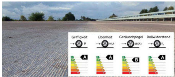
Bild 15: Fahrbahnoberfläche „Texturgrinding Typ S 2,4 / 2,2“ mit Effizienzklassen der Performanceindizes (Oberflächenlabel)
